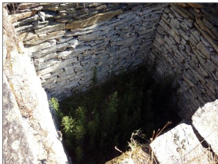
Figura 3.18 – P4, Poço nº 43.
