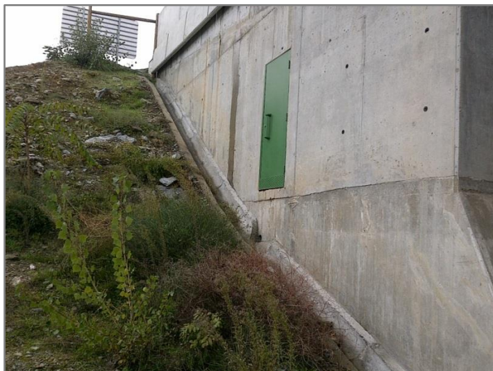
Figura 3.11 – Ponto de descarga das águas de escorrência da plataforma, localizado junto ao Rio Tua, ao km 10+056.
