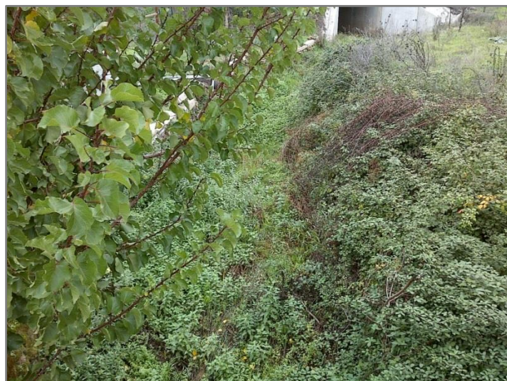
Figura 3.8 – Ribeira de Vale Pereiro, a jusante da via, localizado ao km 15+855.
