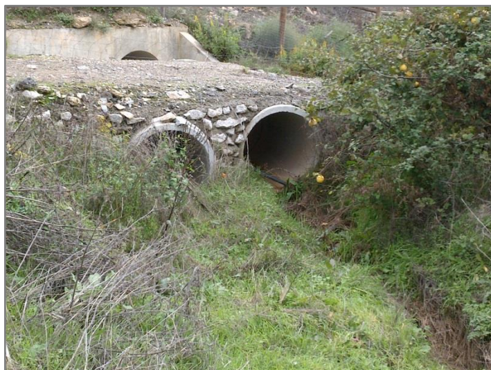
Figura 3.6 – Afluente da Ribeira de Carvalhais, a jusante da via, localizado ao km 13+622.
