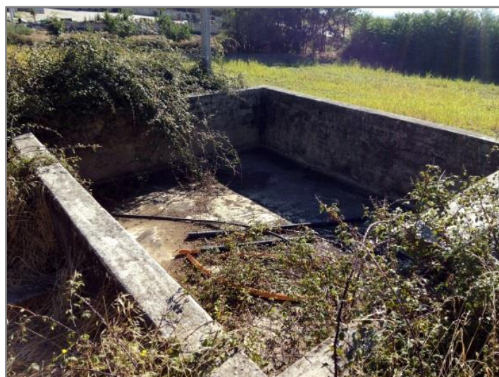
Figura 3.16 – P2, Tanque nº14.
