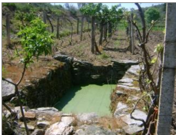
Figura 3.19 – P6, Poço nº 59.
