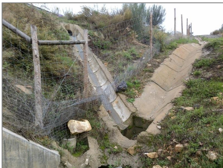
Figura 3.10 – Ponto de descarga das águas de escorrência da plataforma, localizado junto à Ribeira de Orelhão, ao km 0+530.
