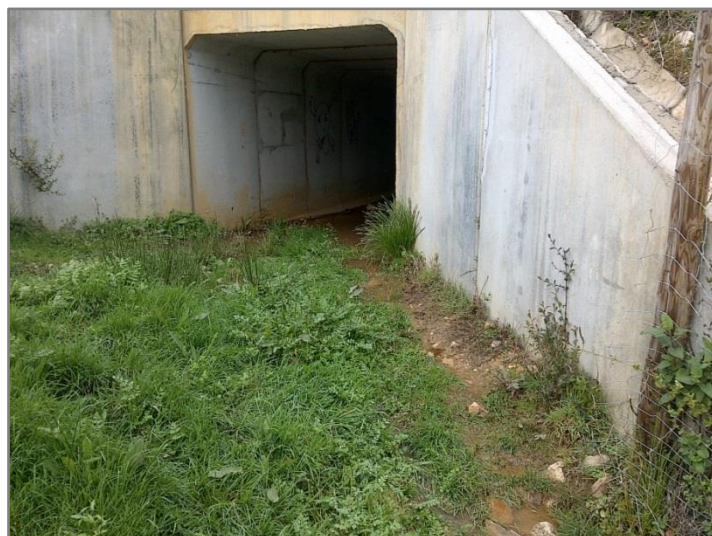
Figura 3.1 – Ribeira de Orelhão, a montante da via, localizado ao km 0+566.
