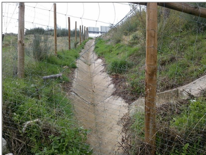
Figura 3.9 – Ponto de descarga das águas de escorrência da plataforma, localizado junto à Ribeira de Orelhão, ao km 0+511.
