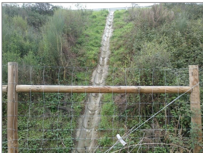
Figura 3.12 – Ponto de descarga das águas de escorrência da plataforma, localizado junto ao Afluente da Ribeira de Carvalhais, ao km 13+619.
