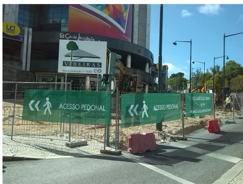
Figura 4 – Vedação e delimitação da zona de trabalhos.
