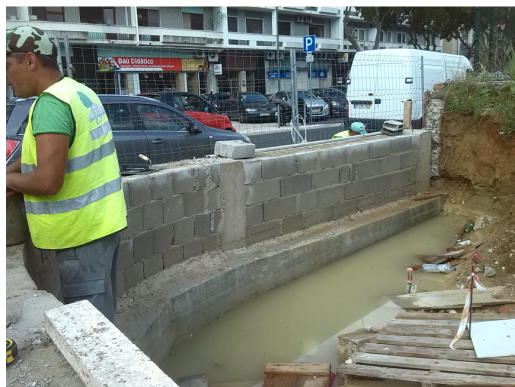
Figura 2 – Execução de murete em alvenaria.
