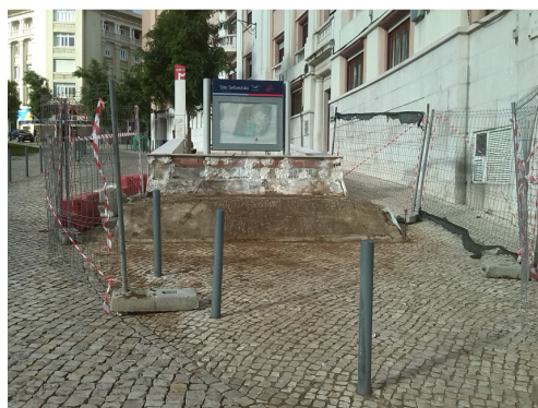
Figura 11 – Demolição de revestimentos existentes.
