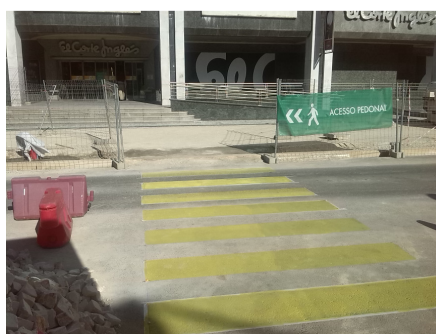
Figura 15 – Manutenção de caminhos pedonais nas zonas adjacentes à obra.
