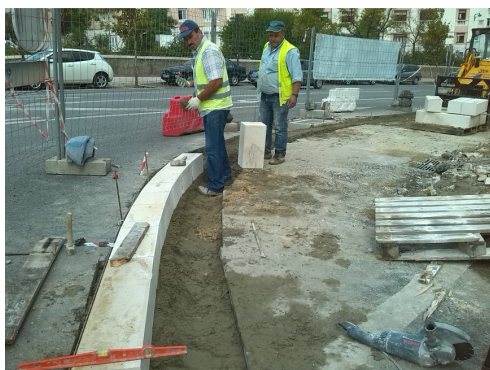
Figura 6 – Execução de lancil.
