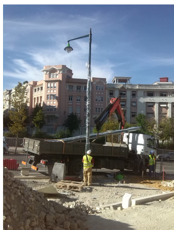
Figura 8 – Execução de iluminação pública.
