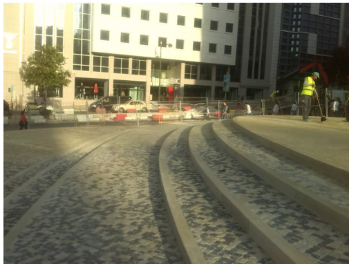
Figura 17 – Limpeza dos acessos adjacentes à área afecta à obra.
