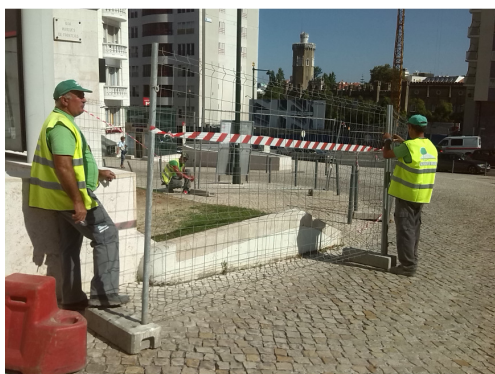
Figura 10 – Vedação e delimitação da zona de trabalhos.
