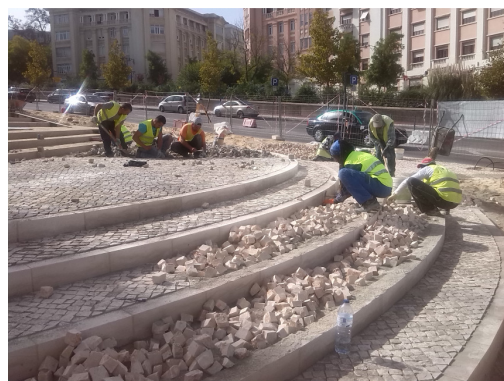
Figura 7 – Execução de calçada.
