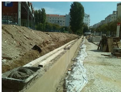
Figura 3 – Execução de reboco.
