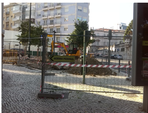
Figura 1 – Sondagem para instalação de caixa.
