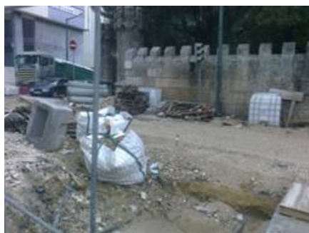
Figura 14 – Acondicionamento de sacos de cimento e plástico em big-bags.
