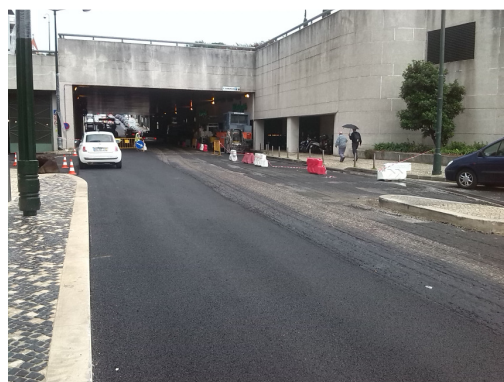
Figura 5 – Reposição de betuminoso.
