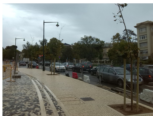
Figura 7 – Execução de plantações.
