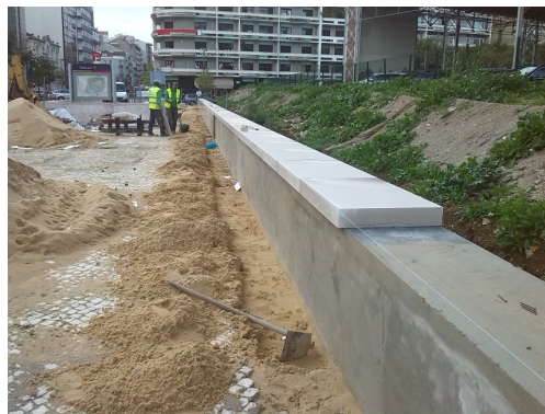
Figura 9 – Execução de cantarias.
