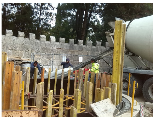
Figura 3 – Execução de betão armado no Poço de Ventilação.
