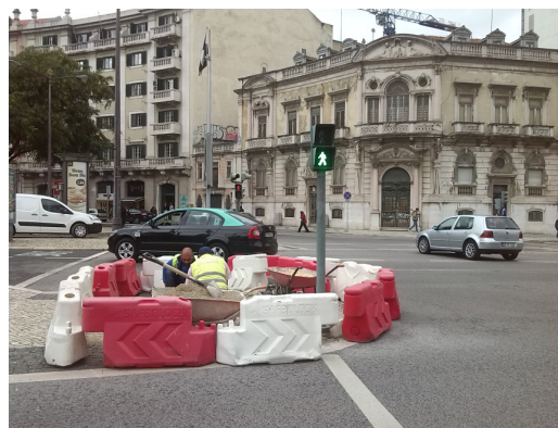
Figura 12 – Execução de calçada.
