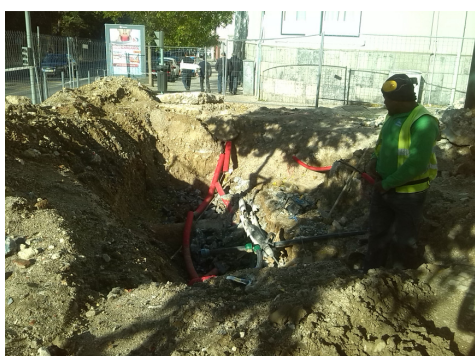
Figura 1 – Escavação para execução de caixa em betão.
