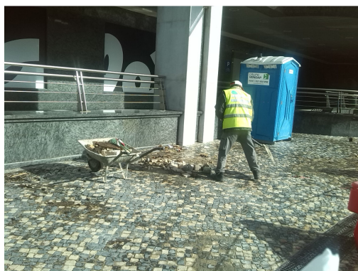
Figura 17 – Limpeza dos acessos adjacentes à área afeta à obra.
