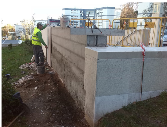
Figura 13 – Execução de parede em alvenaria.
