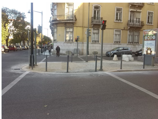
Figura 11 – Levantamento de calçada e lancil e respetiva execução.
