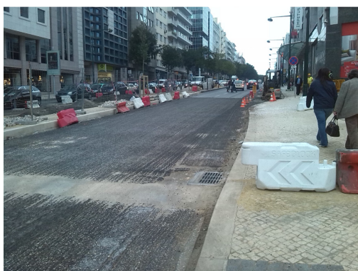
Figura 4 – Fresagem de betuminoso.
