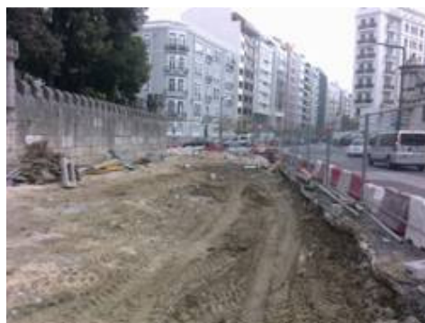
Figura 20 – Limpeza geral na Zona 1.
