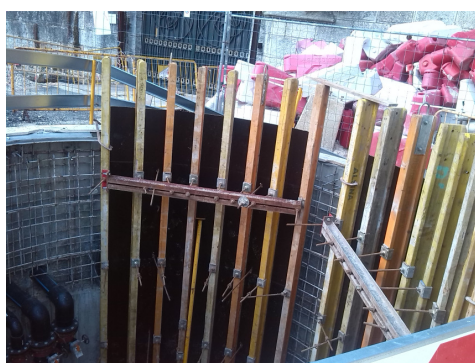
Figura 2 – Execução de cofragem no Poço de Ventilação.
