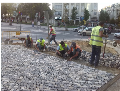
Figura 6 – Execução de calçada.
