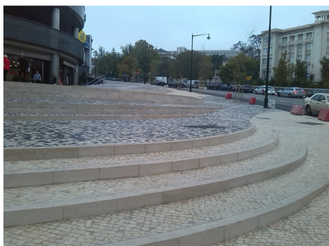
Figura 19 – Limpeza geral na Zona 2.
