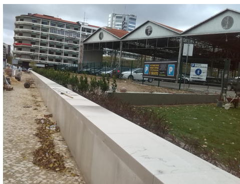
Figura 10 – Execução de plantações.
