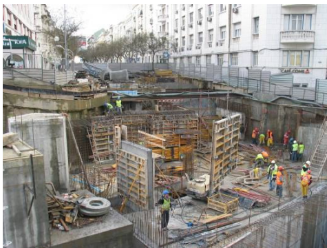
Fotografia 8: Aspecto geral dos trabalhos na Fase 5.
