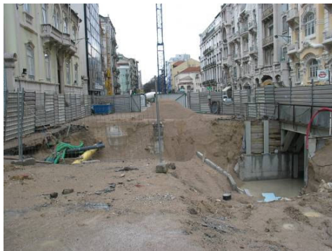
Fotografia 3: Aspecto geral dos trabalhos de reposição de superfície na Av. Duque d'Ávila.
