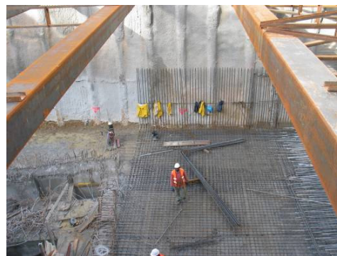
Fotografia 6: Montagem de armaduras no Acesso Nascente.
