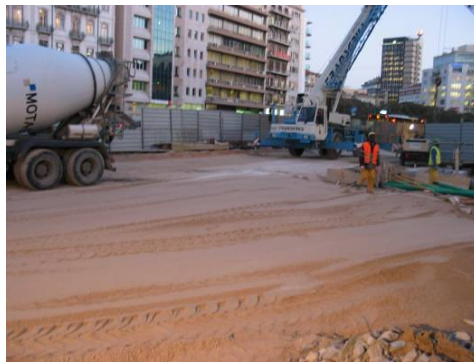
Fotografia 1: Aspecto geral dos trabalhos no Corpo A.
