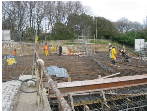
Fotografia 11: Execução das estruturas internas do poço.
