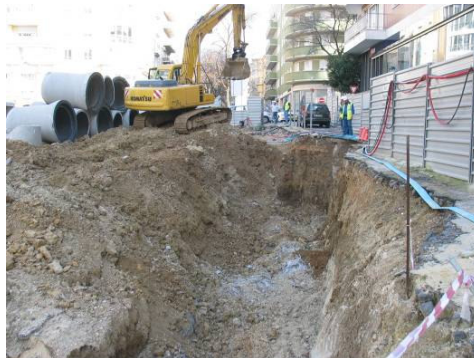
Fotografia 4: Trabalhos associados à reposição do coletor.
