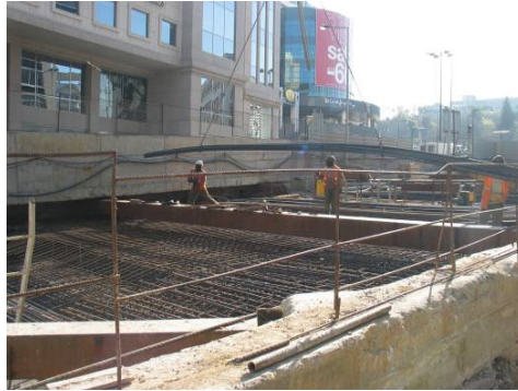
Fotografia 7: Aspecto geral dos trabalhos no Cut and Cover – Zara.
