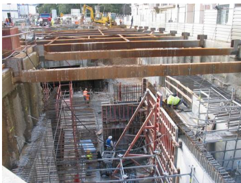
Fotografia 5: Aspecto geral dos trabalhos no Acesso Nascente.
