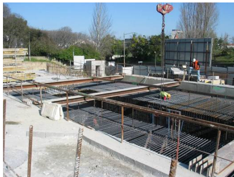
Fotografia 12: Montagem de armaduras na laje de cobertura da sala dos ventiladores.
