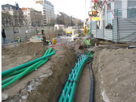
Fotografia 2: Aspecto geral dos trabalhos nos acessos ponte.
