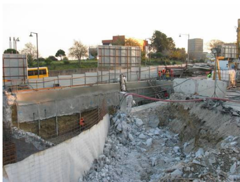
Fotografia 11: Aspecto geral dos trabalhos na sala dos ventiladores.
