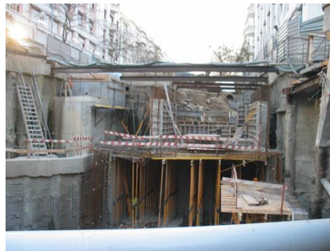
Fotografia 8: Montagem da cofragem das estruturas internas.
