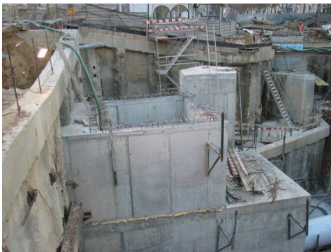
Fotografia 7: Execução das novas caixas de visita.
