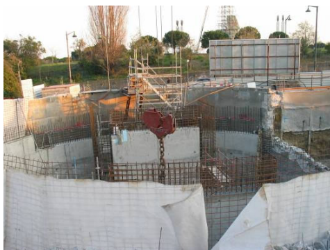
Fotografia 10: Execução das estruturas internas do poço.
