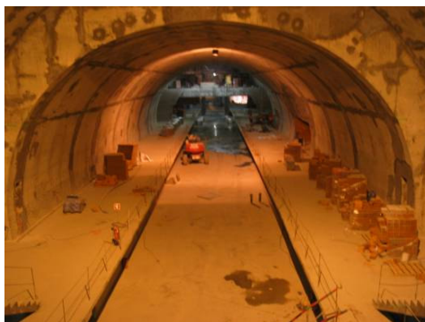
Fotografia 3: Aspecto geral dos trabalhos no interior da Estação S. Sebastião II.
