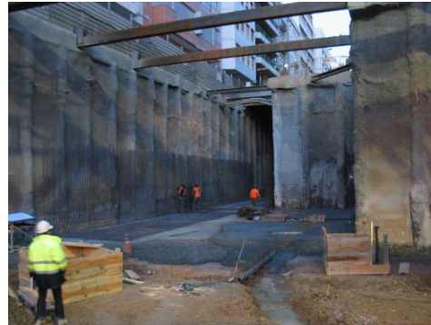
Fotografia 5: Aspecto geral dos trabalhos no Acesso Nascente.
