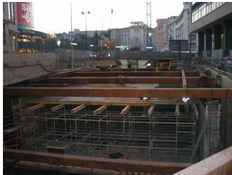
Fotografia 6: Aspecto geral dos trabalhos no Cut and Cover – Zara.
