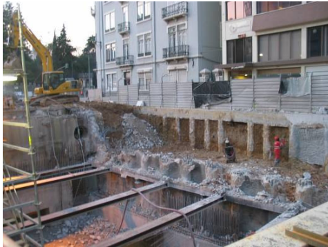
Fotografia 4: Demolição de estacas no Acesso Nascente.
