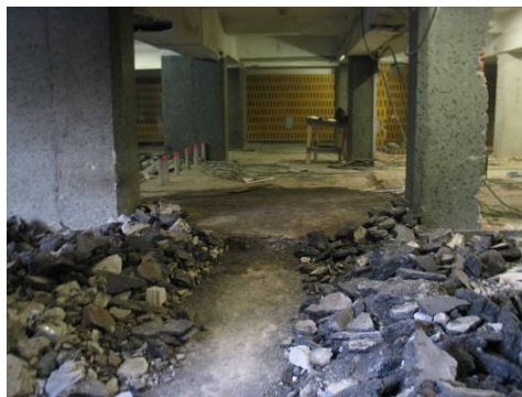
Fotografia 9: Aspecto geral dos trabalhos de demolição no interior da Estação S. Sebastião I.
