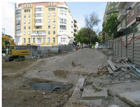
Fotografia 3: Aspecto geral dos trabalhos associados à reposição do colector.
