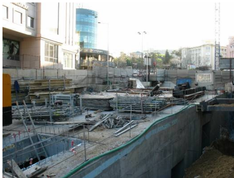
Fotografia 6: Aspecto geral dos trabalhos no Cut and Cover – Zara.
