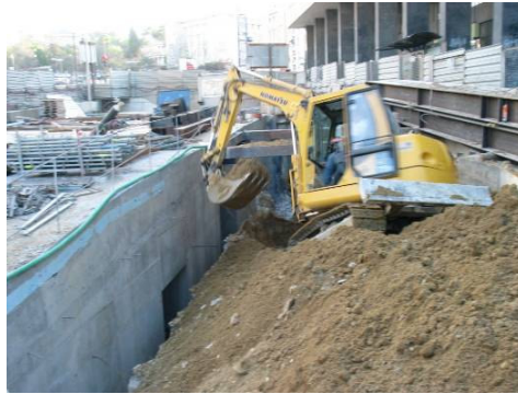
Fotografia 7: Aspecto geral dos trabalhos no Cut and Cover – Zara.
