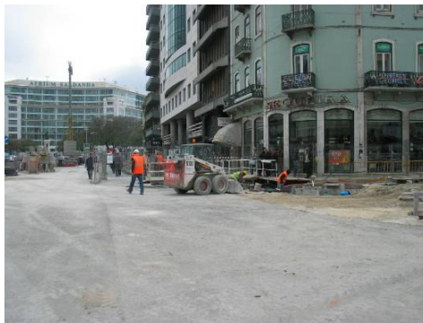
Fotografia 1: Aspecto geral dos trabalhos no Corpo A.
