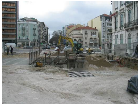
Fotografia 2: Aspecto geral dos trabalhos de reposição de superfície na Av. Duque d'Ávila.
