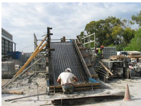
Fotografia 12: Pré-fabricação das escadas de betão armado.
