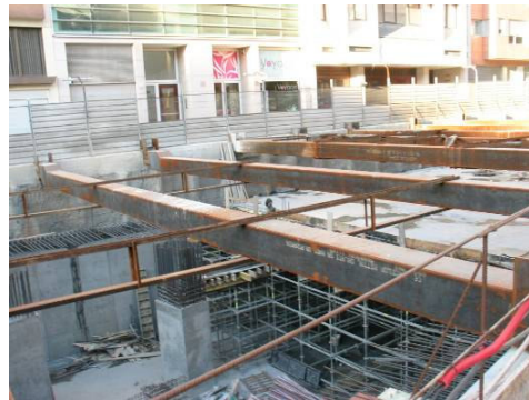
Fotografia 5: Montagem de armaduras no Acesso Nascente.
