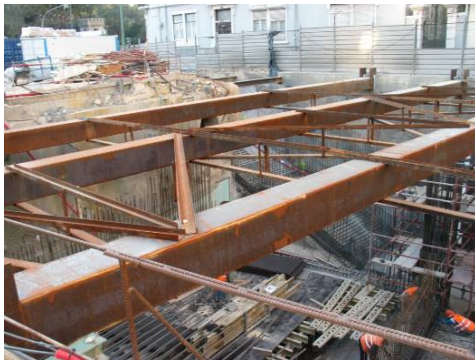
Fotografia 4: Aspecto geral dos trabalhos no Acesso Nascente.
