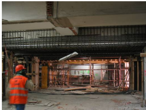
Fotografia 10: Execução das vigas pré-esforçadas no interior da Estação S. Sebastião I.
