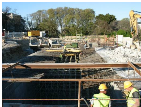
Fotografia 11: Execução das estruturas internas do poço.
