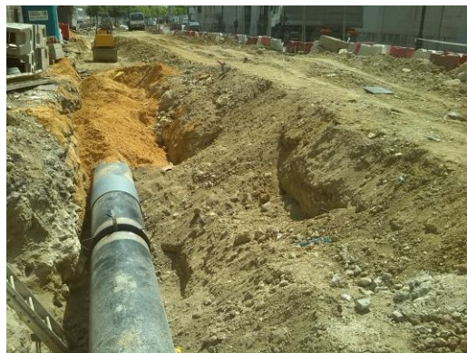
Figura 2 – Substituição de conduta da EPAL.
