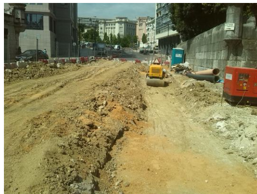
Figura 3 – Compactação de valas.
