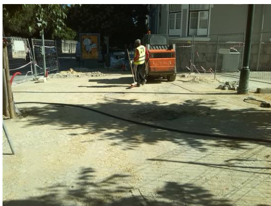
Figura 6 – Execução de pavimento em calçada.
