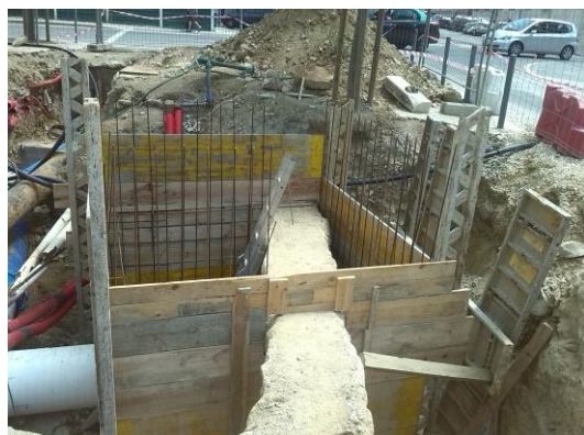
Figura 4 – Trabalhos de armadura e cofragem.
