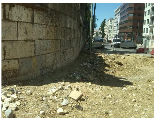
Figura 13 – Limpeza de calçada e terras na zona junto ao muro.
