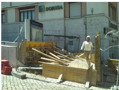
Figura 7 – Trabalhos de cofragem.
