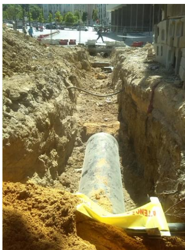
Figura 1 – Trabalhos de escavação de vala.
