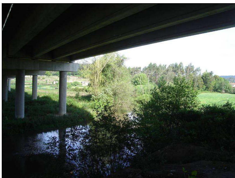
Figura 3.1 – Ponto de recolha 1 – Rio Este, sob o Viaduto 1 – montante.
