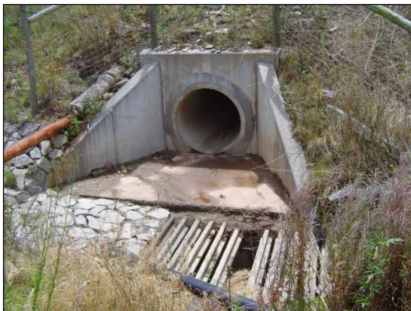
Figura 3.6 – Ponto de recolha 6 – Linha de água restabelecida pela PH 10.2 – jusante.
