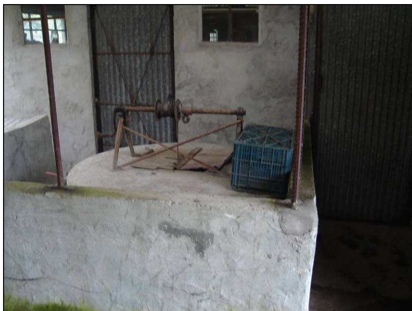
Figura 3.8 – Ponto de recolha 8 – Poço junto ao km 0+550.
