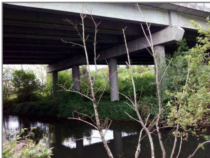
Figura 2 - Ponto de recolha 1 – Rio Este, sob o Viaduto 1 – montante
