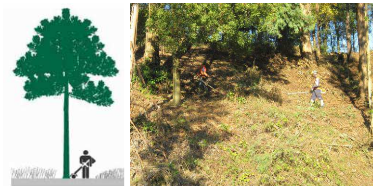
Figura 28 - Limpeza de matos moto-manual
