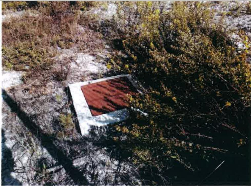
**Figura 11** – Separador de hidrocarbonetos da bacia de retenção do depósito de combustível
