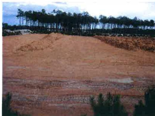
Fotografia 6 - Faixa a Este já decapada superficialmente e com argilas a secar.
