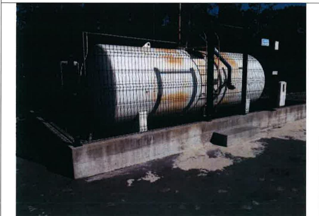
**Figura 10** – Depósito de combustível com bacia de retenção e meios de contenção de eventuais derrames
