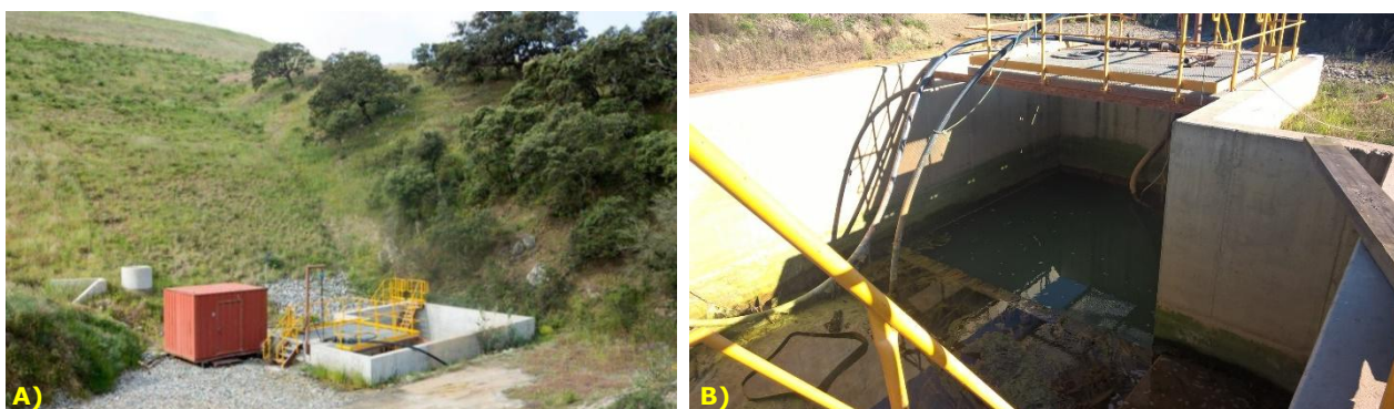
Fig. 11 - Tanque de captação: A) Aspecto geral exterior; B) Aspecto geral do interior.
