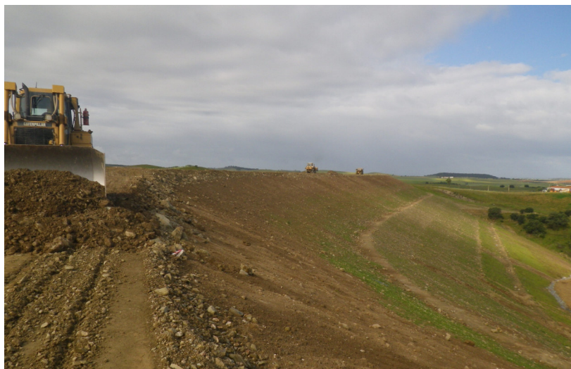
Figura 9- Paredão de jusante em recuperação
