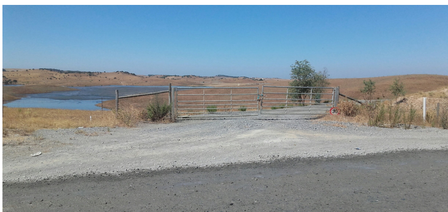
Figura 8- Portão de acesso à instalação de resíduos
