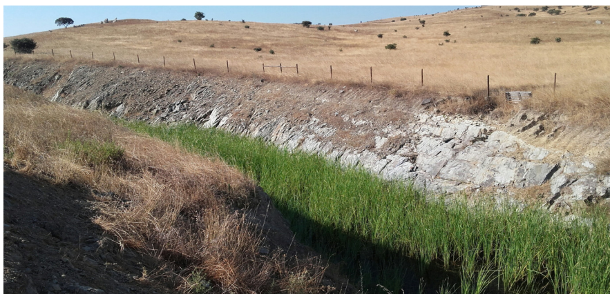
Figura 7- Troço da vala perimetral
