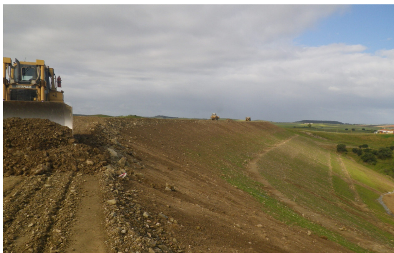
Figura 9- Paredão de jusante em recuperação
