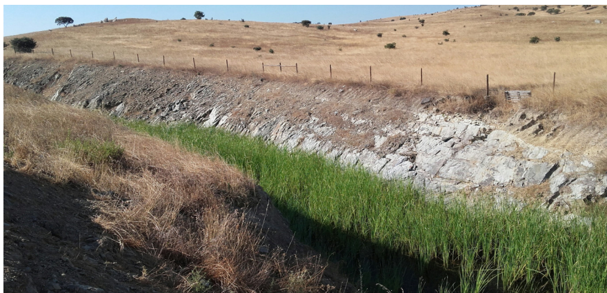
Figura 7- Troço da vala perimetral
