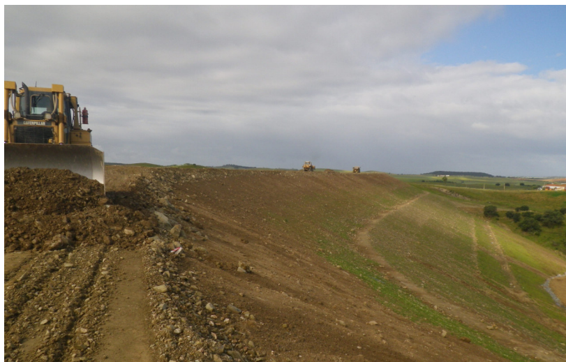
Figura 9- Paredão de jusante em recuperação
