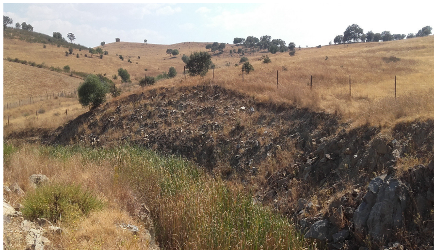
Figura 6- Adoçamento do talude da vala perimetral
