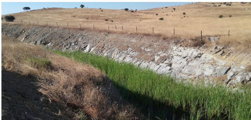
Figura 7- Troço da vala perimetral
