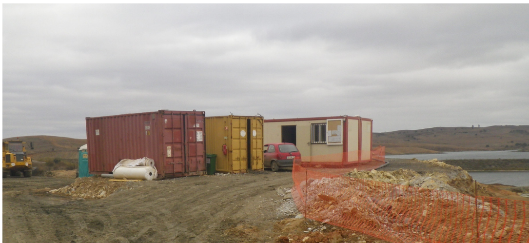
Figura 1- Estaleiro da obra de alteamento da instalação de resíduos “BE-BAC”
