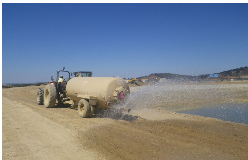
Figura 4- Rega de uma frente de trabalho- instalação de resíduos “BE-BAC”
