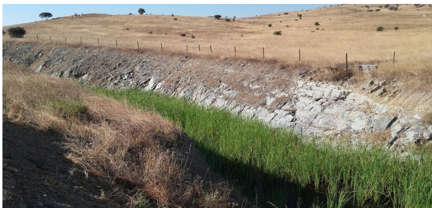
Figura 7- Troço da vala perimetral
