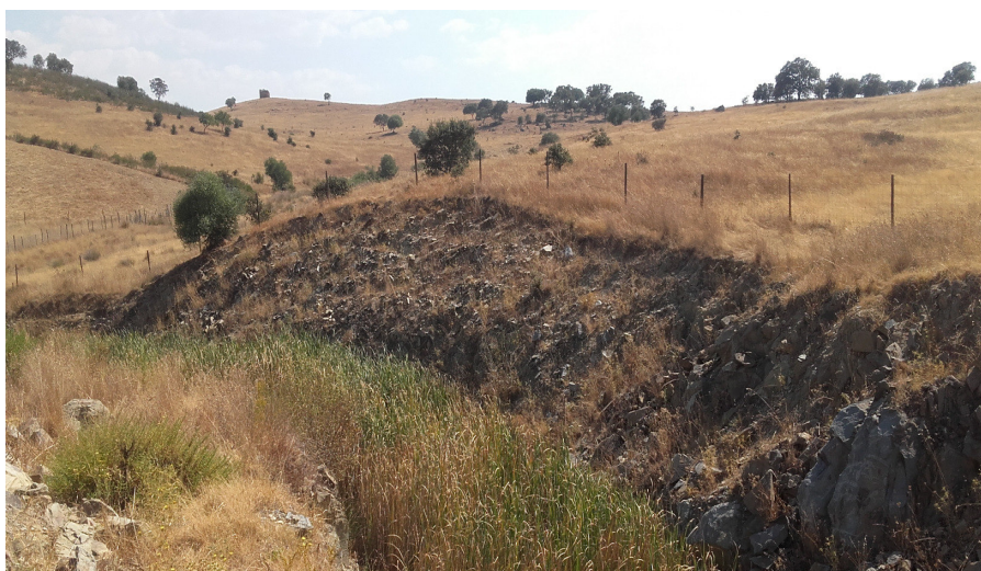
Figura 6- Adoçamento do talude da vala perimetral
