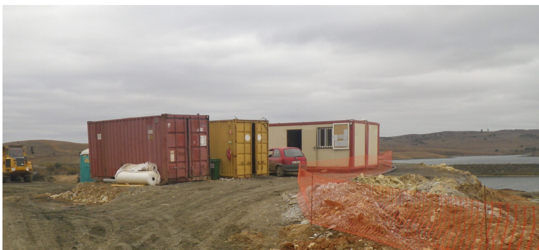
Figura 1- Estaleiro da obra de alteamento da instalação de resíduos “BE-BAC”
