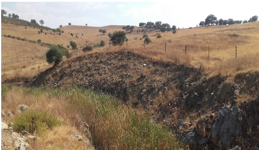
Figura 6- Adoçamento do talude da vala perimetral
