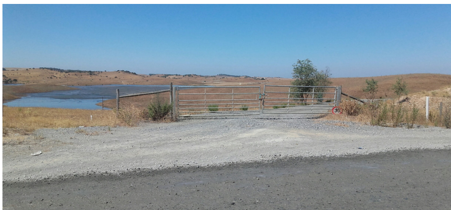
Figura 8- Portão de acesso à instalação de resíduos
