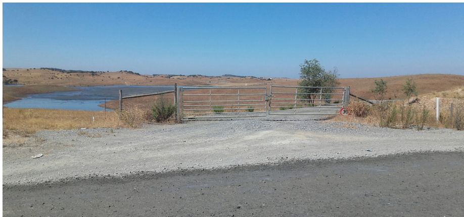
Figura 8- Portão de acesso à instalação de resíduos
