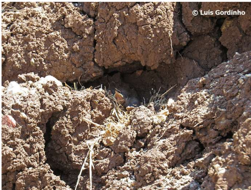
Foto 49. Ninho de Chasco-ruivo ( Oenanthe hispanica ) com duas crias na parede da vala da obra ao PK 0+342 no dia 02-Jul-2015
