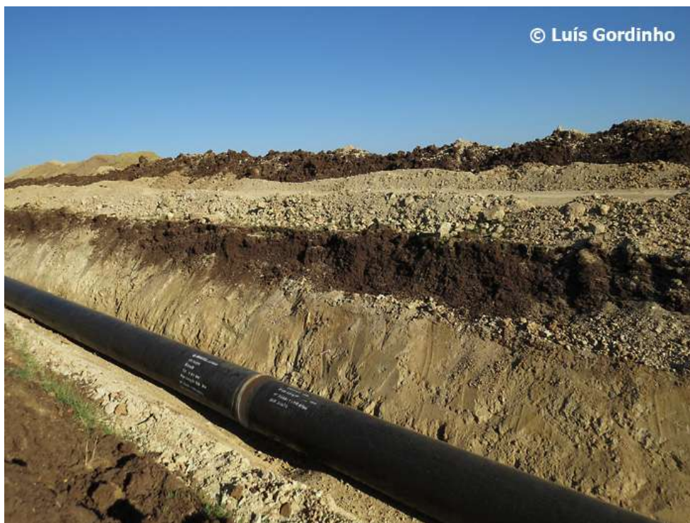
Foto 50. Vala da obra ao PK 0+342 onde se localizou o ninho de Chasco-ruivo, depois dos juvenis voarem e o adutor ser aí instalado, 21-Jul-2015
