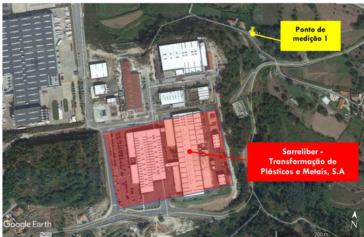
Fotografia 1 – Vista da fonte em avaliação e ponto de medição
