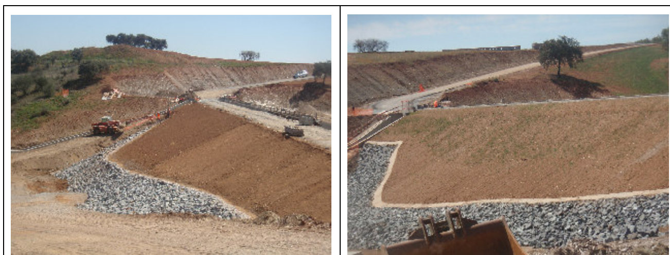
Figuras 41 e 42 – Taludes: Situação Atual
