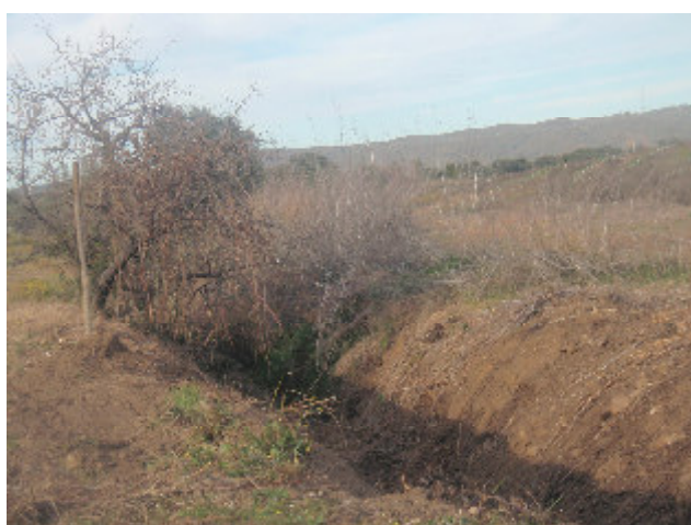
Figura 43 - Limpeza das Linhas de Água
