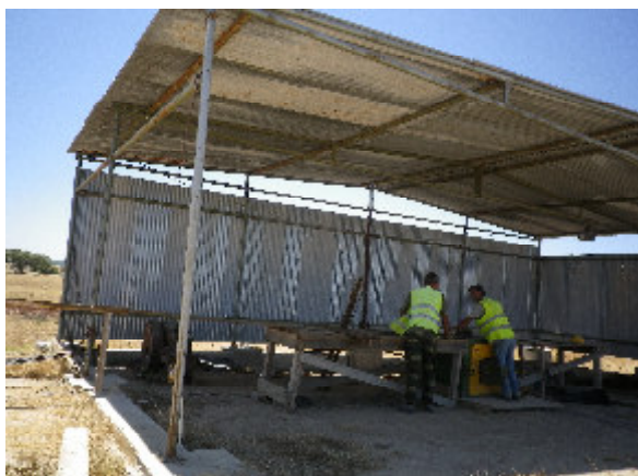
Figura 11 – Área de Apoio à Produção: Zona de Armazenamento e Preparação de Armaduras
