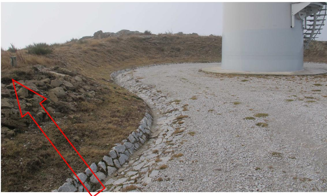
**Fotografia 24 – Vala de Cabos existente junto da ocorrência 3P onde será feita a ligação do aerogerador nº 12.**
