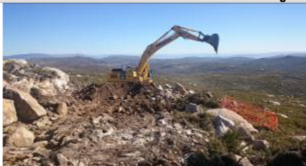
Desmatção e decapagem do acesso ao AG 18
