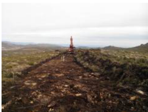
Trabalhos de abertura do acesso ao AG12
