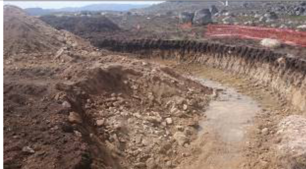
Preparação do cabouco do AG 19
