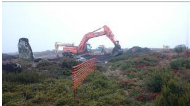
Trabalhos na zona do acesso ao AG 12
