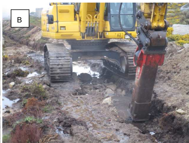
Fotografia 39 - Abertura da vala de cabos do aerogerador n.º 19 de forma a preservar os afloramentos rochosos existentes na envolvente (A e B).
