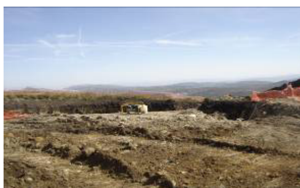
Conclusão do AG 19
