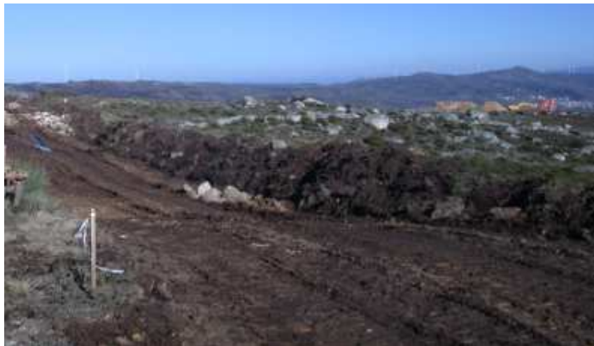
Fotografia 71 - Pargas ao longo do acesso ao aerogerador n.º 12 do Subparque Eólico de Picão.
