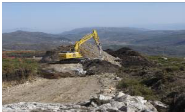
Preparação do acesso ao AG 19
