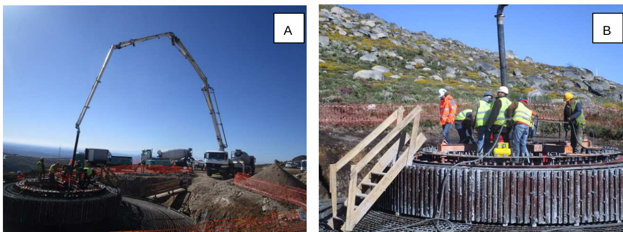
Fotografia 11 - Betonagem da sapata do aerogerador n.º 19.
