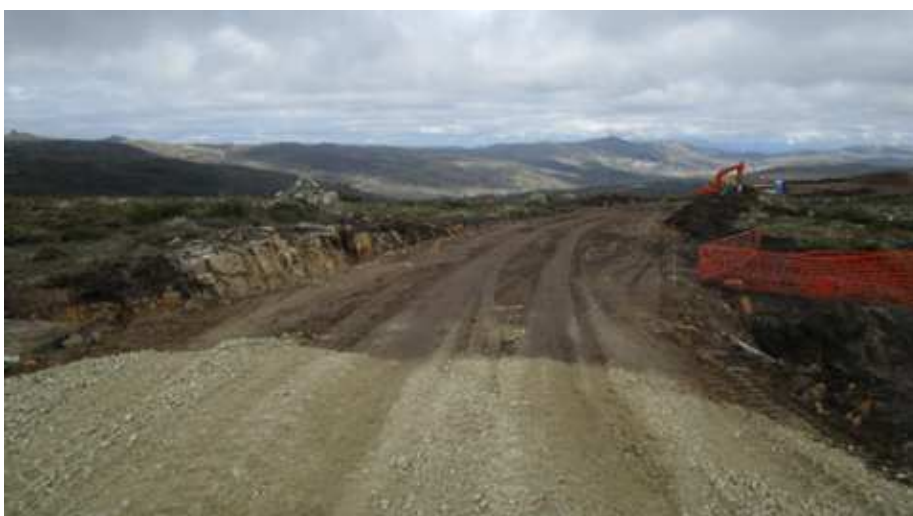
Fotografia 16 - Colocação de tout-venant no acesso ao aerogerador n.º 12.
