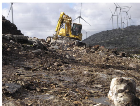
Abertura de Acesso ao AG30
