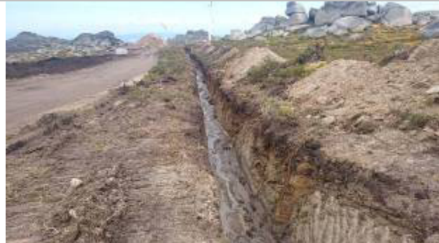
Aterro vala de cabo (AG 19)
