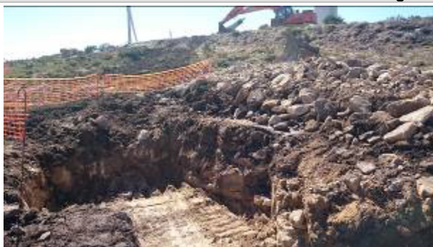
Vala de cabos
