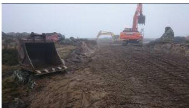
Trabalhos na zona do acesso ao AG 12
