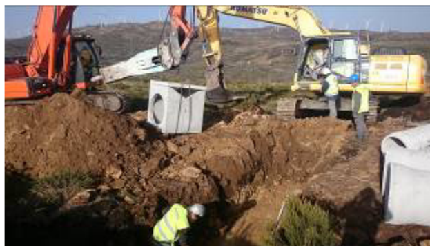
Trabalhos na zona do acesso ao AG 12: passagem hidráulica
