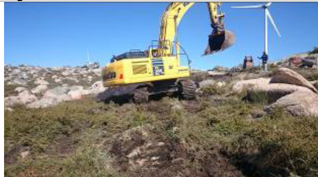
Desmatção e dcapagem do acesso ao AG 18
