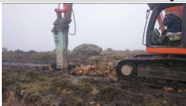
Vala de cabos
