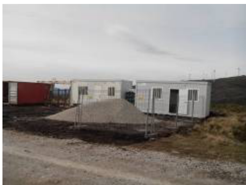
Instalação de estaleiro
