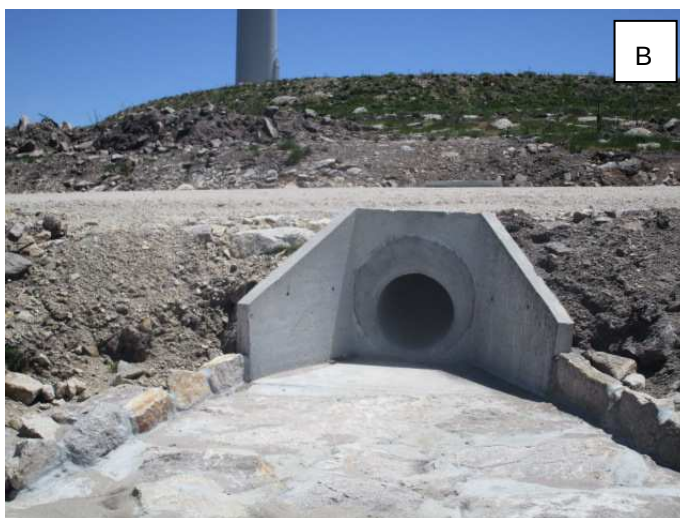
Fotografia 44 - Revestimento com pedra argamassada da saída da passagem hidráulica.
