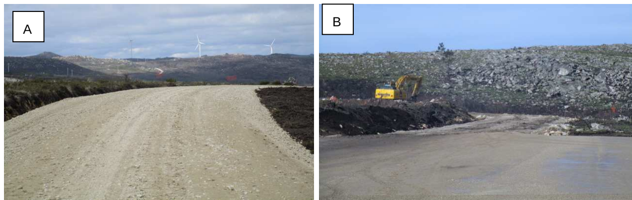
Fotografia 41 – Acesso (A) e plataforma do aerogerador (B) após aplicação de uma camada de tout-venant .
