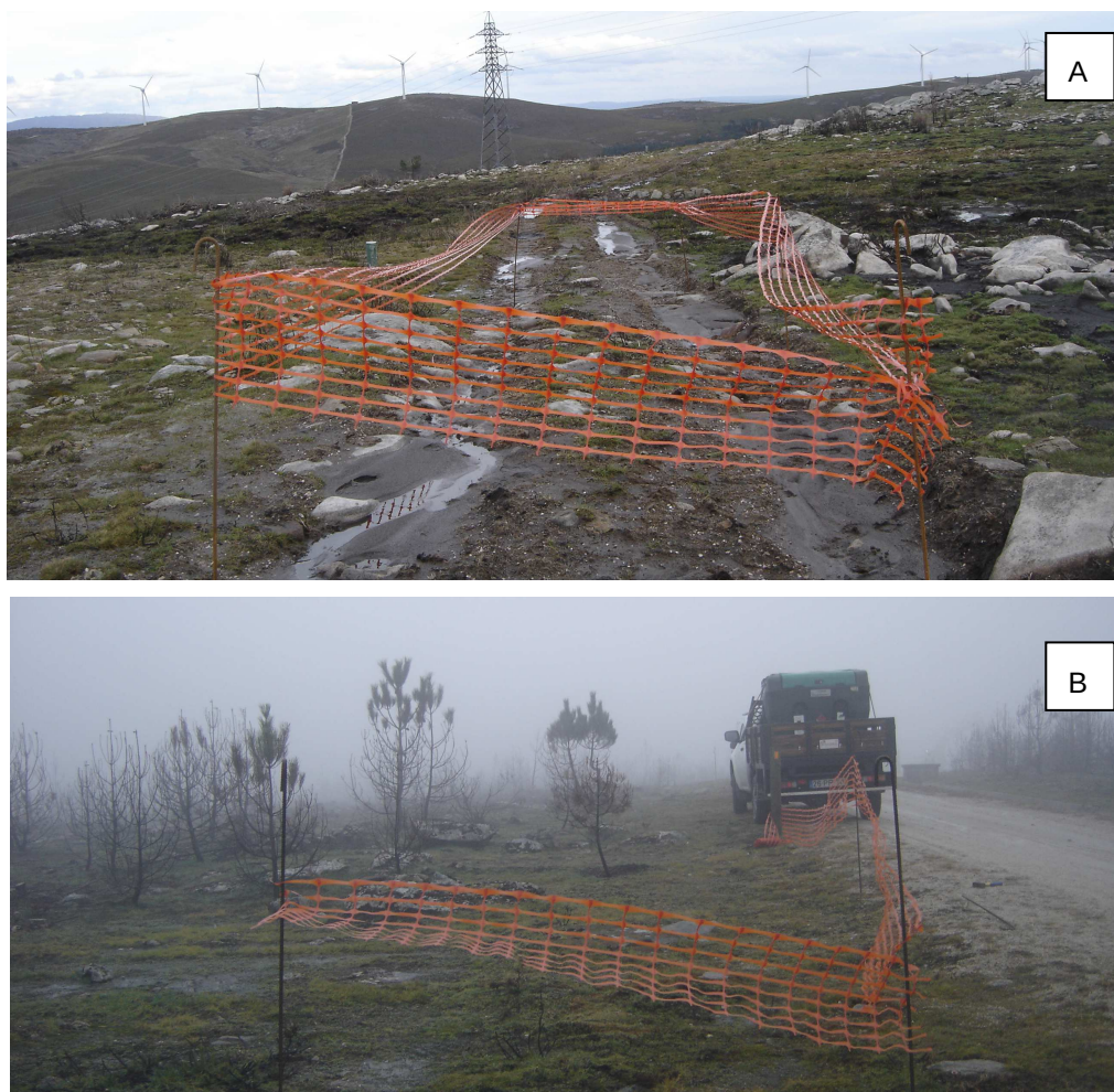
Fotografia 67 – Ocorrência n.º 1 M - Campo de Eirós (Via), na proximidade do novo acesso a construir (A e B).
