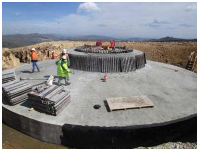
Fotografia 20 - Pintura da sapata do aerogerador n.º 12 do Subparque Eólico de Picão.
