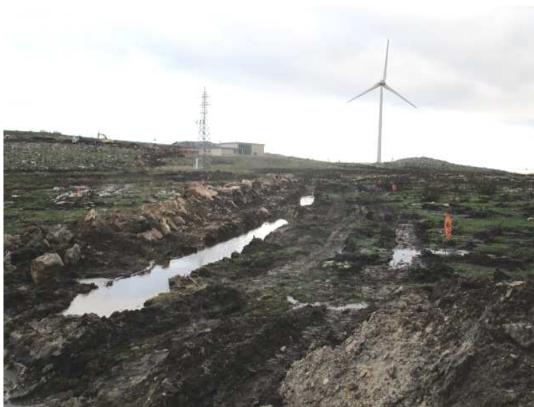
Fotografia 25 – Abertura da Vala de Cabos no Subparque Eólico da Arada – Núcleo de Manhouce, em local previamente balizado.
