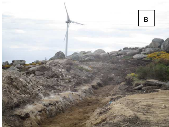
Fotografia 7 – Colocação dos cabos na vala aberta (A e B).
