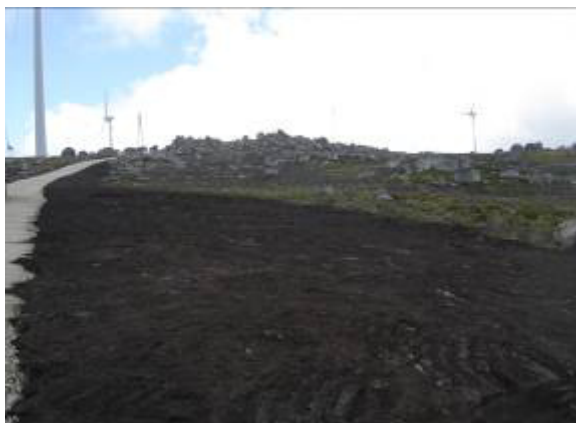
Aterro vala de cabos
