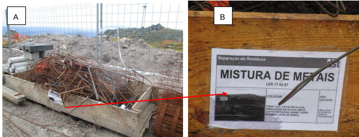
Fotografia 74 – Armazenamento de sobras de metais no estaleiro.
