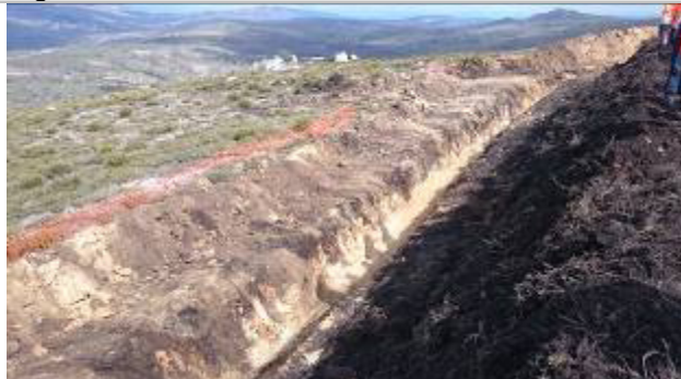
Vala de cabos
