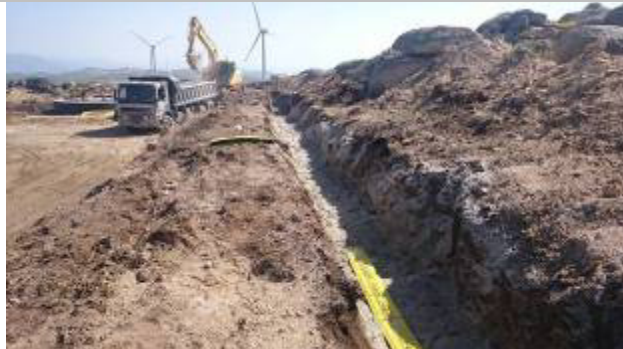
Aterro vala de cabos (AG 19)
