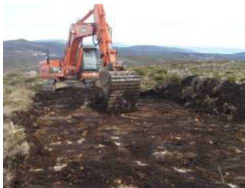
Trabalhos de abertura do acesso ao AG12
