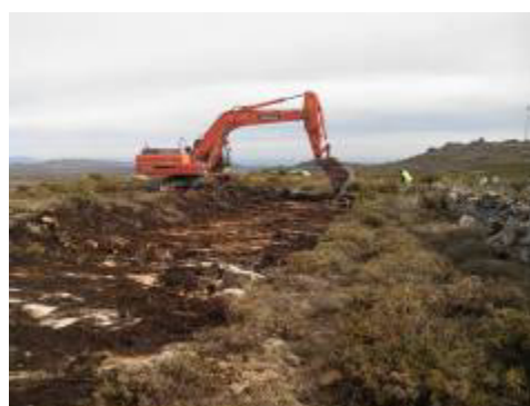
Abertura do acesso ao AG12 (junto a plataforma)
