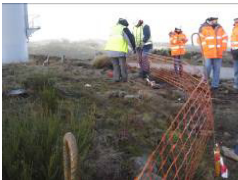
Vedação e sinalização da Oc.3P
