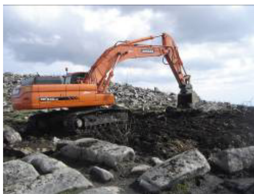
Continuação dos trabalhos
