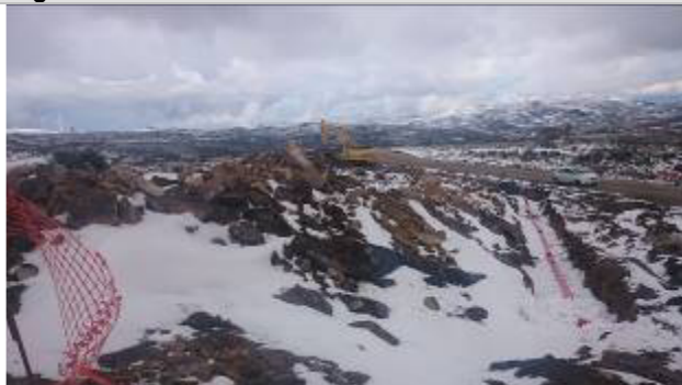
Aterro da vala de cabos do acesso ao AG 12
