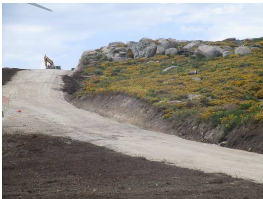
Fotografia 5 – Aspeto final do acesso ao aerogerador n.º 18 após colocação da 1ª camada de tout-venant e após requalificação das bermas intervencionadas.
