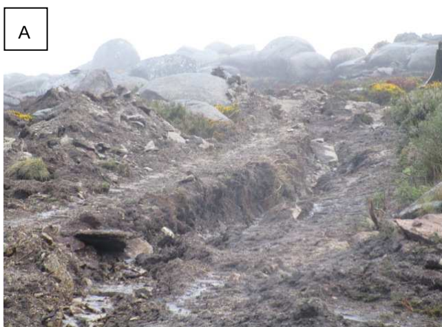
Fotografia 39 - Abertura da vala de cabos do aerogerador n.º 19 de forma a preservar os afloramentos rochosos existentes na envolvente (A e B).
