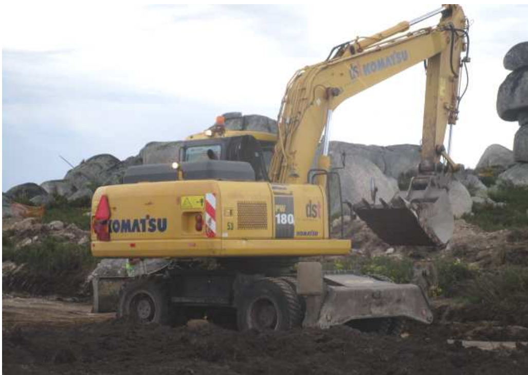
Fotografia 8 – Requalificação ambiental da vala de cabos.
