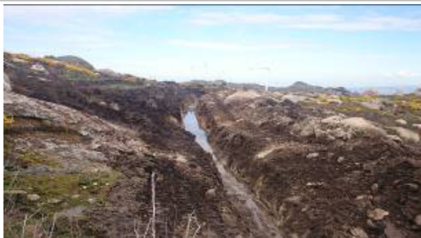
Aterro vala de cabos (AG 19)
