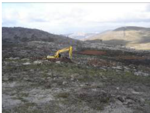
Vista geral da abertura de Acesso ao AG30
