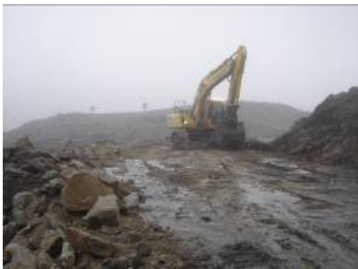
Continuação dos trabalhos no acesso ao Ag30
