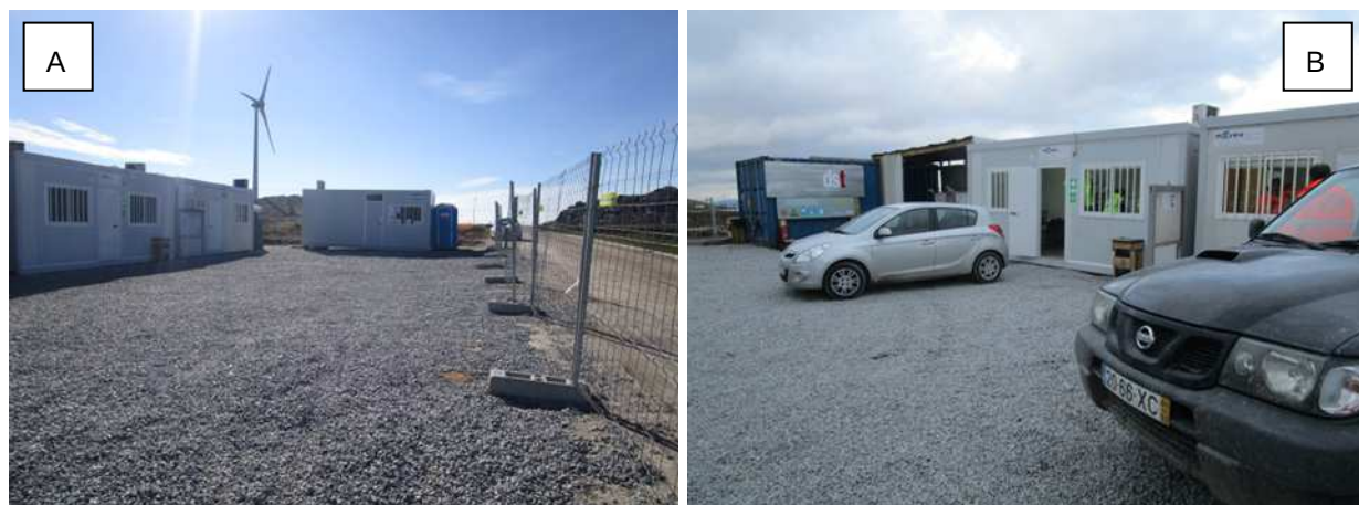
Fotografia 22 - Zona de Estaleiro no Subparque Eólico da Arada – Núcleo de Manhouce, vista geral após a instalação (A e B).
