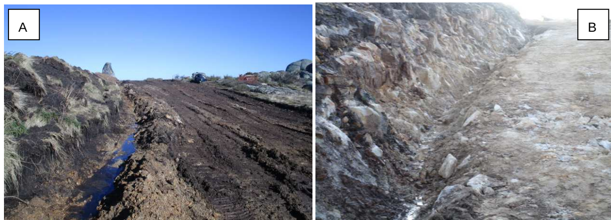
Fotografia 46 – Valetas provisórias (A e B).
