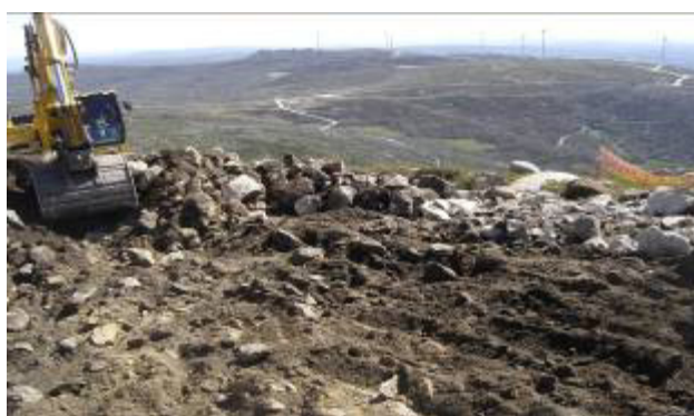
Preparação do acesso ao AG 19
