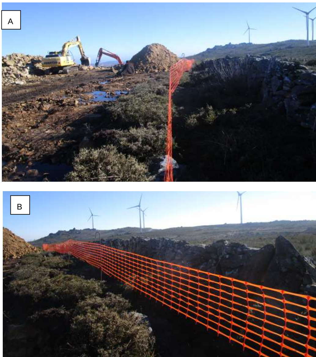
Fotografia 45 – Balizagem dos muros existentes na proximidade do A12 (A e B).
