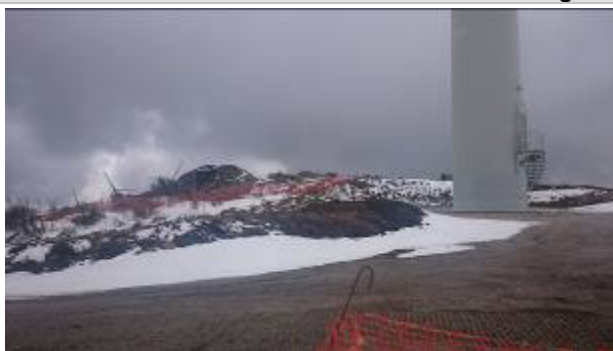
Aspeto geral da OP: 3P
