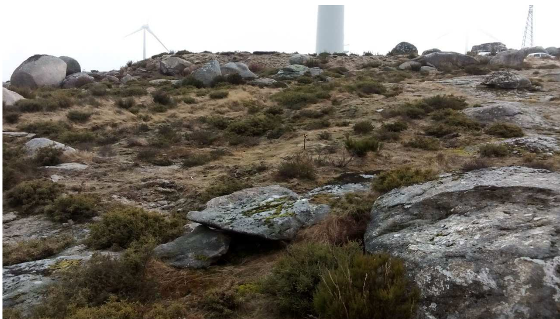
Fotografia 37 - Troço final da vala de cabos. Observa-se o aerogerador onde será efetuada a ligação.
