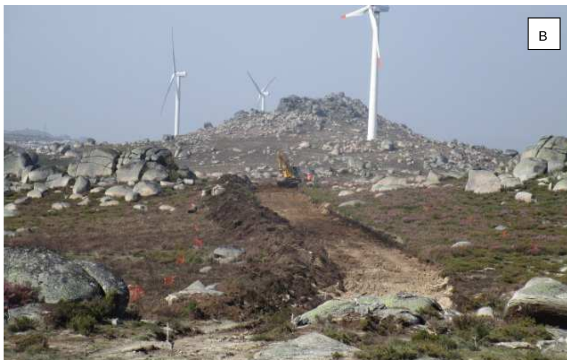
Fotografia 4 – Balizamento do acesso ao aerogerador n.º 19 do Subparque Eólico da Carvalhosa (A - com estacas de madeira e B - com fita sinalizadora).
