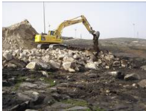
Continuação dos Trabalhos
