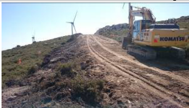
Preparação do acesso ao AG 18
