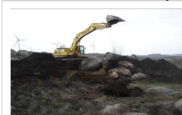
Desmatção e decapagem do acesso ao AG 18
