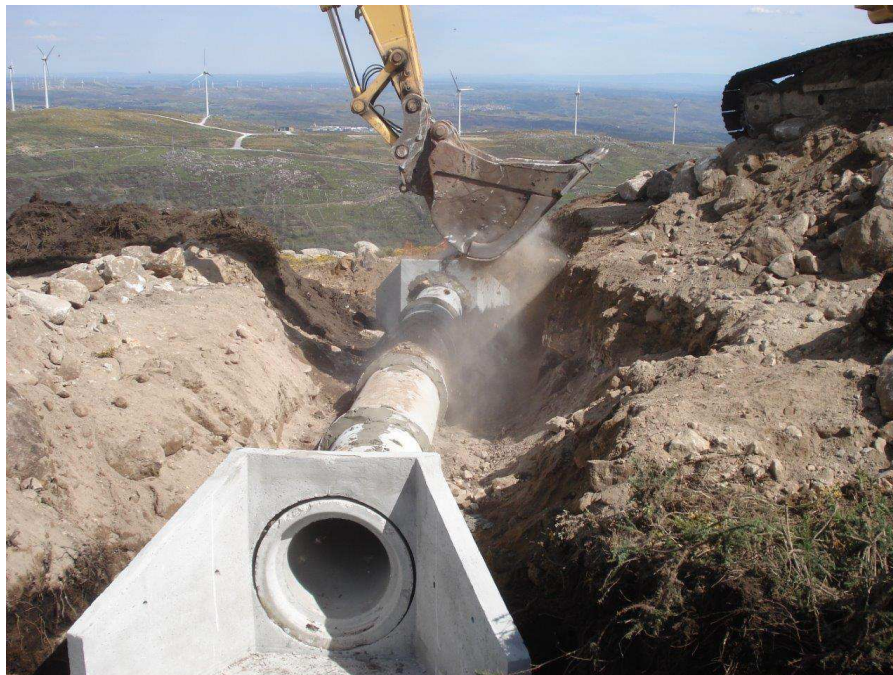
Fotografia 43 - Execução de passagens hidráulicas.
