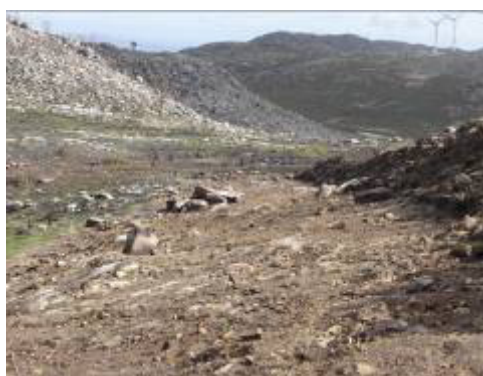
Parte de acesso ao AG30 já desmatado
