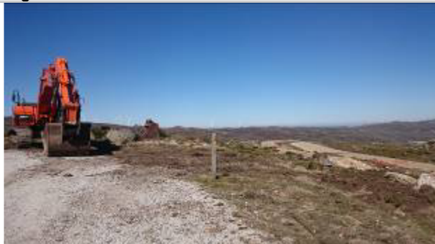
Vala de cabos
