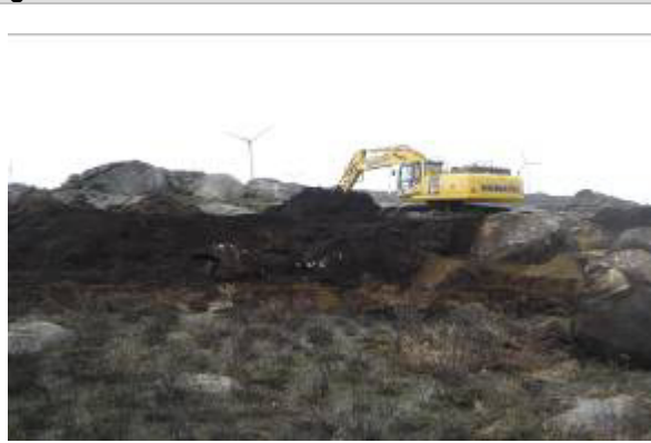
Desmatção e decapagem do acesso ao AG 18
