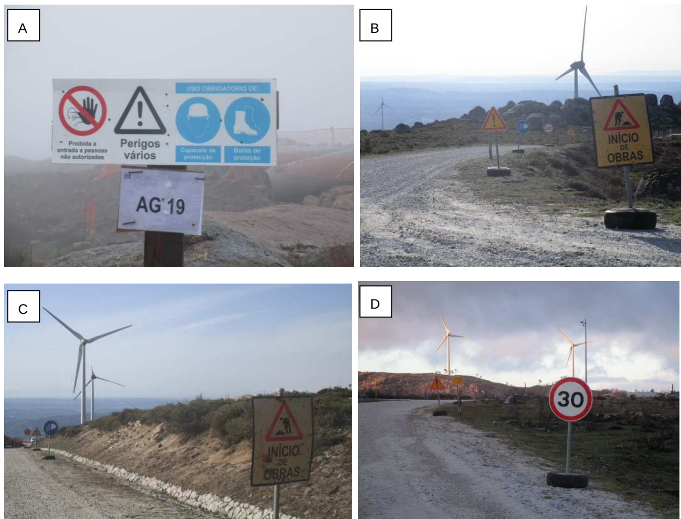
Fotografia 81 - Sinalética Informativa de Obra (A, B, C e D).
