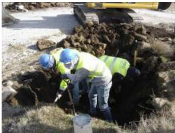
Fotografia 27 – Trabalhos manuais junto à ocorrência 3P.
