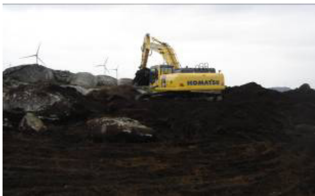
Desmatção e decapagem do acesso ao AG 18
