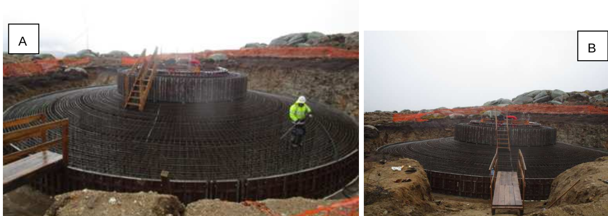
Fotografia 10 - Execução de trabalhos de ferro do aerogerador n.º 19 (A e B).
