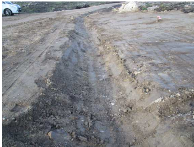
Fotografia 24 – Sistema de drenagem provisório no Subparque Eólico da Arada – Núcleo de Manhouce.
