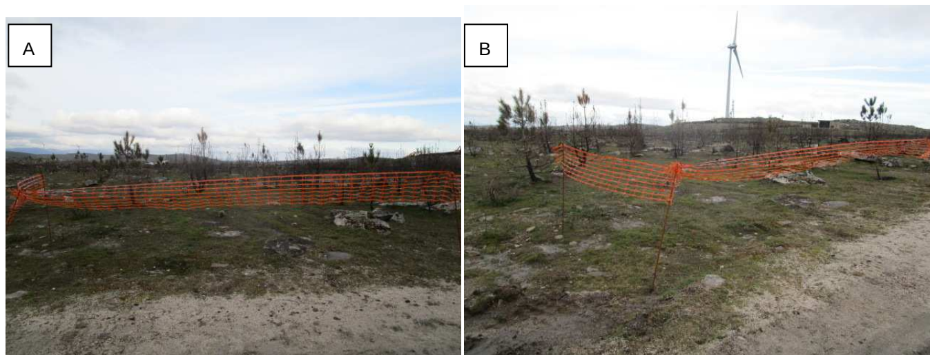
Fotografia 40 - Balizagem da ocorrência patrimonial 1M – Campo de Eirós, Via (A e B).
