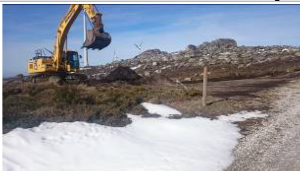
Desmatção e preparação do local de estaleiro
