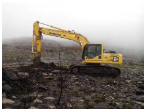
Trabalhos de abertura do acesso ao AG30
