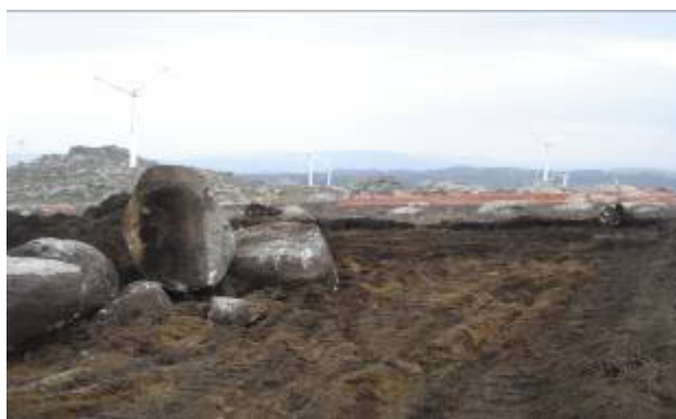
Desmatção e decapagem do acesso ao AG 18
