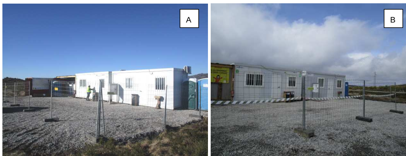
Fotografia 14 – Zona de Estaleiro, vista geral após instalação (A e B).
