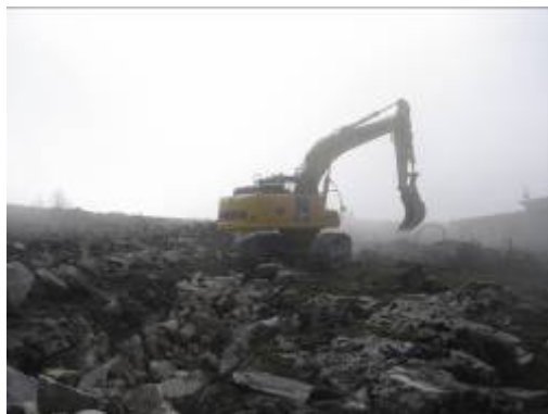
Vala de cabos
