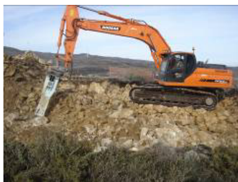
Continuação dos trabalhos
