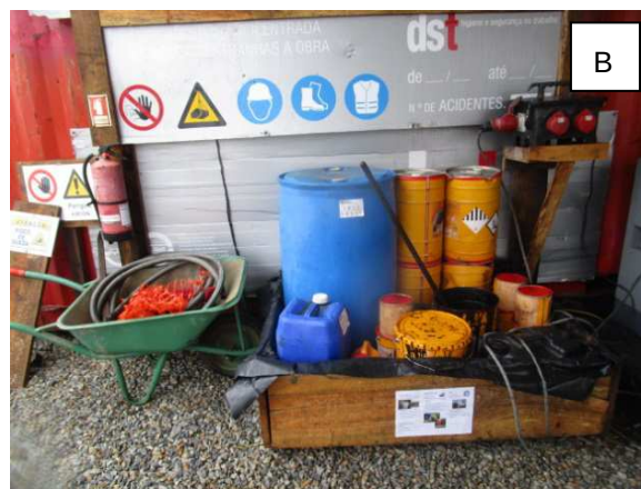
Fotografia 51 - Armazenamento de substâncias perigosas no estaleiro, sobre superfície impermeabilizada (A e B).
