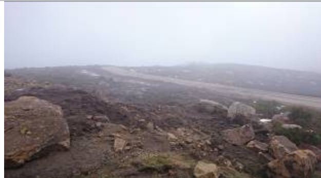
Desmatção e dacapagem do acesso ao AG 18
