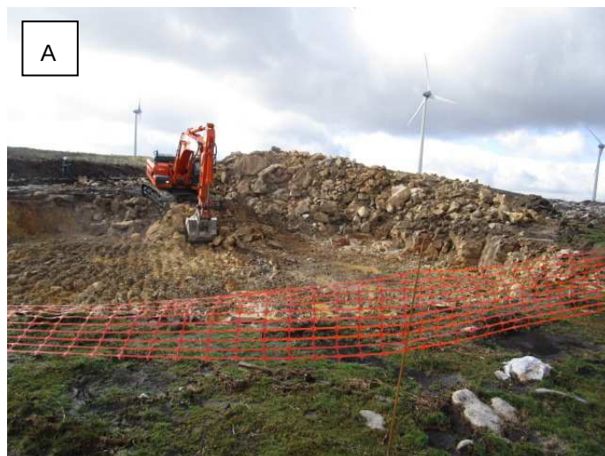
Fotografia 73 – Escavação para a sapata do aerogerador (A e B).
