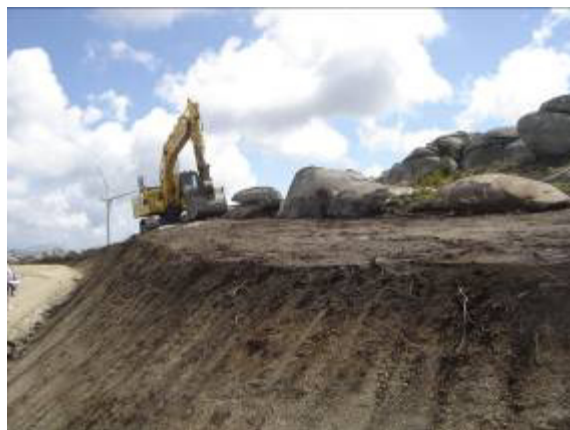
Aterro vala de cabos
