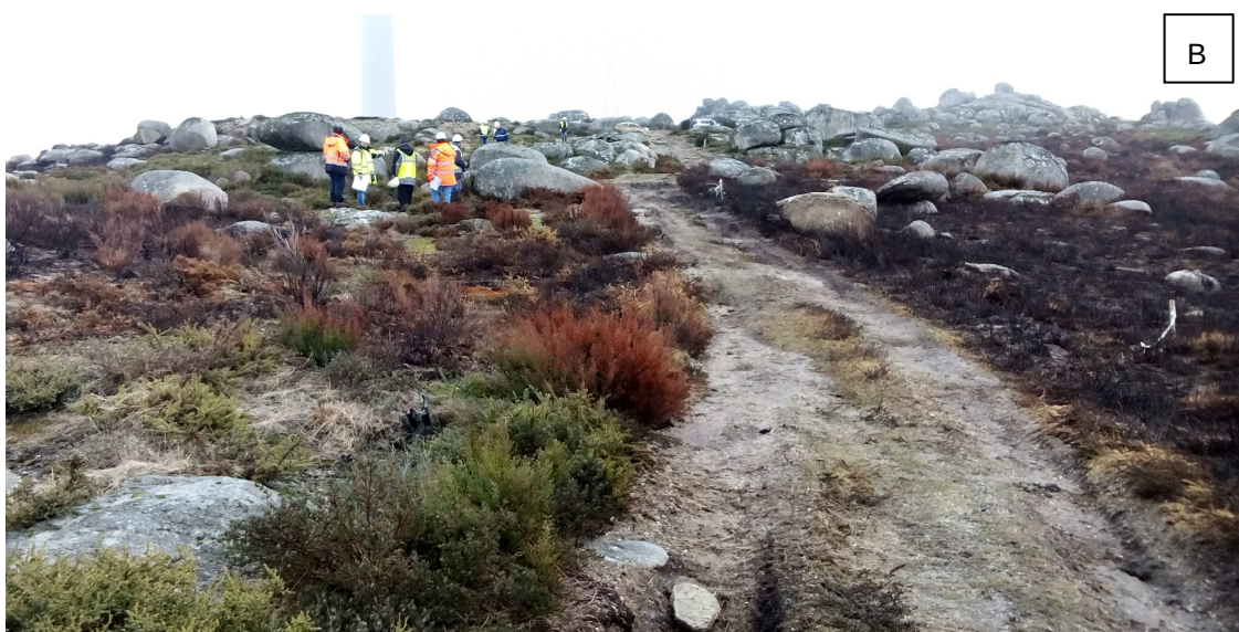
Fotografia 31 – Traçado da vala de cabos que irá escoar a energia produzida pelo aerogerador n.º 19 (A e B) – Solução apresentada no RECAPE.
