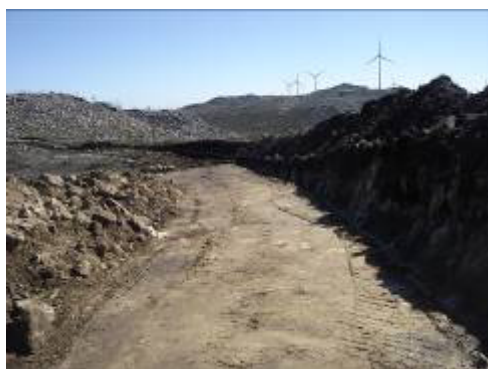
Acesso ao aerogerador 30
