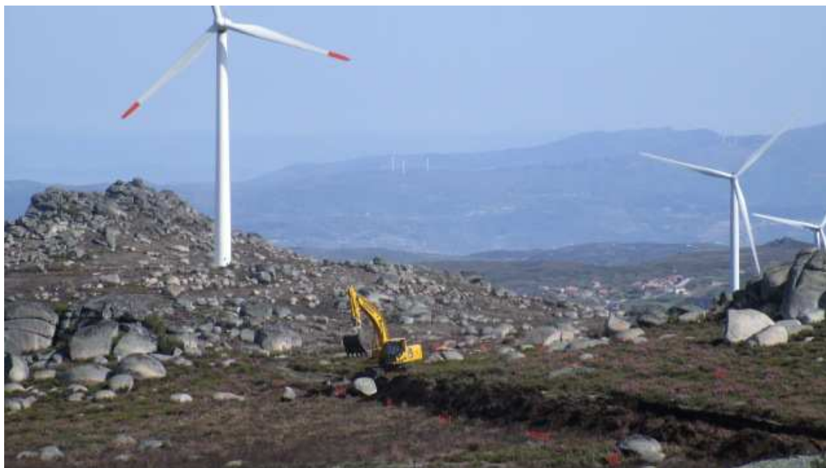
Fotografia 6 - Abertura do acesso e da vala de cabos.
