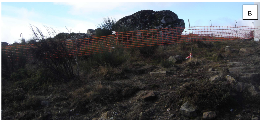
Fotografia 26 – Balizagem da ocorrência 3P, antes do início da obra (A e B).
