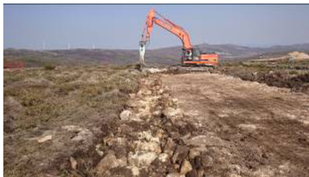
Trabalhos na zona do acesso ao AG 12: picagem/escavação
