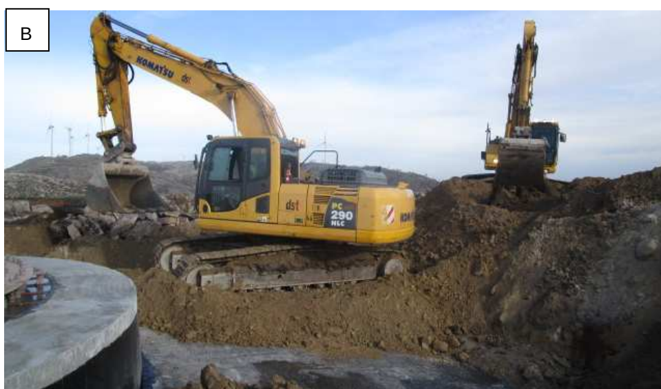
Fotografia 77 - Material inerte proveniente das ações de escavação (A), que posteriormente foi utilizado nas ações de aterro (B).
