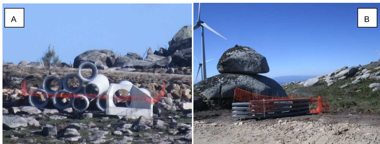
Fotografia 62 - Deposição de materiais necessários à obra balizados com fita sinalizadora (A e B).
