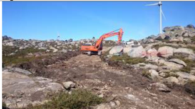
Desmatção e dcapagem do acesso ao AG 18
