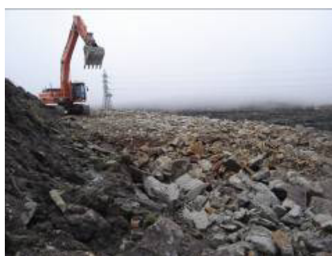
Continuação da abertura do acesso ao AG30
