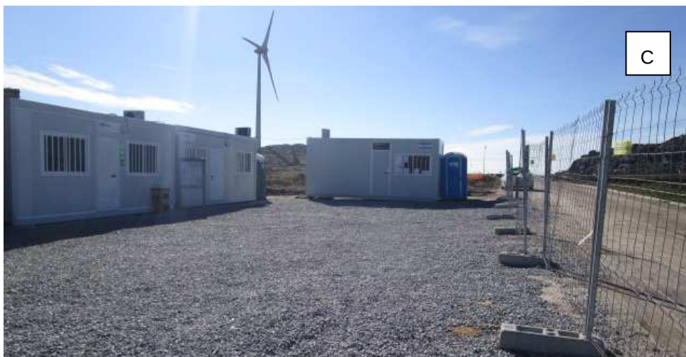
Fotografia 54 - Gravelha na zona dos estaleiros (Subparques Eólicos A – Carvalhosa, B – Picão e C – Arada – Núcleo de Manhouse).
