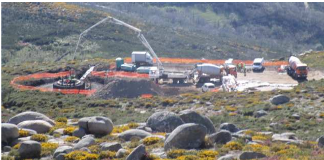
Fotografia 9 – Plataforma do aerogerador n.º 18 do Subparque Eólico da Carvalhosa balizada com fita sinalizadora em toda a sua envolvente.
