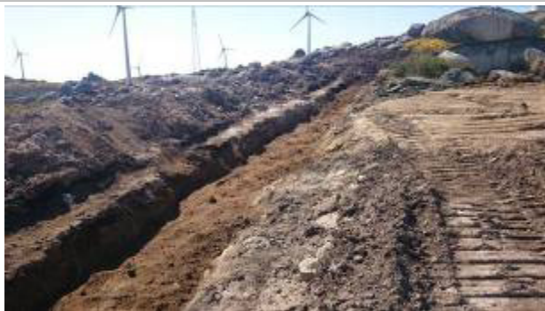
Aterro vala de cabos (AG 19)
