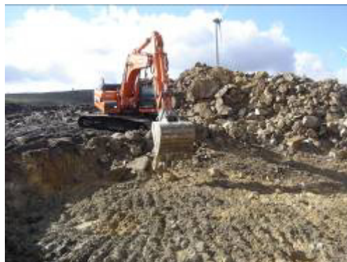
Trabalhos Finais no AG31
