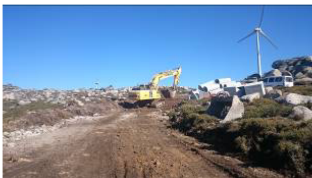
Desmatção e decapagem do acesso ao AG 18
