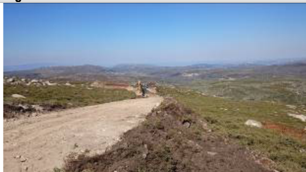
Preparação do acesso ao AG 18
