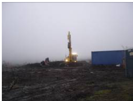
Desmatação da área de estaleiro
