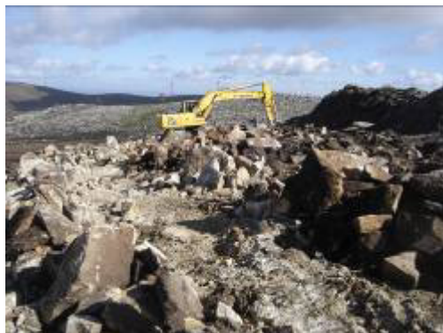
Plataforma e fundação do Ag31
