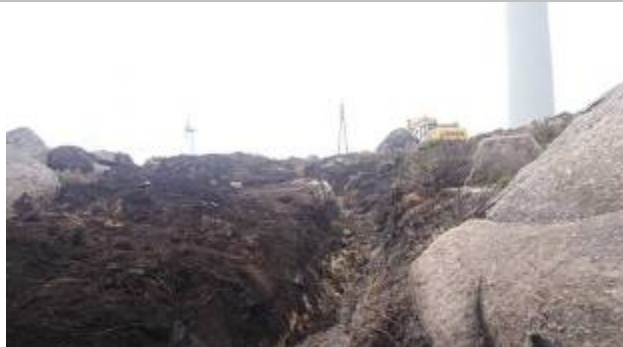
Aterro vala de cabo (AG 19)
