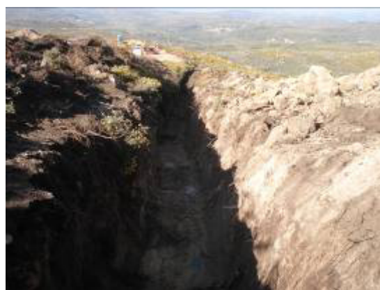
Vala de cabo (AG 19)
