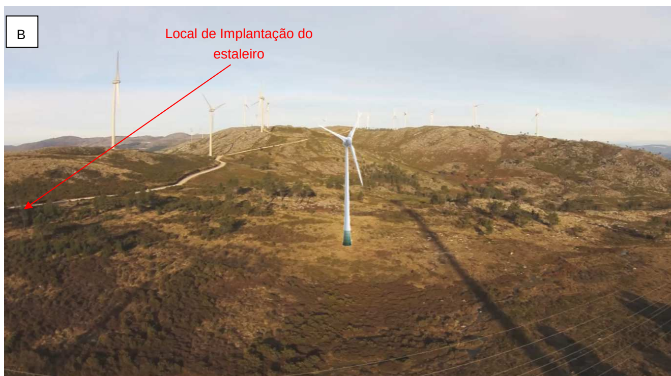
Fotografia 68 – Local de implantação do estaleiro (A e B), antes do incêndio.
