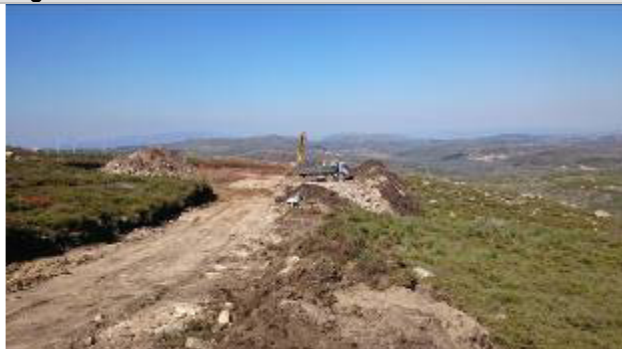
Preparação do acesso ao AG 18
