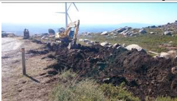
Desmatção e dcapagem do acesso ao AG 18
