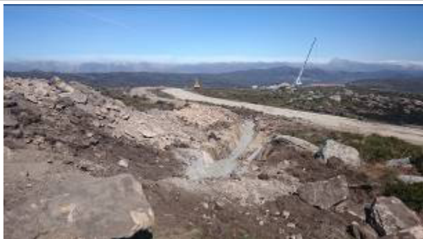
Aterro da vala de cabos
