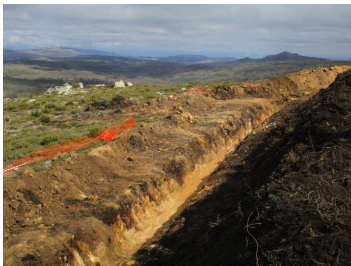
Fotografia 18 - Abertura da Vala de Cabos no Subparque eólico de Picão em local previamente balizado.
