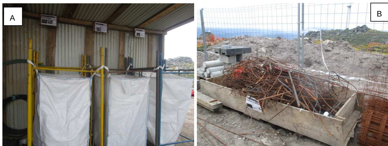
Fotografia 48 - Recipientes para recolha de resíduos no estaleiro do Subparque Eólico da Carvalhosa (A e B).
