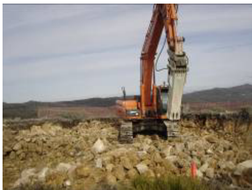
Abertura das fundações do AG12
