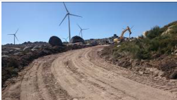
Preparação do acesso ao AG 18
