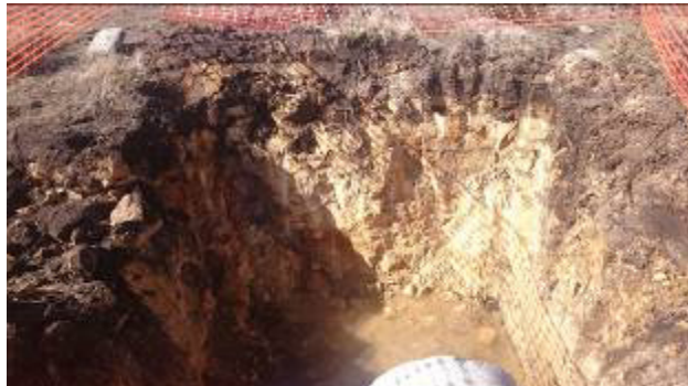
Trabalhos na zona do acesso ao AG 12: pormenor da estratigrafia no local de implantação de passagem hidráulica
