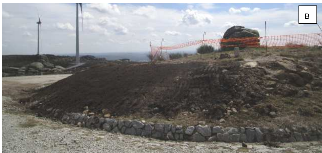
Fotografia 28 – Requalificação ambiental do local de passagem da Vala de cabos junto da ocorrência 3 P (A e B).
