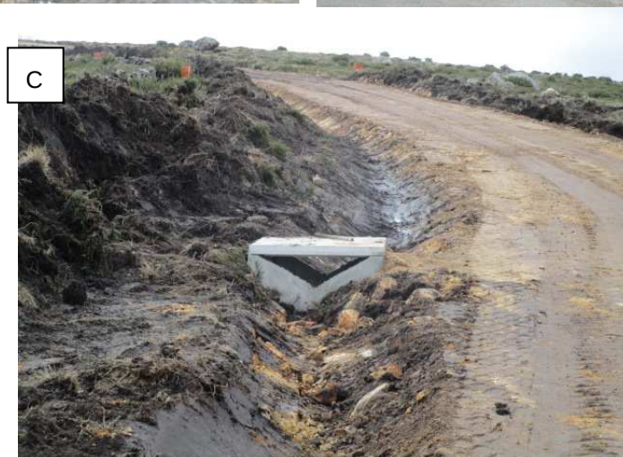
Fotografia 42 - Valetas Provisórias (A, B e C).
