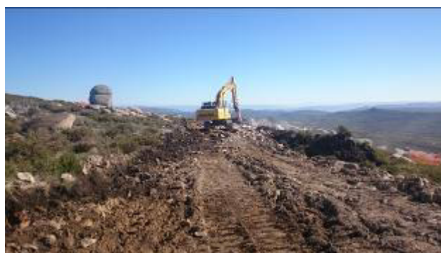
Desmatção e decapagem do acesso ao AG 18
