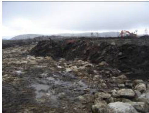
Continuação dos trabalhos no acesso ao Ag31
