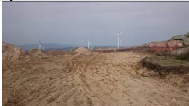
Preparação da plataforma do AG 19
