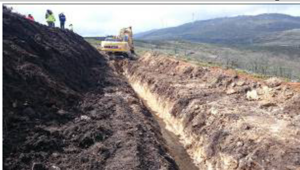
Vala de cabos
