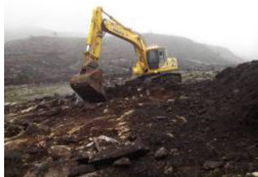
Trabalhos de abertura do acesso ao AG30
