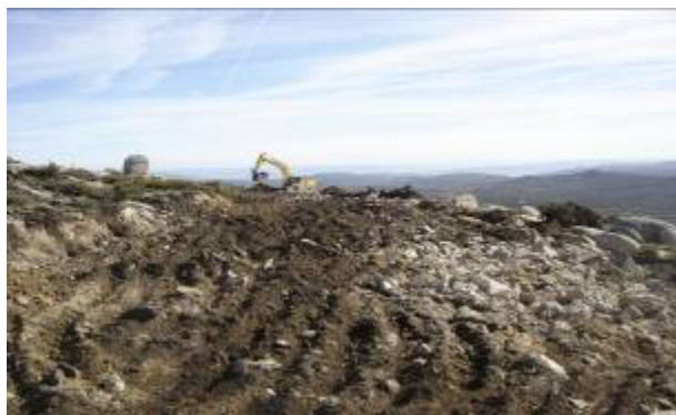
Preparação do acesso ao AG 19
