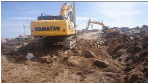
Preparação do acesso ao AG 19
