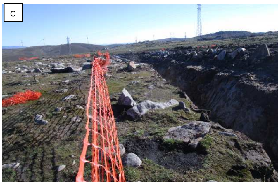
Fotografia 60 - Balizagem dos locais de construção das valetas (A, B e C).
