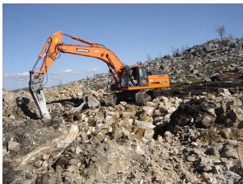
Abertura de Acesso ao AG30
