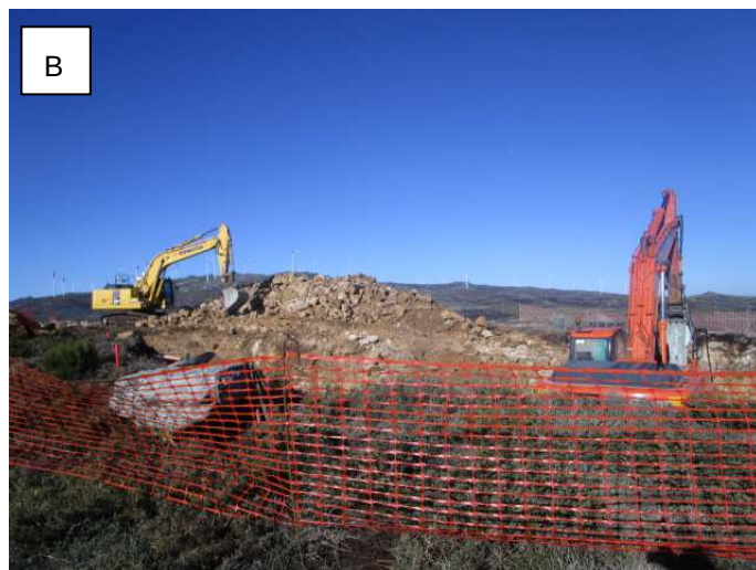
Fotografia 73 – Escavação para a sapata do aerogerador (A e B).
