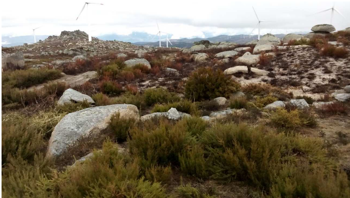
Fotografia 36 - Troço intermédio da vala de cabos (mais próximo do ponto de ligação).
