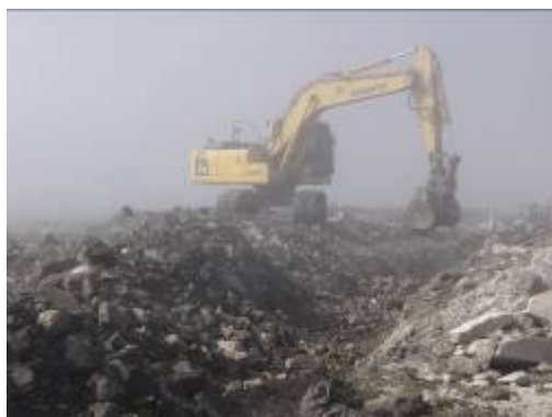
Vala de Cabos
