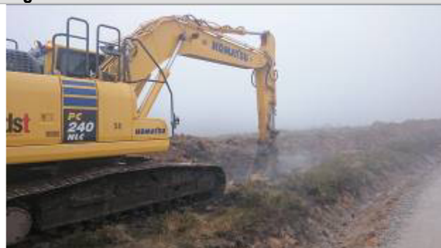
Vala de cabos
