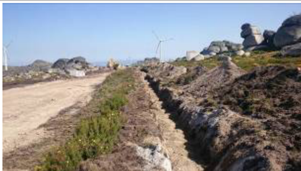
Aterro vala de cabos (AG 19)
