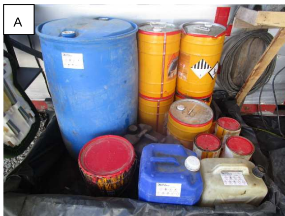
Fotografia 51 - Armazenamento de substâncias perigosas no estaleiro, sobre superfície impermeabilizada (A e B).
