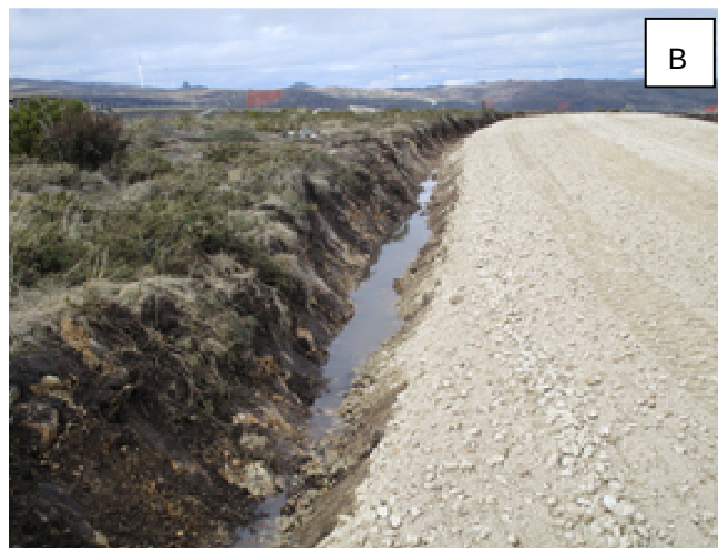
Fotografia 17 - Drenagem provisória do novo acesso ao aerogerador n.º 12 (A e B).
