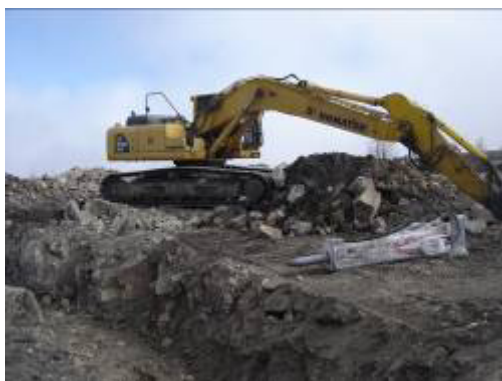
Conclusão da abertura de vala de cabos
