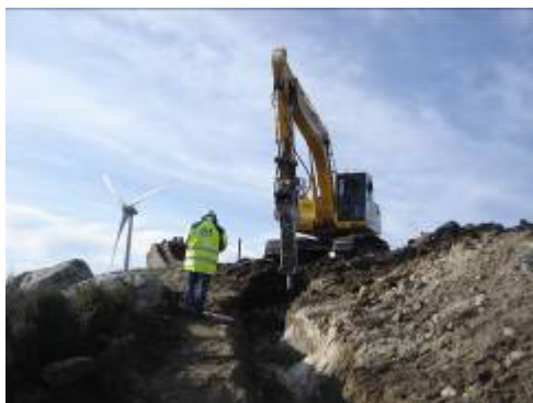
Abertura de vala de cabos
