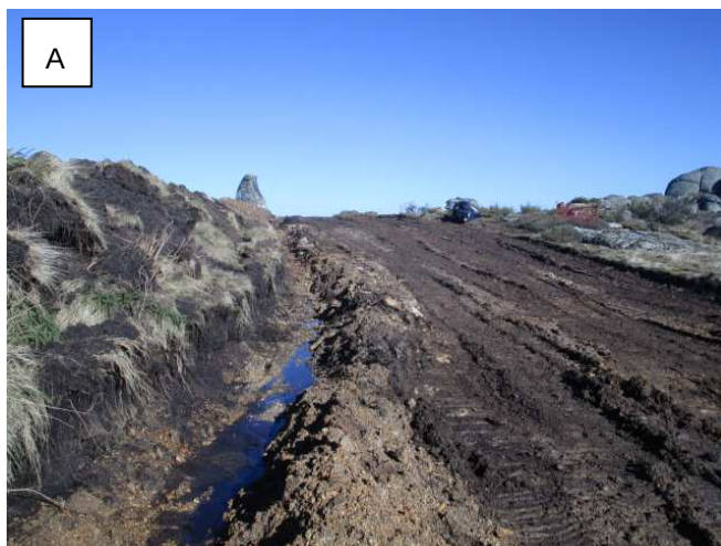
Fotografia 17 - Drenagem provisória do novo acesso ao aerogerador n.º 12 (A e B).
