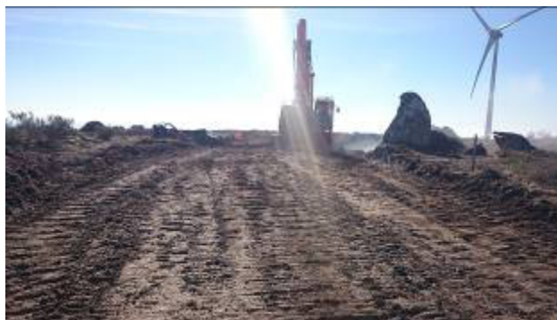
Trabalhos na zona do acesso ao AG 12
