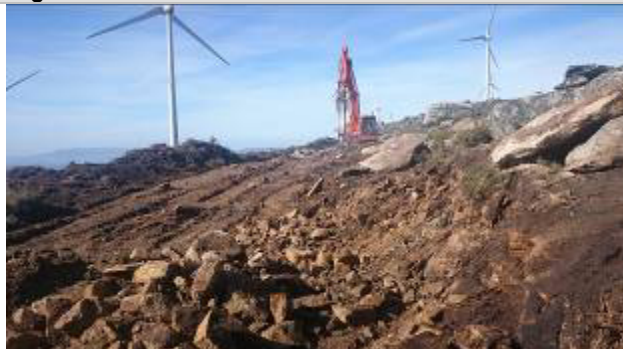
Desmatção e decapagem do acesso ao AG 18
