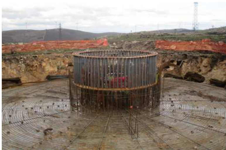
Fotografia 23 – Balizagem da Sapata do aerogerador n.º 31.
