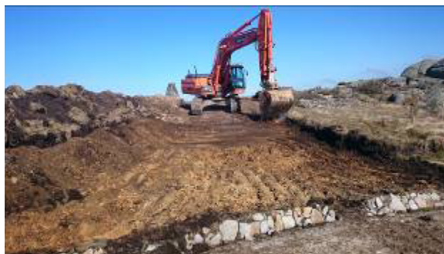
Trabalhos na zona do acesso ao AG 12
