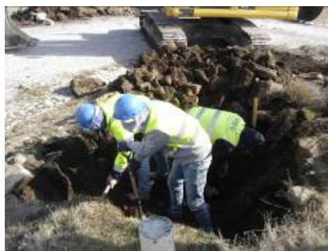
Trabalhos manuais junto à OC. 3P
