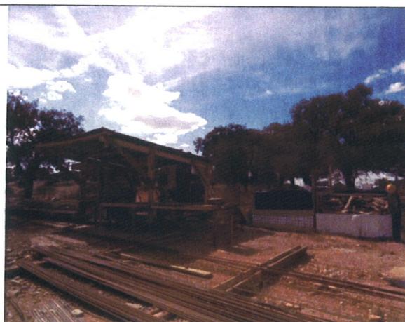
Fotografia 3 - Área de Preparação de Ferro.
