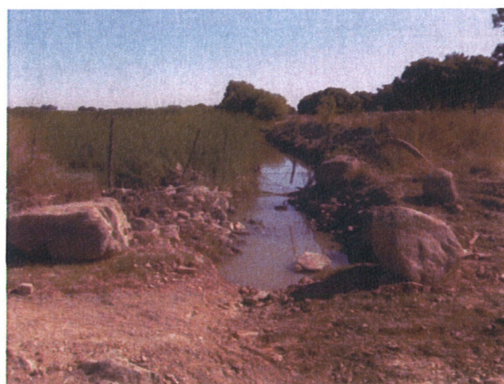
Fotografia 38- Ribeiro do Carrasco (vista para montante, já em fase de obra).
