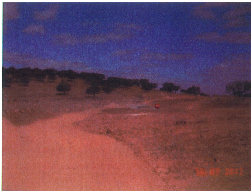
Fotografia 7 - Acessos internos, Troço 2.
