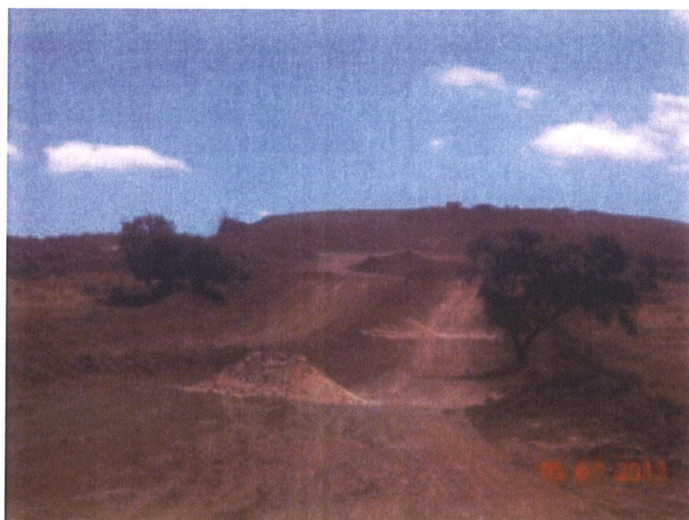
Fotografia 6 – Acessos internos, Troço 3.
