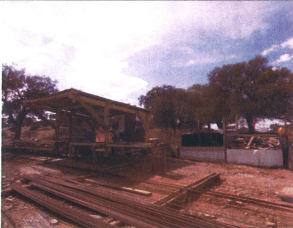
Fotografia 4 - Área de Preparação de Ferro.
