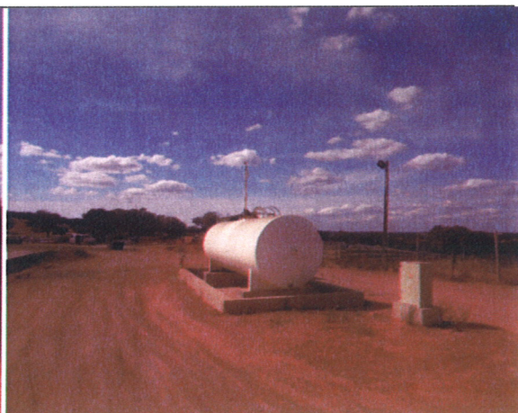
Fotografia 3 - Posto de Combustível.
