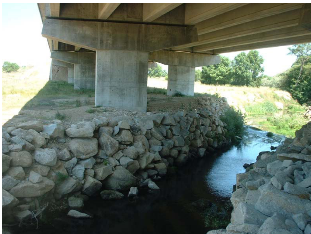
Figura I.1 – Ponto de colheita 4 (ribeira de Caria, a jusante do viaduto)
