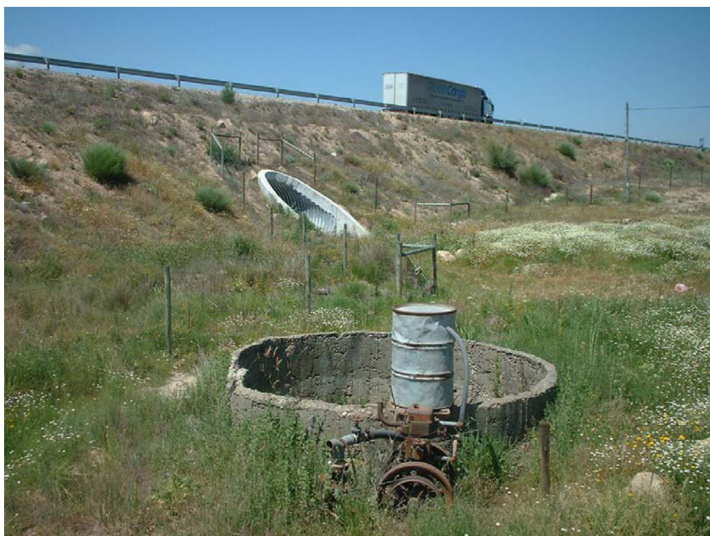
Figura I.8 – Ponto de colheita 35 (poço a seguir à passagem inferior da estrada de Peraboa)
