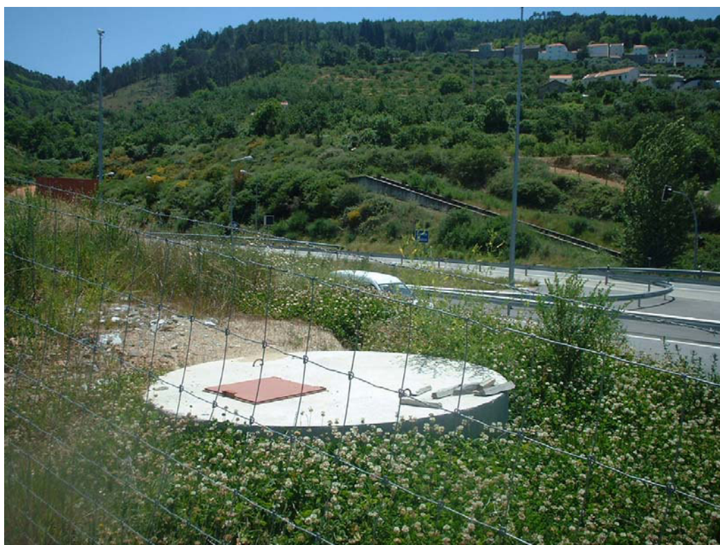
Figura I.3 – Ponto de colheita 18 (poço a jusante do emboquilhamento Norte)
