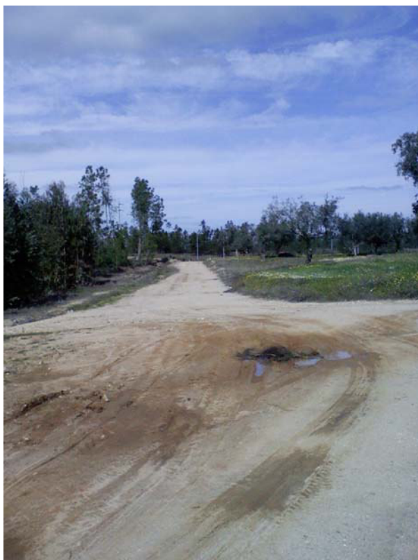
Vista da A23 a partir do local aproximado de medição
