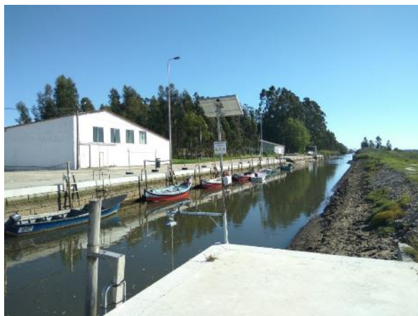
Local de Medição - Puxadouro
