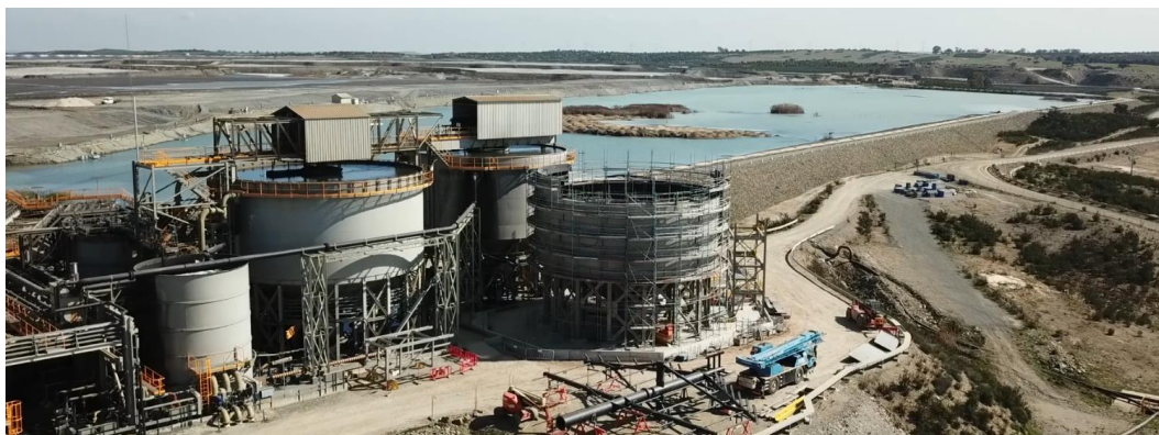
B - 3.º Espessador da Central de Pasta em construção
