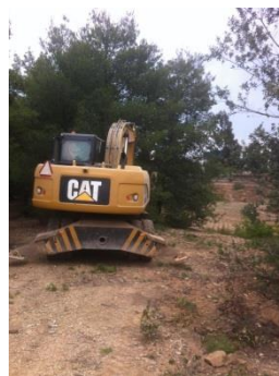
B – Trabalhos de desmatamento
