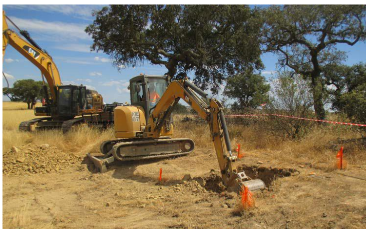
Fotografia 4.33 – Pormenor dos trabalhos de escavação do cabouco do Apoio n.º 9, localizado nas imediações da OIP 42 – Cerro das Cevadas
