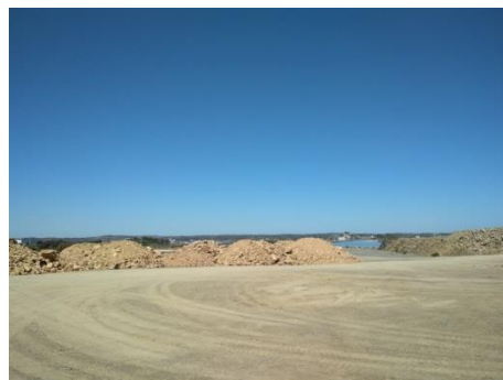
B - Solos escavados no depósito de terras da IRCL
