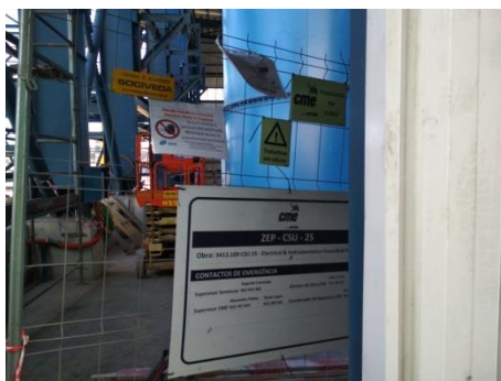
Frentes de obra
