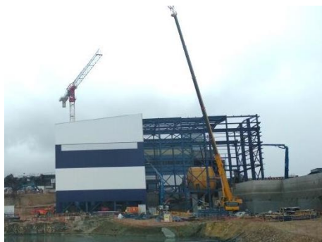
A – Nave industrial em construção
