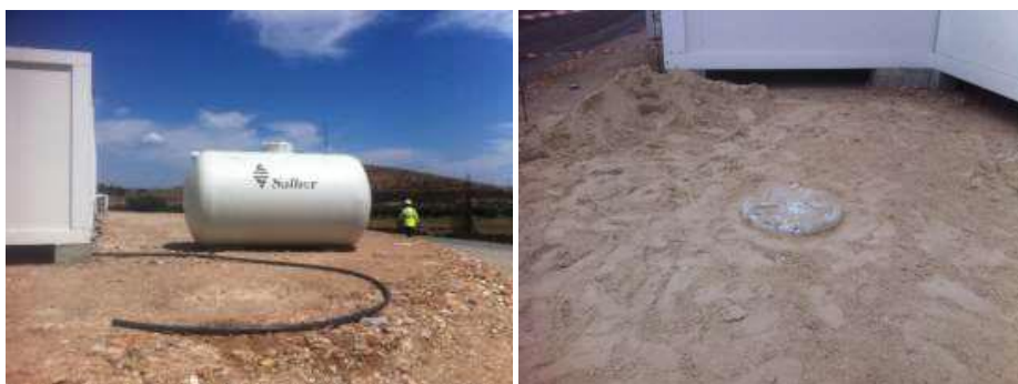
Fossa estanque de águas residuais
