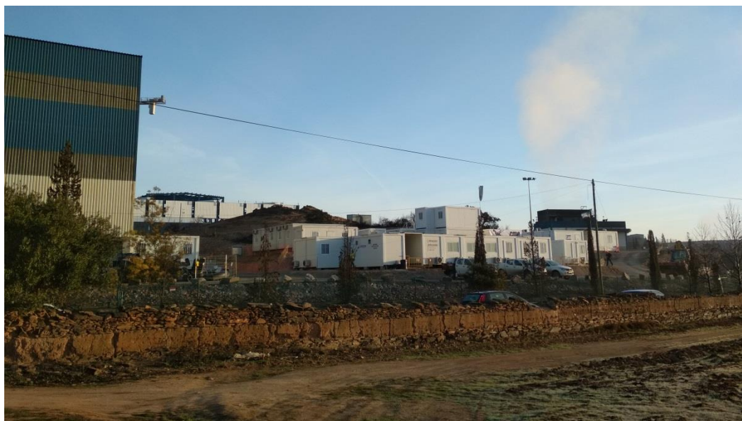
Fotografia 4.3 – Estaleiro 3A dentro da zona vedada do couro mineiro
