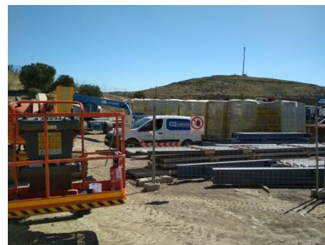
Fotografia 4.9 – Interdição de terceiros às zonas de estaleiros e às frentes de obra
