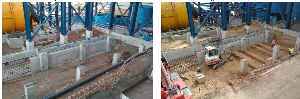
Relatório de Acompanhamento Ambiental referente ao 10.º mês de obra (fevereiro 2019)
