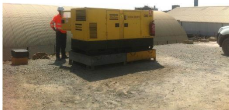
Fotografia 4.11 – Exemplos meios de acondicionamento de geradores
