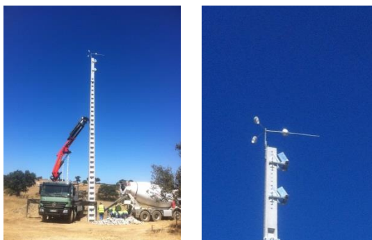
Fotografia 4.24 – Sinalizadores rotativos da Linha Elétrica
