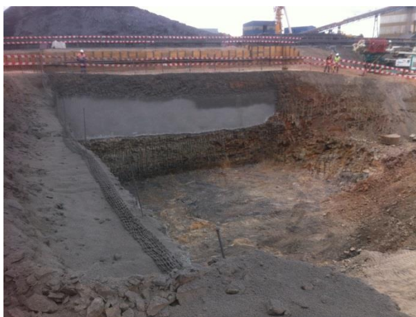
Fotografia 4.17 – Ponto mais profundo escavado para as infraestruturas de superfície
