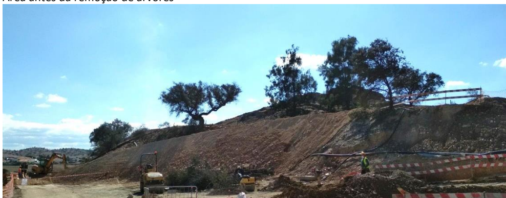
Área após a remoção das árvores
