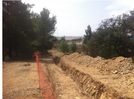
D – Início dos trabalhos de escavação após limpeza da área
