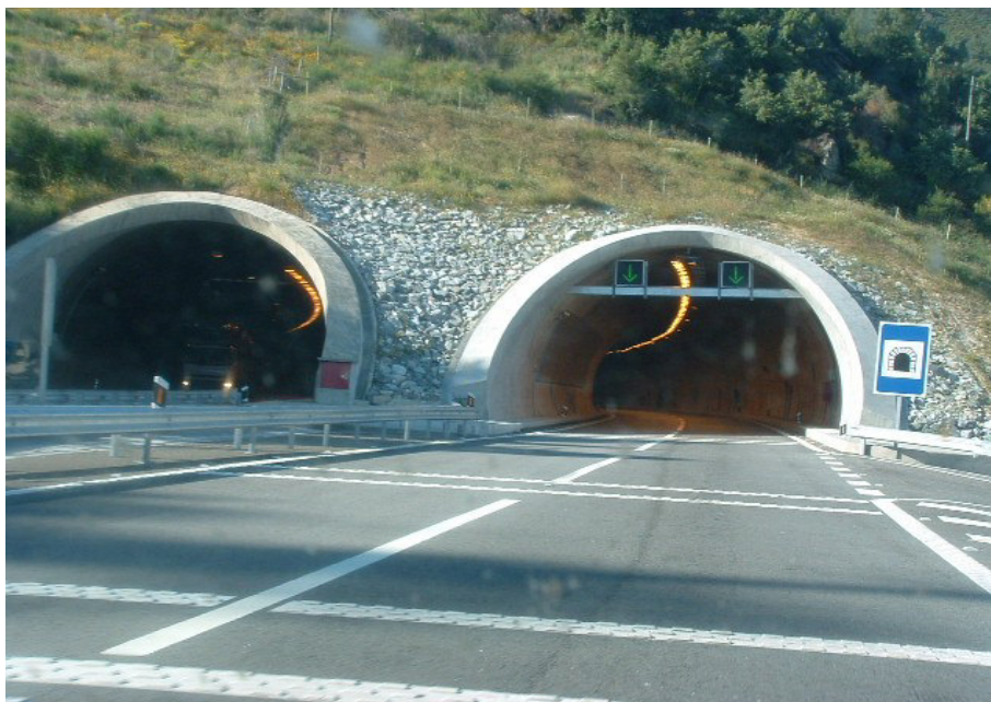
Local junto do emboquilhamento Sul do túnel da Gardunha
