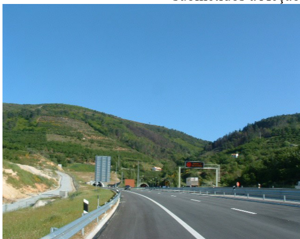
Emboquilhamento Norte do Túnel da Gardunha, junto da povoação de Alcongosta e ribeira da Carvalha
