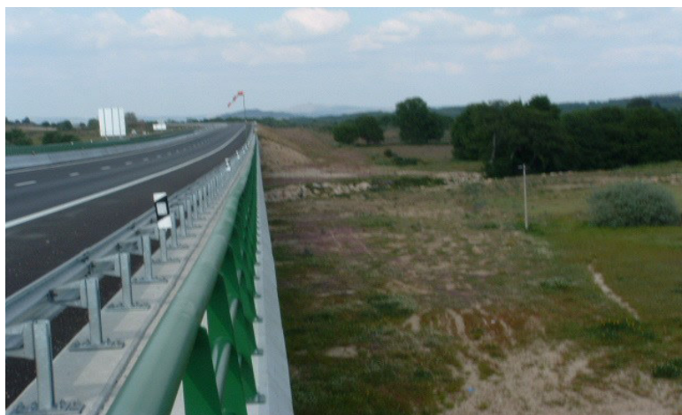
Ribeira de Cária e pavimento drenante. Medida implementada para redução dos efeitos sonoros na Quinta da França Lanço da A23/IP2 Teixoso - Alcária
