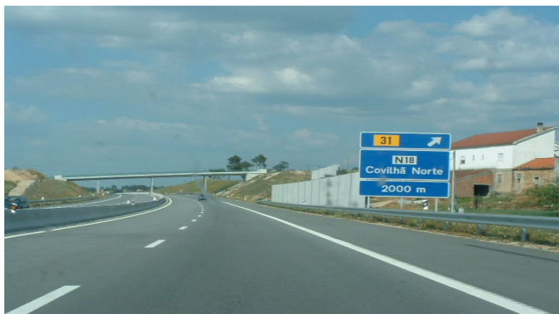
Barreiras acústicas no Local 9 da A23/IP2 Teixoso – Alcária. A medida minimizadora implementada tem-se revelado eficaz na atenuação dos impactes no ruído.
