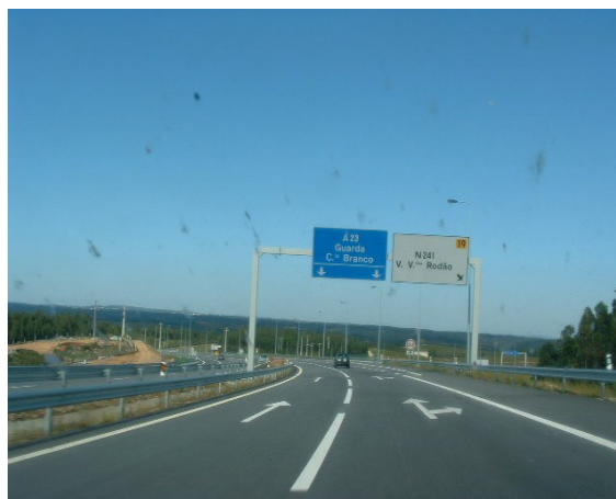
Lanço da A23/IP2 Castelo Branco Sul – Fratel, Zona de Alvaiade
