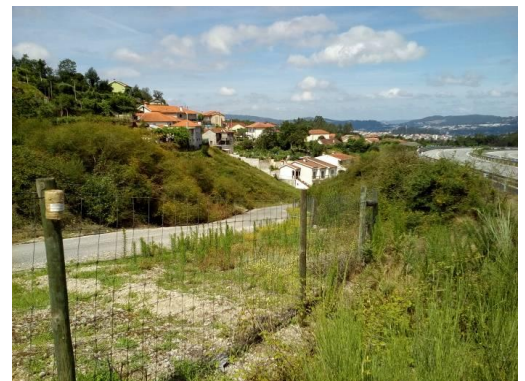
Figura 72 – Fotografia do local A7 Km 58+900 (L6-1-A) (sul)
