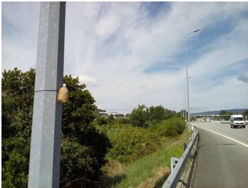
Figura 33 – Fotografia do local A11 Km 25+050 (L2-4-B) (norte)
