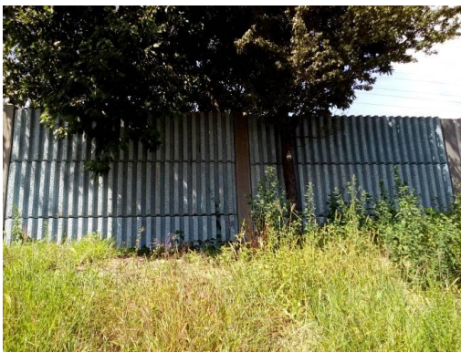
Figura 35 – Fotografia do local A11 Km 31+600 (L3-1-B) (norte)
