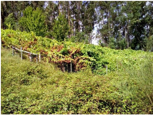
Figura 39 – Fotografia do local A11 Km 37+950 (L3-3-B) (norte)
