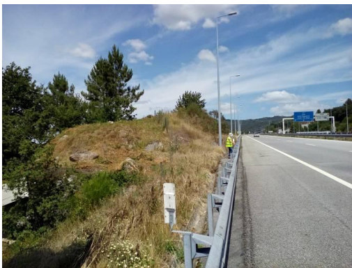
Figura 65 – Fotografia do local A7 Km 41+305 (L5-1-B) (norte)
