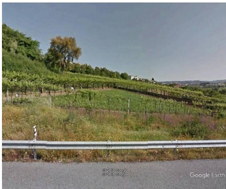
Figura 61 – Fotografia do local A7 Km 19+290 (L4-3-B) (norte)
