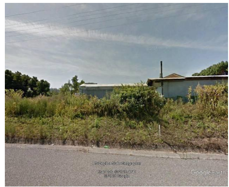
Figura 36 – Fotografia do local A11 Km 31+600 (L3-1-A) (sul)
