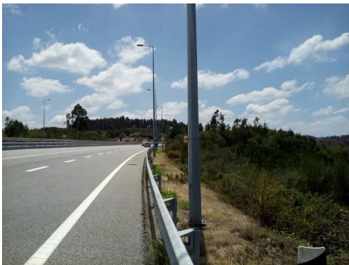
Figura 55 – Fotografia do local A11 Km 75+550 (L11-2-A) (oeste)
