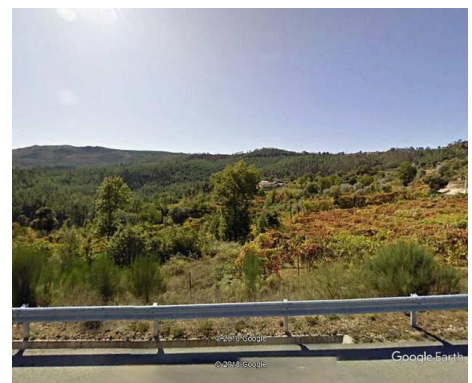
Figura 78 – Fotografia do local A7 Km 80+100 (L7-1-A) (sul)
