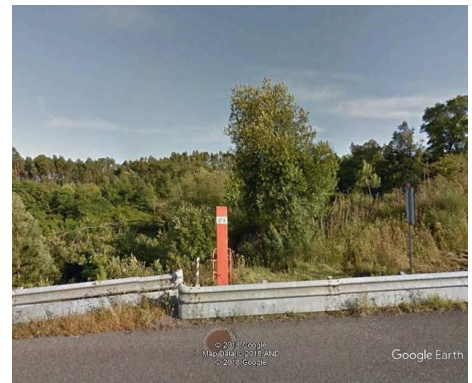
Figura 62 – Fotografia do local A7 Km 19+290 (L4-3-A) (sul)
