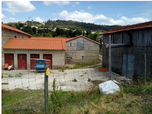
Figura 43 – Fotografia do local A11 Km 54+700 (L9-1-A) (oeste)
