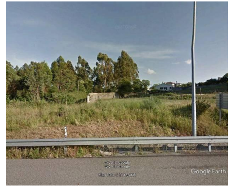
Figura 58 – Fotografia do local A7 Km 2+390 (L4-1-A) (sul)
