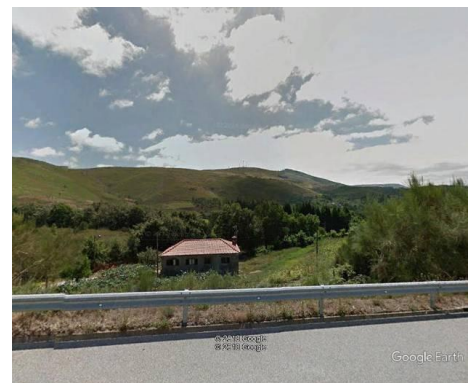
Figura 80 – Fotografia do local A7 Km 91+000 (L8-1-A) (sul)
