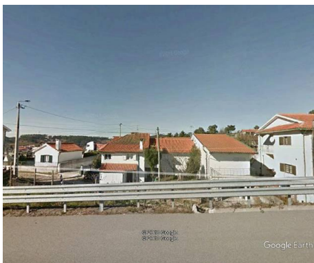
Figura 79 – Fotografia do local A7 Km 91+000 (L8-1-B) (norte)
