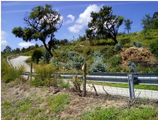
Figura 51 – Fotografia do local A11 Km 66+400 (L10-2-A) (oeste)
