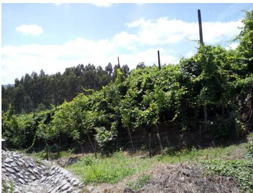
Figura 53 – Fotografia do local A11 Km 71+300 (L11-1-A) (oeste)
