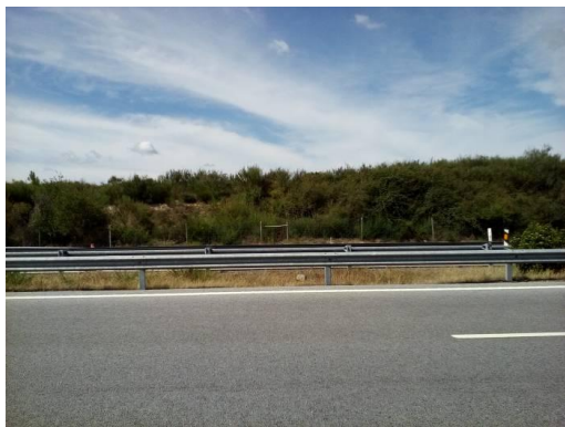
Figura 41 – Fotografia do local A11 Km 40+600 (L3-4-B) (norte)
