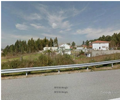
Figura 29 – Fotografia do local A11 Km 15+350 (L2-2-B) (norte)
