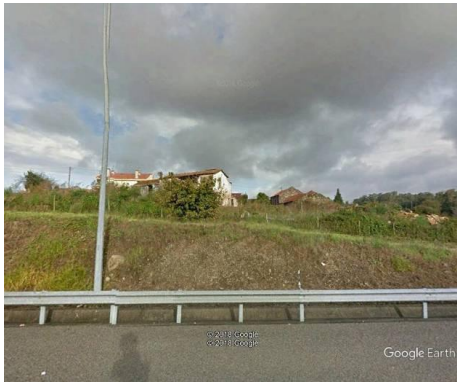
Figura 57 – Fotografia do local A7 Km 2+390 (L4-1-B) (norte)
