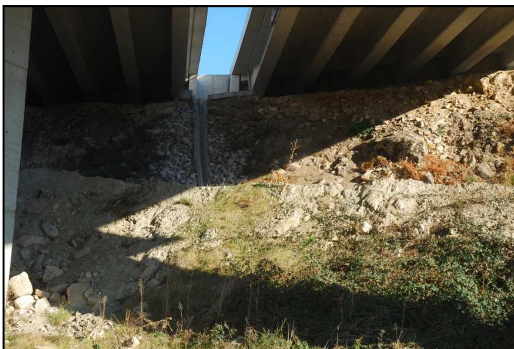
Figura 4.4 – Taludes de maior inclinação, com reduzido coberto vegetal.
