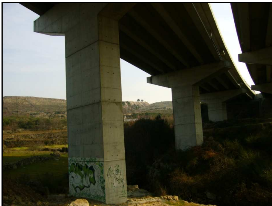
Figura AII.1 – Ponto de amostragem do Viaduto sobre o Rio Felgueiras (P1).
