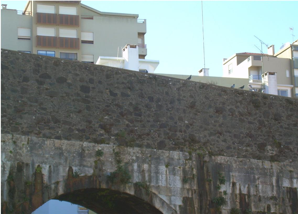
Figura n.º 7 – Pormenor do modo de construção do topo do aqueduto
