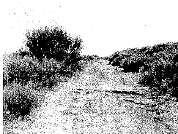
Foto 11 – Acesso entre os locais previstos para a implantação dos aerogeradores 7 e 8, vista do local deste último
