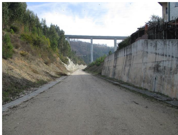
Figura 1 - Vista atual do canal suburbano do Metrobus no troço Alto S. João / Serpins.
