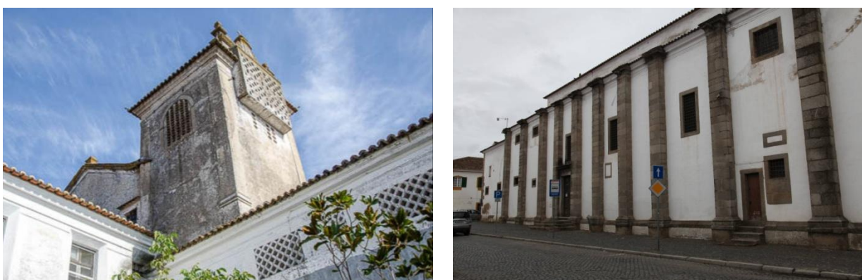
Fotografia 4 - Torre e fachada do Convento (fonte: www.visitevora.net )
