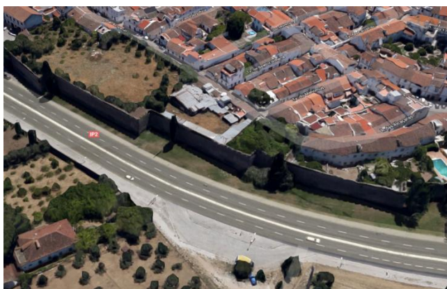
Fotografia 21 - Imagem tridimensional da muralha ao longo da Av. D. Manuel Trindade Salgueiro
