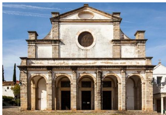
Fotografia 9 - Fachada principal (fonte: http://dioceseevora.pt )
