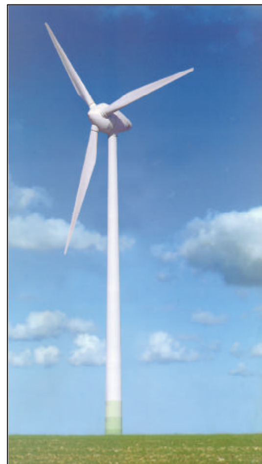
Figura 4 - Aerogerador ENERCON E66 (1800 quilowatts)
