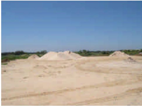
Fotografia 1 – Zona de depósito de materiais na área de projecto
