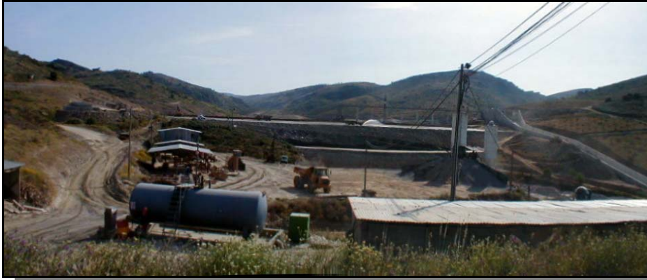
Fotografia 11 – Estaleiro da obra de construção da barragem de Santa Justa
