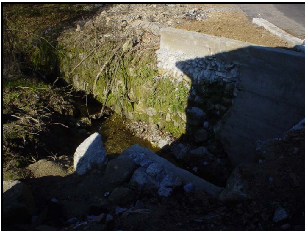
Figura 4.6.1 - Linha de Água que Atravessa o Traçado, cerca do km 0+750 do Troço 2
