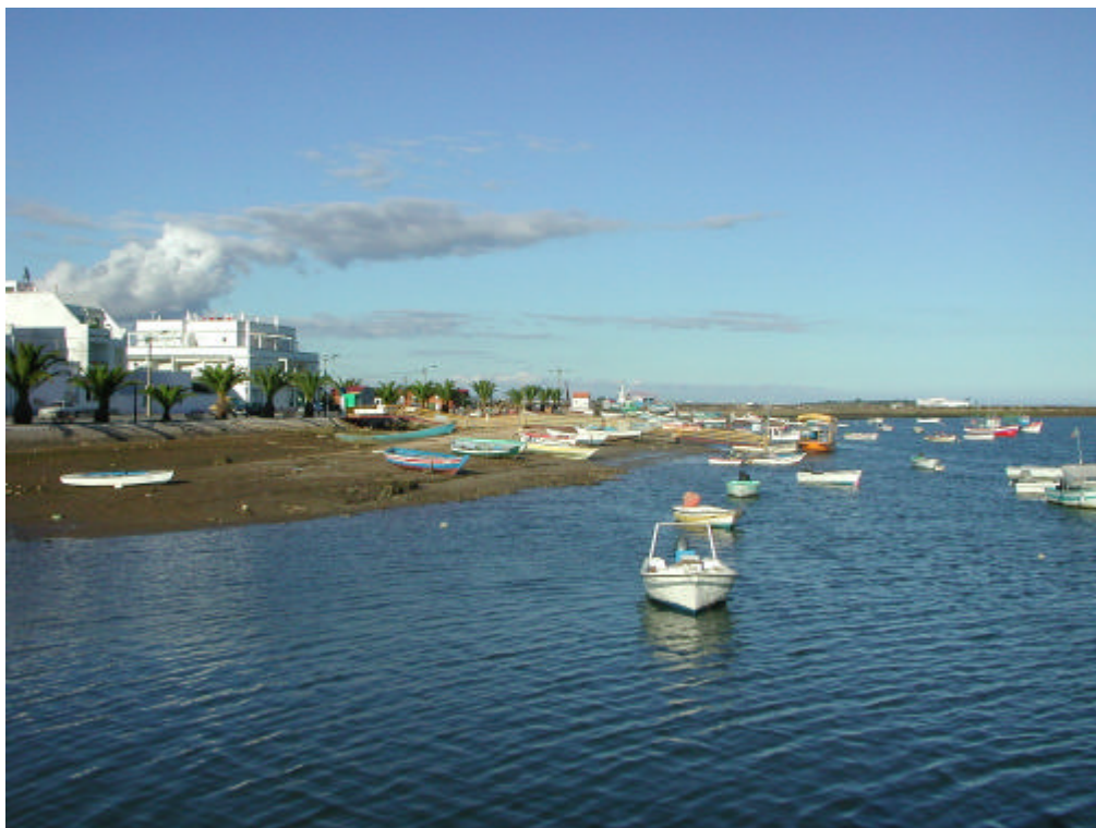
Fotografia 4.10.3 – Assoreamento generalizado do canal
