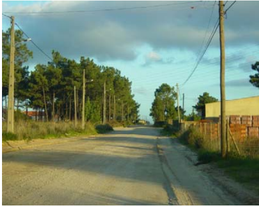
Figura 1.5 – Eixo actual a escavar para construção do IC32, na Quinta das Laranjeiras
