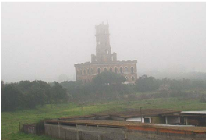
Figura IV.10.10 – Castelo de Coina, Localiza-se a 250m N da sol.1 ao km 19+500
