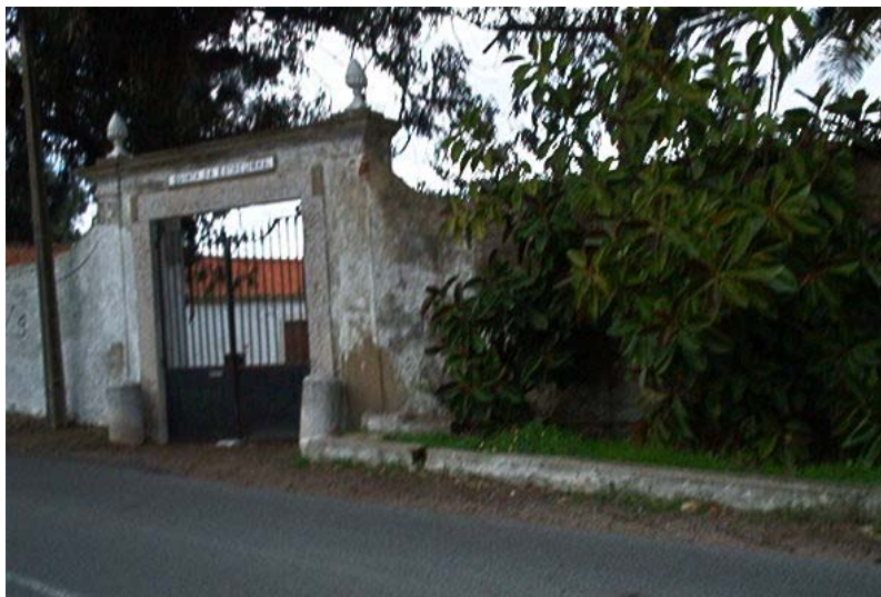
Figura IV.10.4 – Quinta da Estrelinha, Localiza-se a 25 metros O do Km 0+850 da sol. 1
