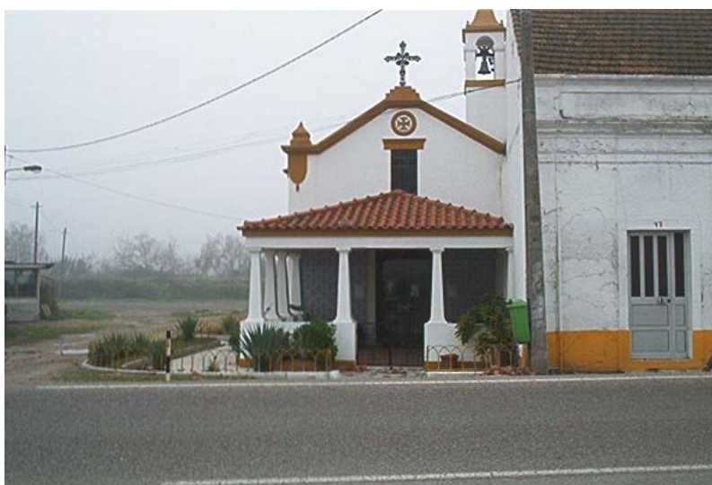
Figura IV.10.9 – Capela de Nª Srª dos Remédios, Localiza-se a 175m SE do km 19+200 da sol.1 (Nó de Coina com a EN 10-3)
