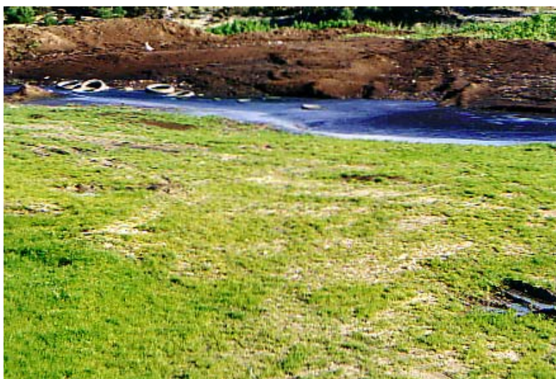
Figura IV.2.16 – Acumulação de águas contaminadas, junto à ETAR, sol.2D.
