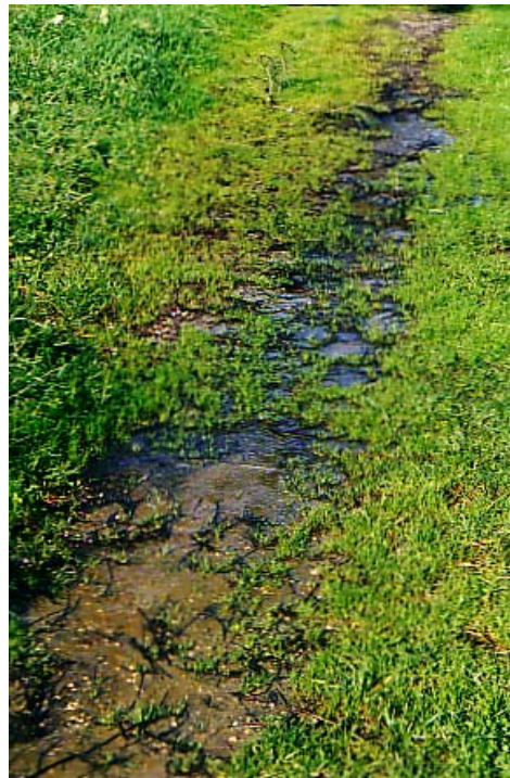
Figura IV.2.15 e IV.2.15 A – Aspectos da acumulação de água nos terrenos, devido à fraca capacidade de infiltração, início da sol.1A.
