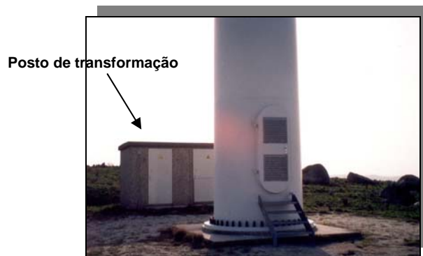
Fotografia 2 – Exemplo de um posto de transformação de um aerogerador num parque eólico.
