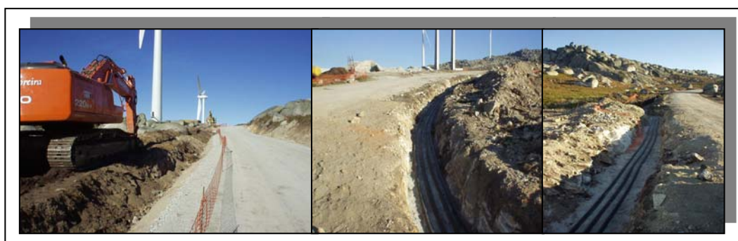
Figura 9 – Vala para instalação dos cabos eléctricos.
