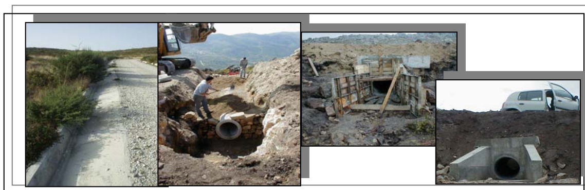
Figura 4 – Valeta e construção de uma passagem hidráulica.
