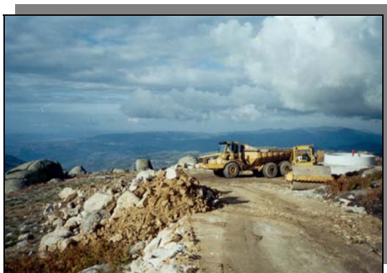
Fotografia 3 – Preparação da plataforma provisória para montagem dos aerogeradores.
