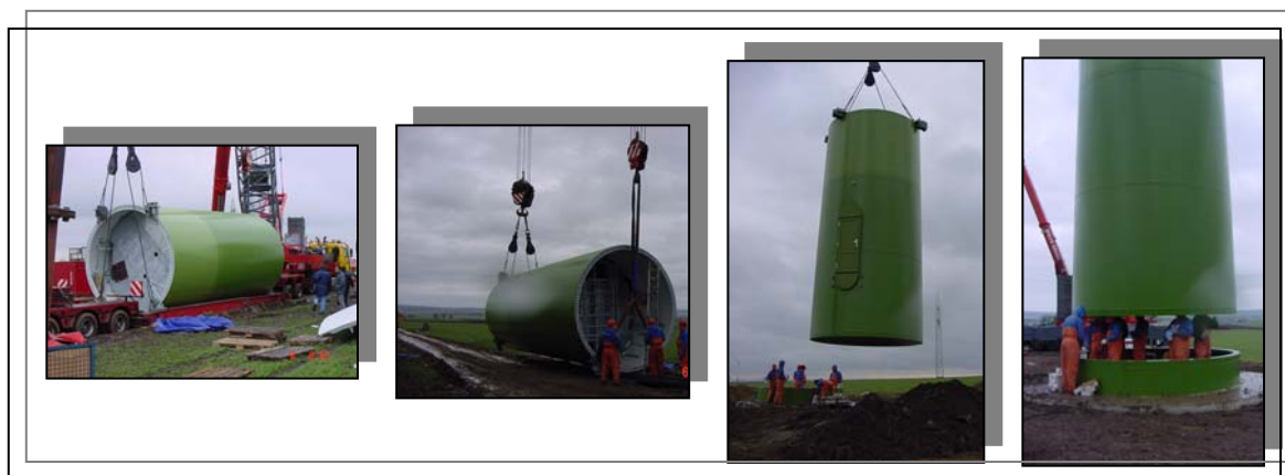
Figura 7 – Montagem da torre de um aerogerador.
