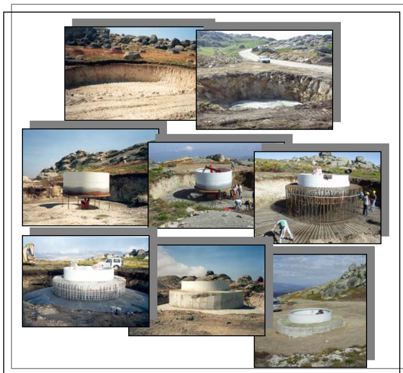
Figura 5 – Execução da fundação da torre de um aerogerador.
