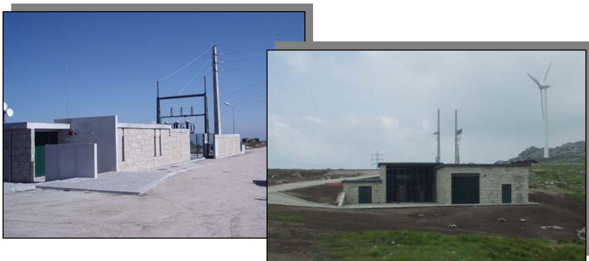
Figura 1 – Exemplos de parques eólicos existentes (à esquerda Fonte da Quelha – conjunto com subestação exterior; à direita Cabril – conjunto com subestação interior)
