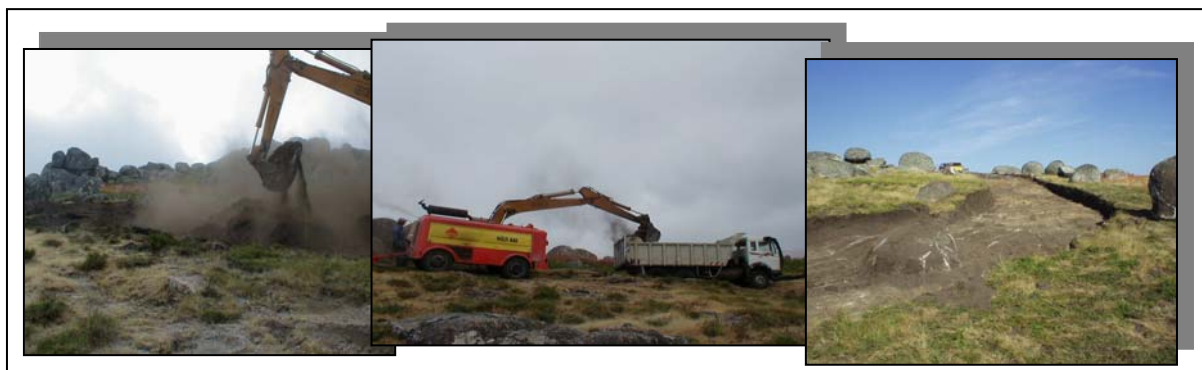
Figura 3 – Abertura de um caminho de acesso.
