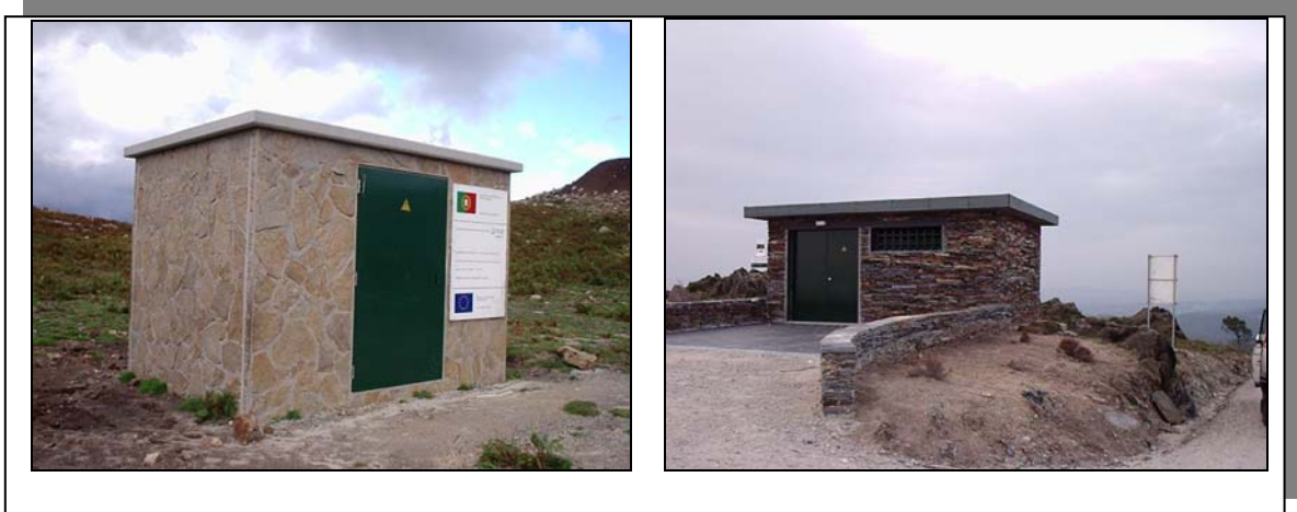
Figura 2 - Exemplo de postos de seccionamento de parques eólicos existentes (à esquerda Alto da Vaca, à direita Boneca).
