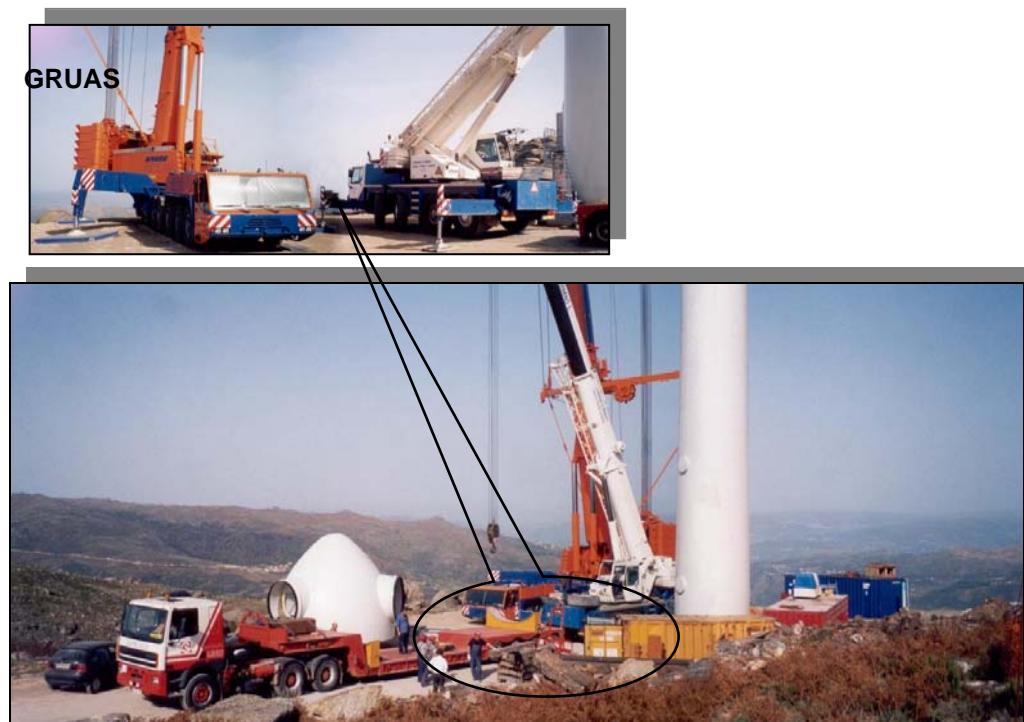
Figura 6 – Ocupação e dimensão necessária de uma plataforma para a montagem de aerogeradores de 2000 kW.
