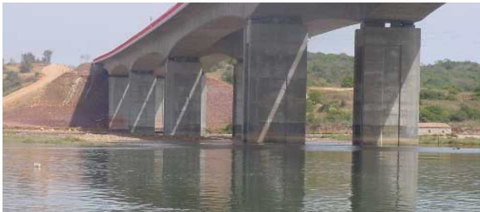
Figura 6.1 – Vista geral do Local 4
