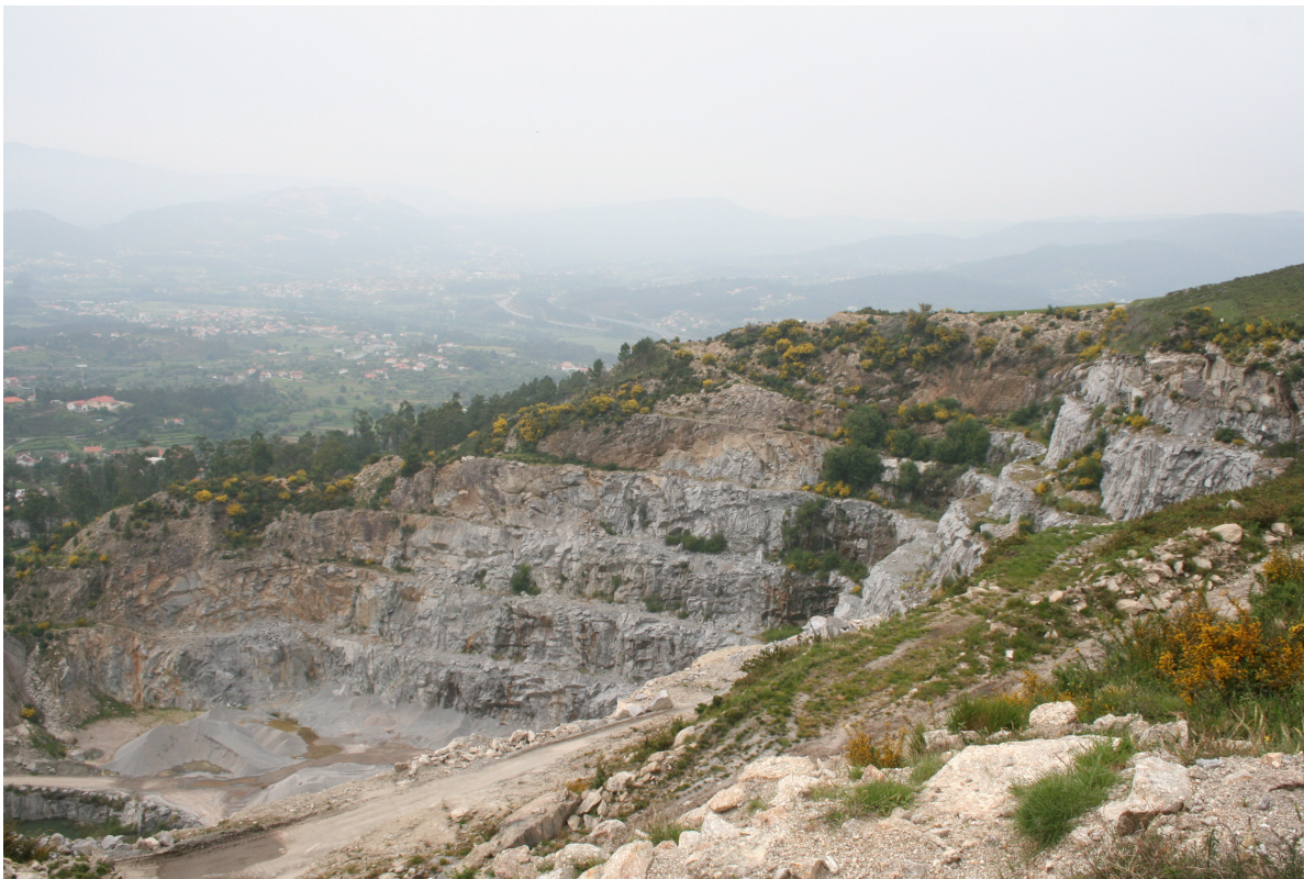
Foto 1 – Aspecto de acesso na área de ampliação, em fundo frentes de extração da área licenciada
