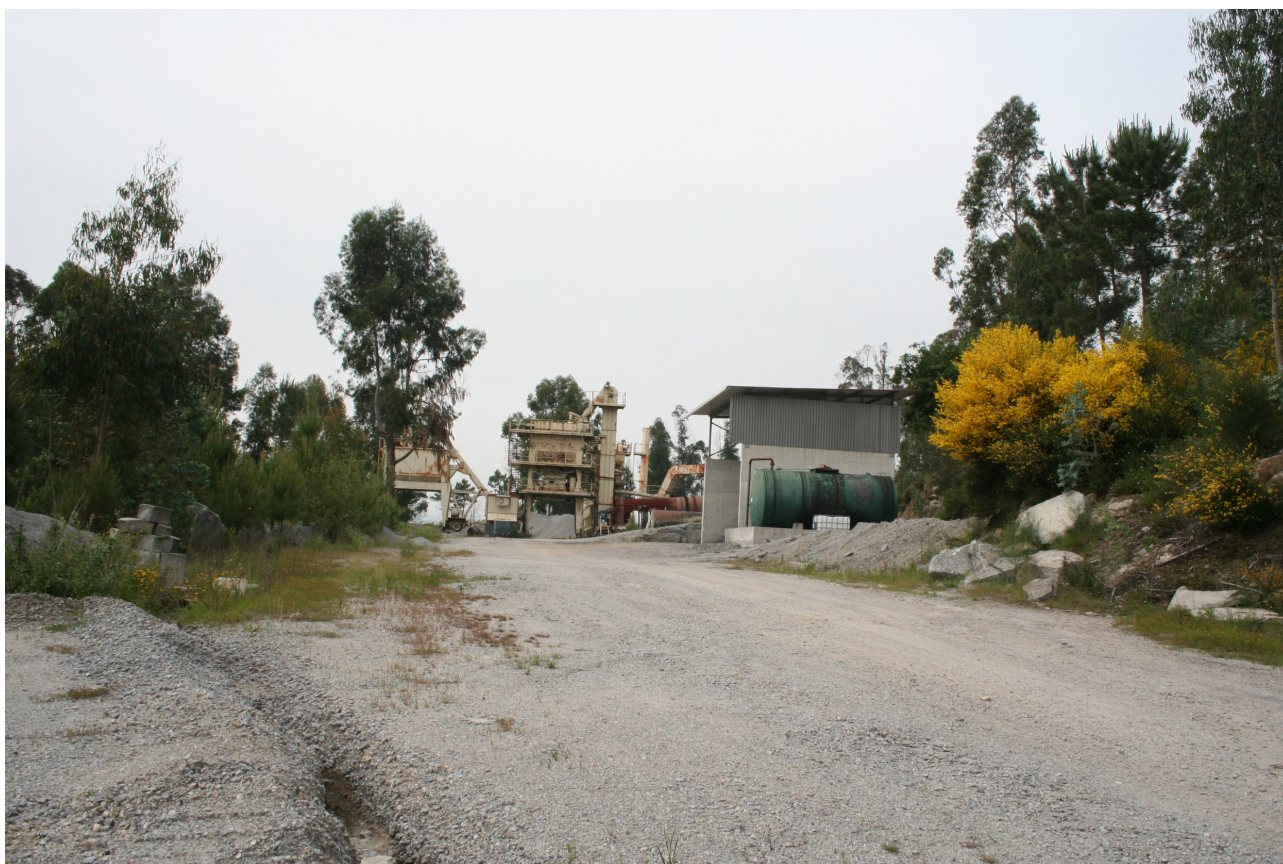
Foto 10 – Aspecto da Área A.
