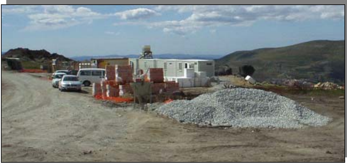
Figura 17 – Estaleiro de uma obra semelhante.
