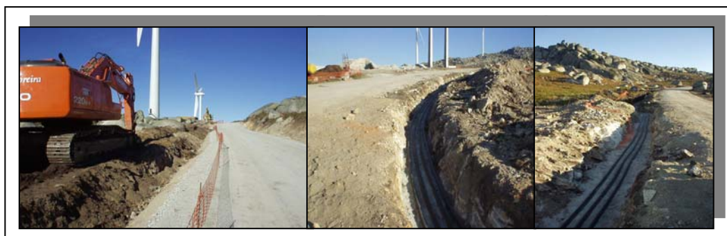
Figura 16 – Vala para instalação dos cabos eléctricos.
