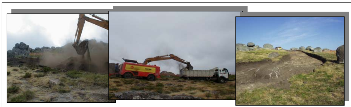
Figura 9 – Abertura de um caminho de acesso.
