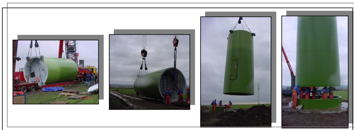
Figura 14 – Montagem da torre de um aerogerador.
