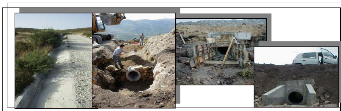
Figura 10 – Valeta e construção de uma passagem hidráulica.
