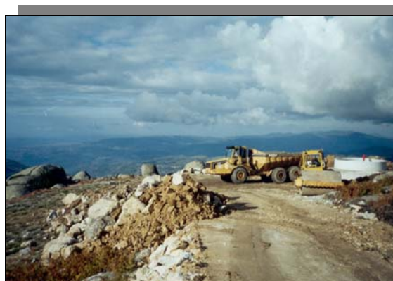
Figura 12 – Preparação da plataforma provisória para montagem dos aerogeradores.
