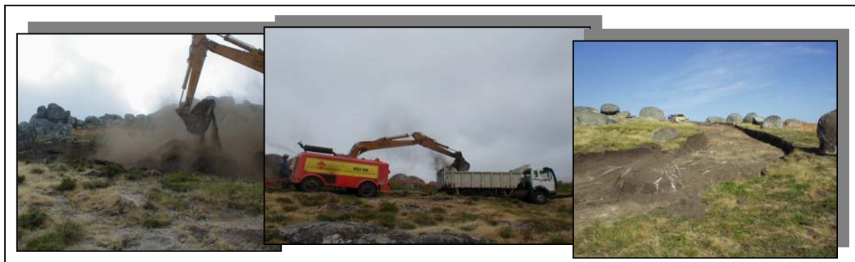
Figura 9 – Abertura de um caminho de acesso.
