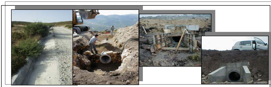
Figura 10 – Valeta e construção de uma passagem hidráulica.
