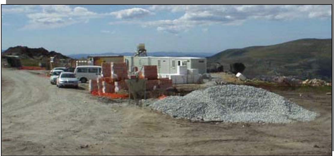
Figura 17 – Estaleiro de uma obra semelhante.
