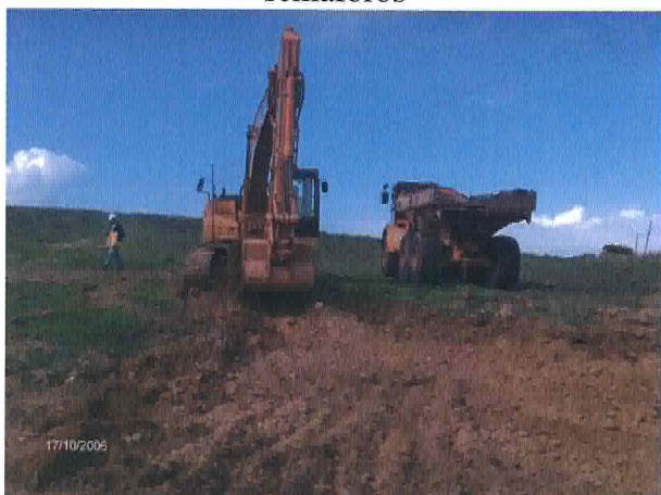
Foto 3 – Remoção do solo vegetal no caminho de acesso
