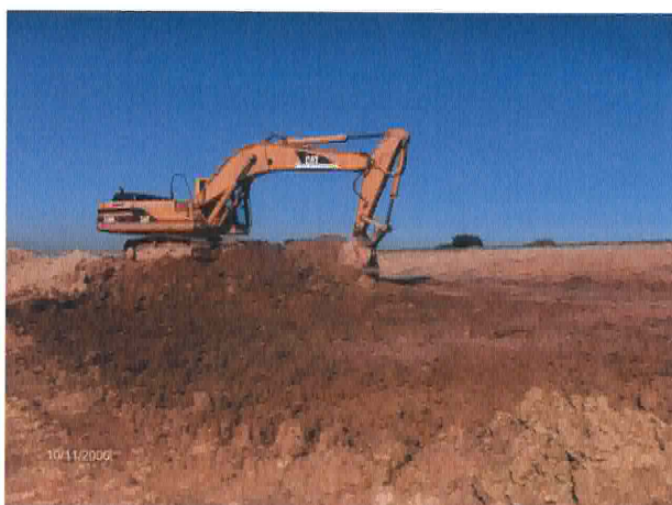
Foto 17 – Escavação da U. E. [5]
