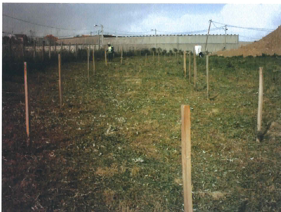
Fig. 16: Quadrante NE, aspecto dos trabalhos de desmatagem.
