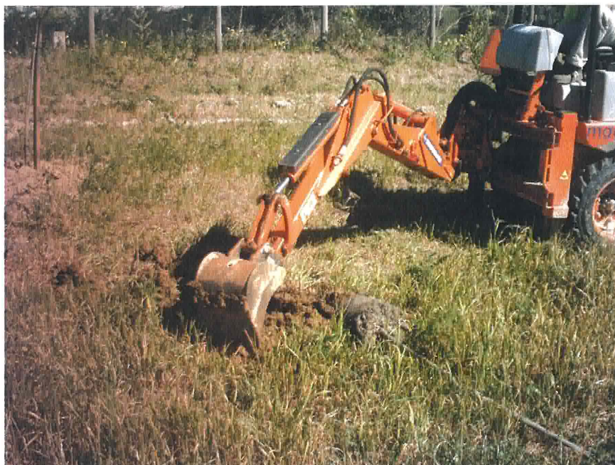
Fig. 5: Quadrante NE, aspecto da escavação mecânica das valas de plantação.
