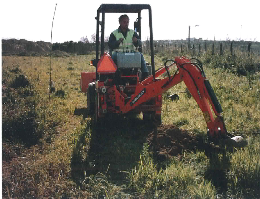
Fig. 6: Quadrante NW, aspecto da escavação mecânica das valas de plantação.
