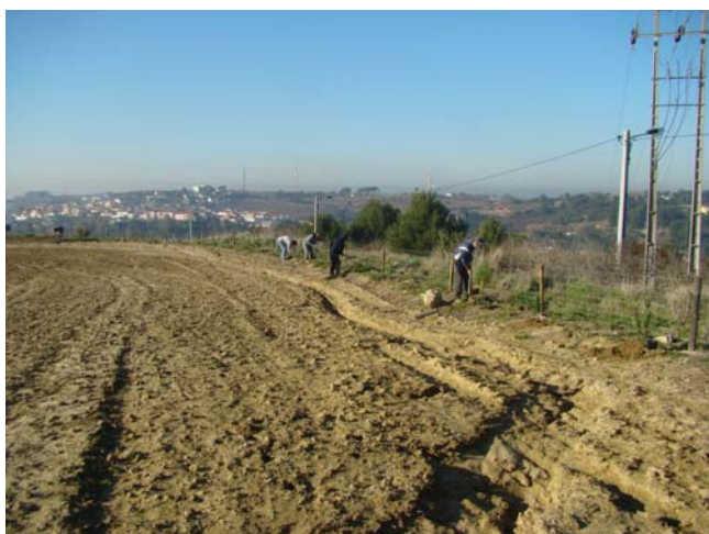
Fig. 5: Aspecto dos trabalhos de escavação manual para plantio de espécies arbustivas.
