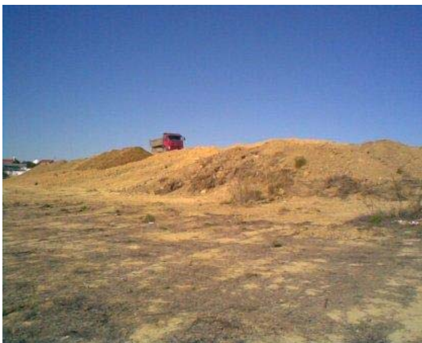
Foto 16 – Movimentos de terras no topo do talude.
