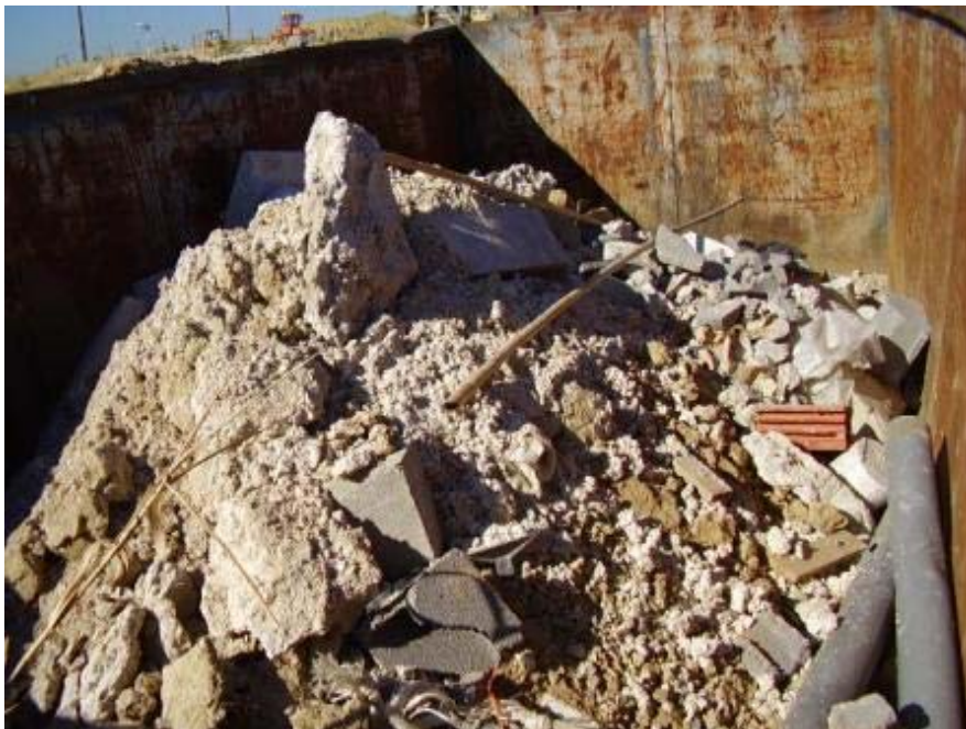
Foto 11 – Contentor com Resíduos de construção e demolição não contaminados
