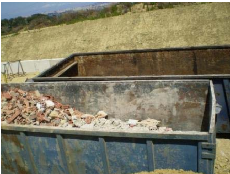
Foto 6 –Contentor com Resíduos de construção e demolição não contaminados
