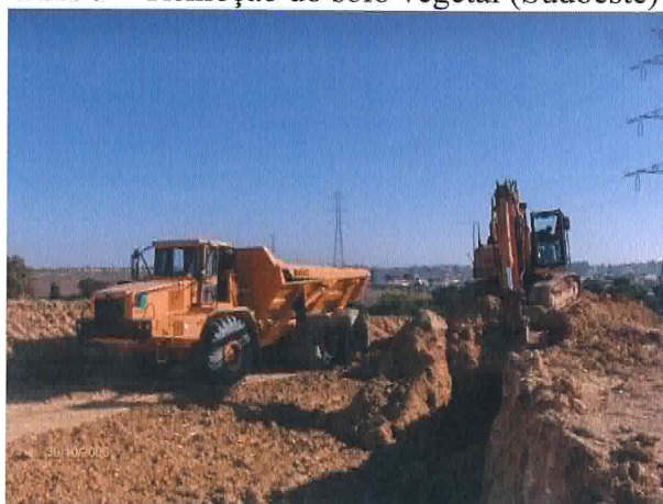
Foto 11 – Escavação em profundidade no topo do cabeço
