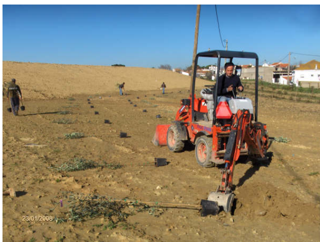
Fig. 11: Aspecto dos trabalhos de escavação mecânica para plantio de espécies arbóreas.
