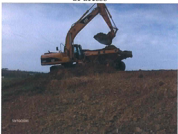
Foto 5 – Remoção do solo vegetal (Sul)
