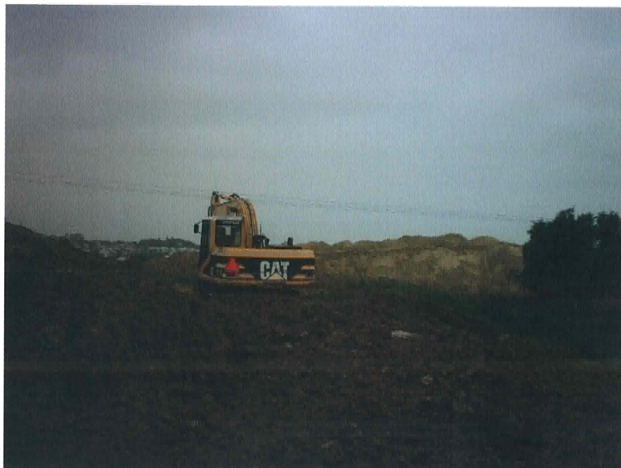
Fig. 22: Quadrante NW, aspecto dos trabalhos de remoção de terras.
