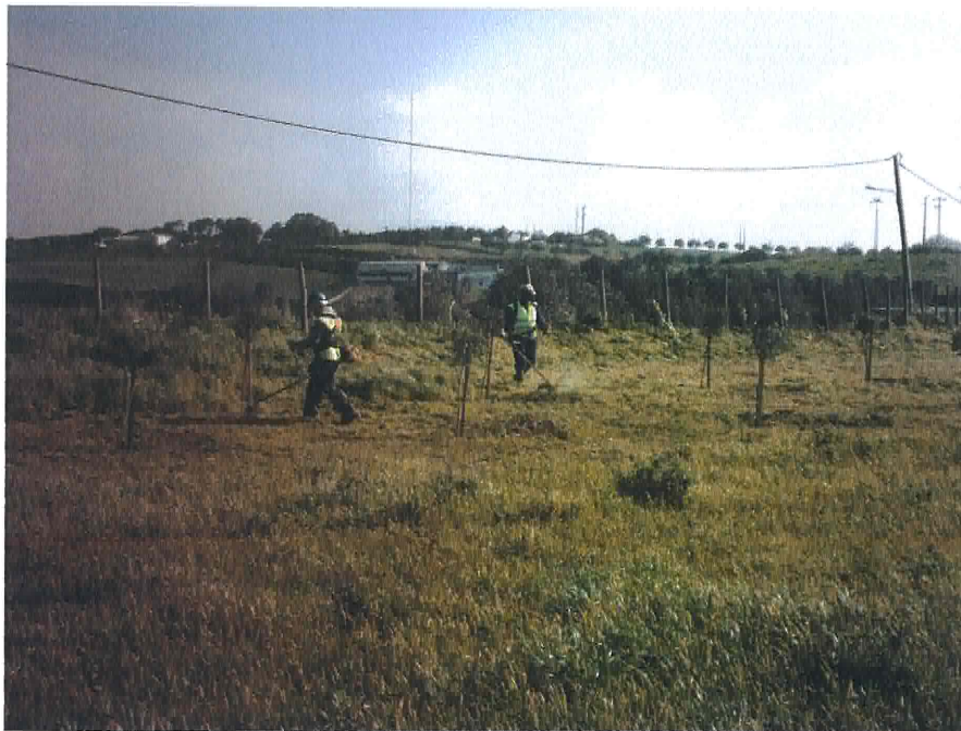
Fig. 15: Quadrante NE, aspecto dos trabalhos de desmatagem.
