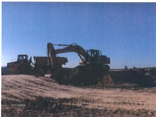
Foto 19 – Escavação em profundidade no topo do cabeço
