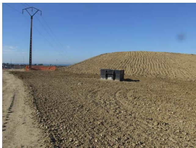
Fig. 2: Aspecto da área do quadrante Nordeste após trabalhos de revolvimentos de solos com charrua.
