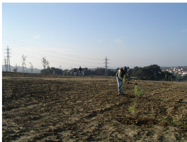
Fig. 6: Aspecto dos trabalhos de escavação manual para plantio de espécies arbustivas.
