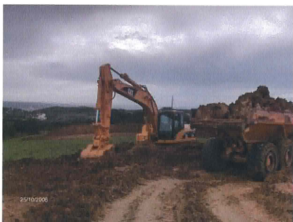
Foto 9 – Remoção do solo vegetal (Sudoeste)
