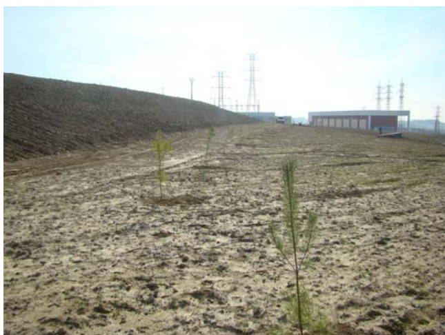
Fig. 17: Aspecto do Quadrante Noroeste (Área 6) após plantação.
