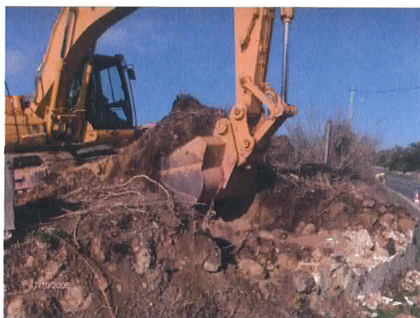
Foto 2 – Limpeza da entrada da obra
