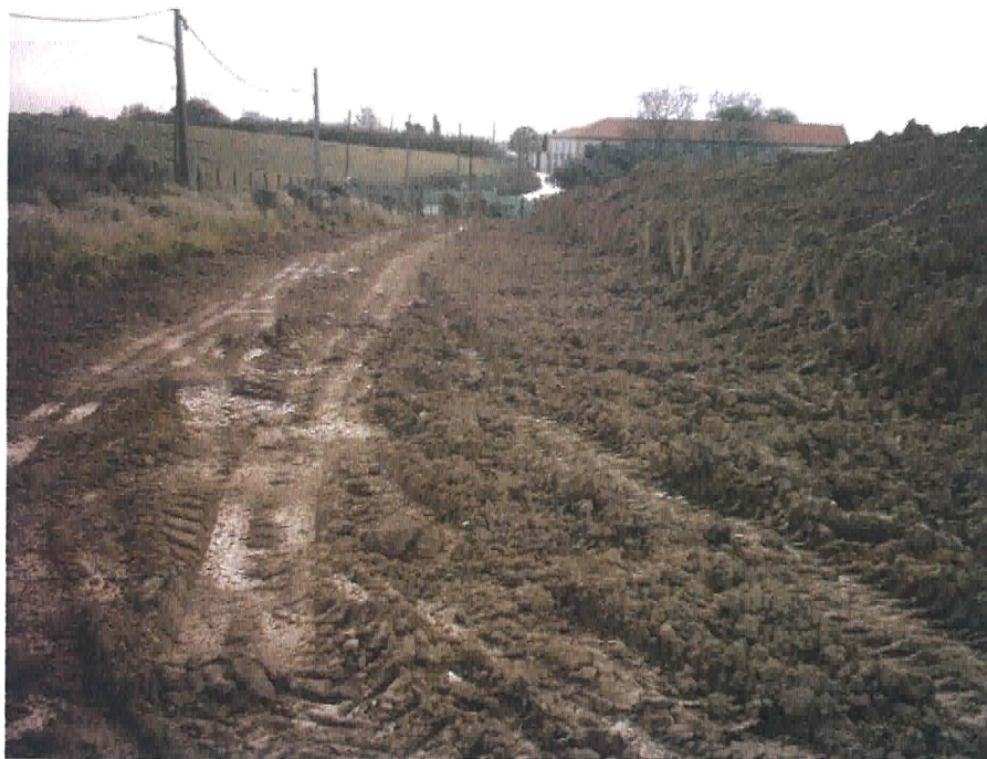
Fig. 23: Quadrante NE, aspecto da área após remoção de terras.
