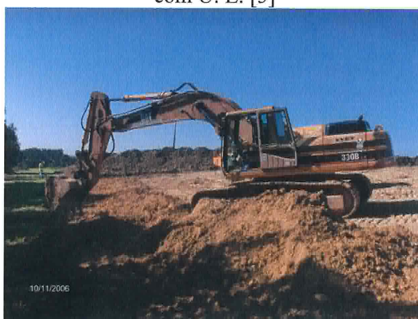
Foto 18 – Escavação na vertente Sudoeste
