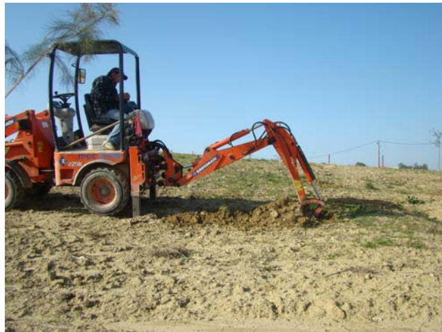
Fig. 8: Aspecto dos trabalhos de escavação mecânica para plantio de espécies arbóreas.
