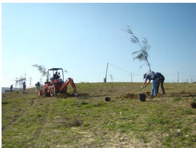
Fig. 12: Aspecto dos trabalhos de escavação mecânica para plantio de espécies arbóreas.
