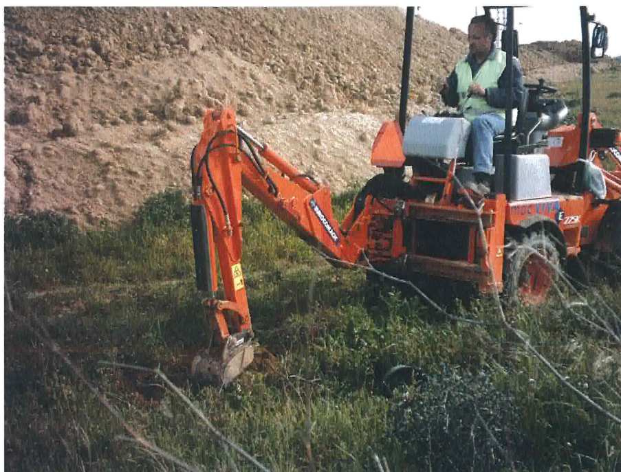
Fig. 7: Quadrante NW, aspecto da escavação mecânica das valas de plantação.
