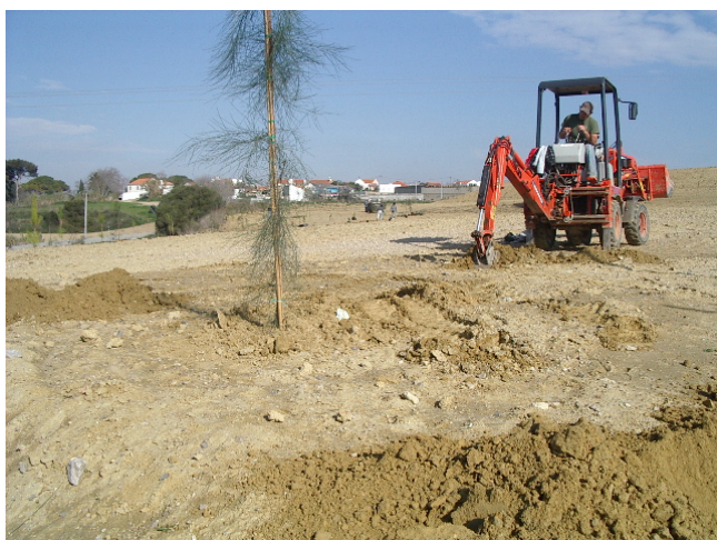
Fig. 9: Aspecto dos trabalhos de escavação mecânica para plantio de espécies arbóreas.
