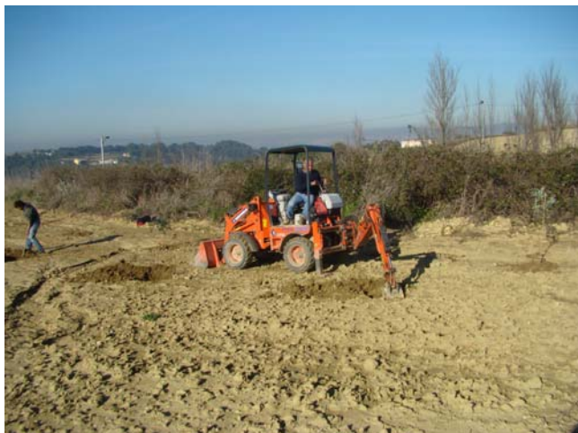
Fig. 7: Aspecto dos trabalhos de escavação mecânica para plantio de espécies arbóreas.
