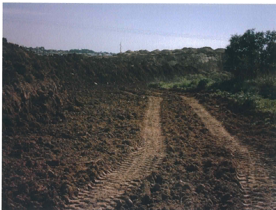
Fig. 24: Quadrante NW, aspecto dos trabalhos de remoção de terras.
