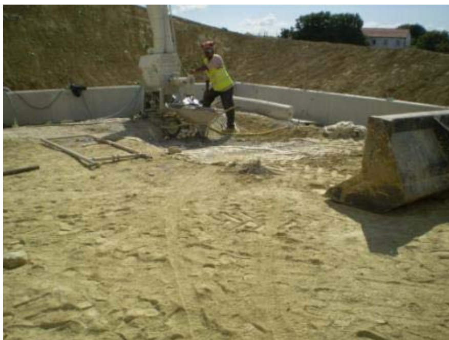
Foto 8– Protecção do solo com geotextil durante operações com betão
