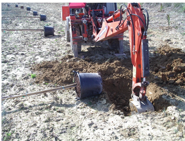
Fig. 10: Aspecto dos trabalhos de escavação mecânica para plantio de espécies arbóreas.
