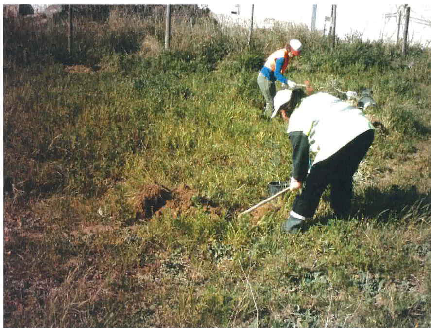
Fig. 8: Quadrante NW, aspecto da escavação manual das valas de plantação.
