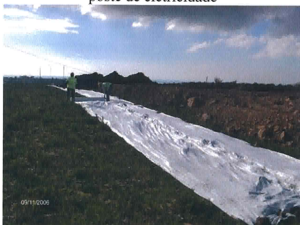
Foto 15 – Colocação da manta geotêxtil
