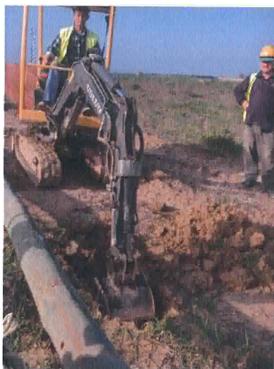
Foto 13 – Abertura de sapata para colocação de poste de eletricidade
