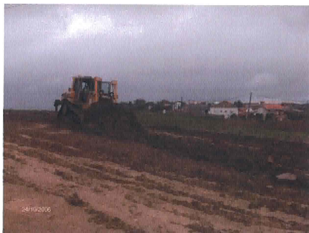
Foto 7 – Trabalhos de decapagem
