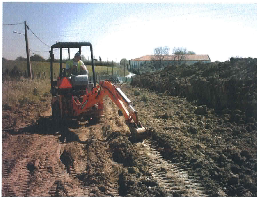
Fig. 27: Quadrante NE, aspecto da escavação mecânica das valas de plantação na área anteriormente ocupada por terras.
