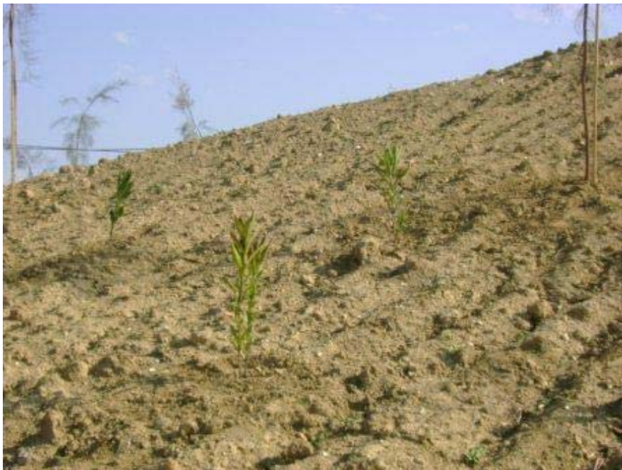
Foto 15 – Vista do talude do morro na zona envolvente à SE da Trafaria lado NW (31-01-08)
