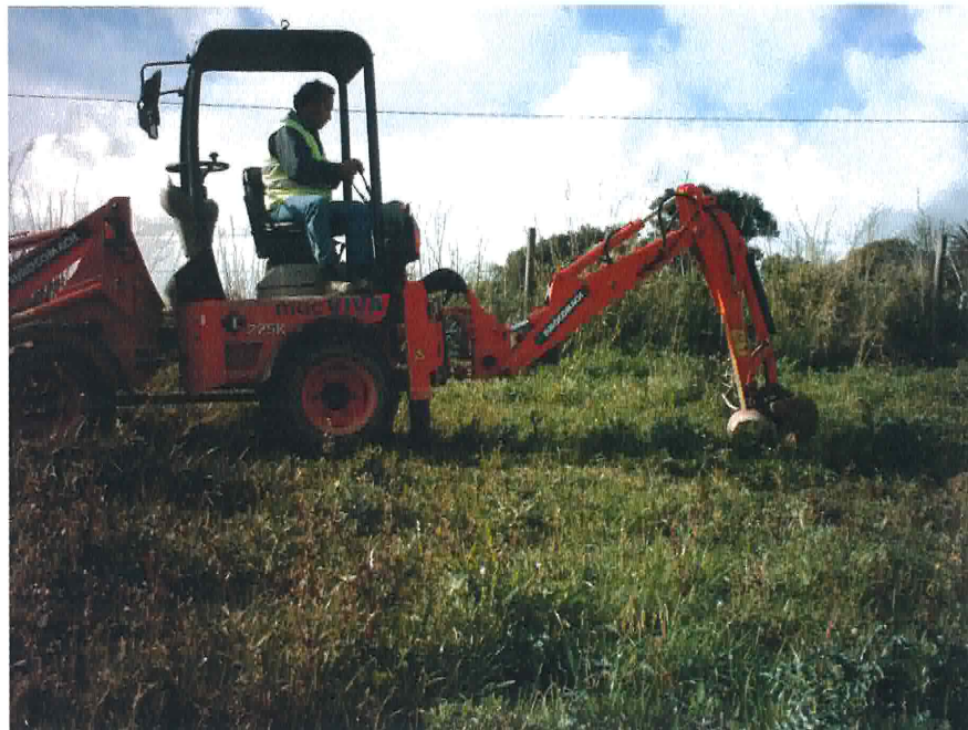
Fig. 4: Quadrante NE, aspecto da escavação mecânica das valas de plantação.
