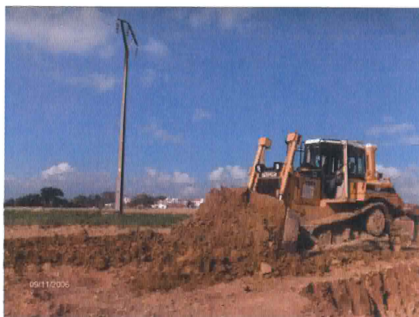
Foto 14 – Decapagem na zona da lareira (U. E. [3])
