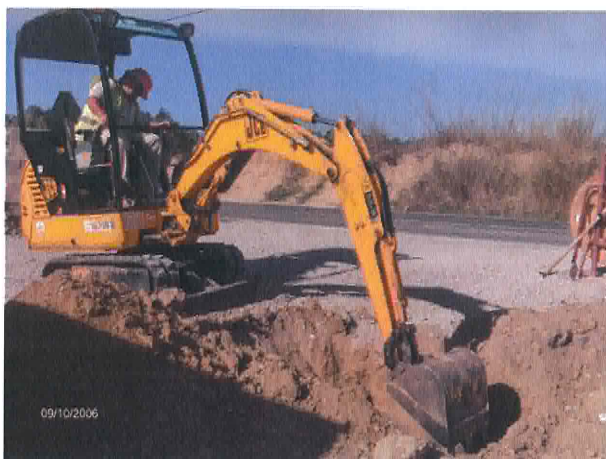
Foto 1 – Abertura de sapata para colocação de semáforos
