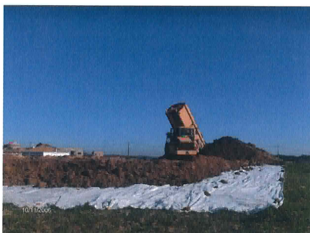
Foto 16 – Aterro da zona com manta geotêxtil com U. E. [5]
