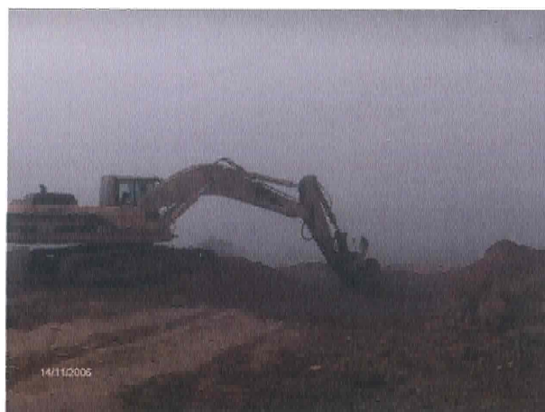
Foto 20 – Escavação em profundidade no topo do cabeço
