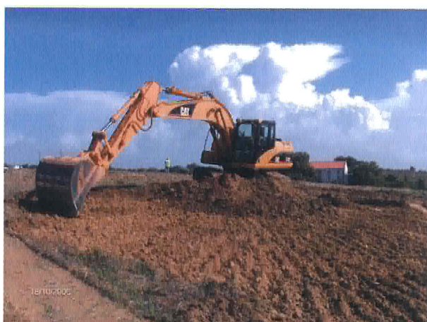
Foto 4 – Remoção do solo vegetal no topo do cabeço
