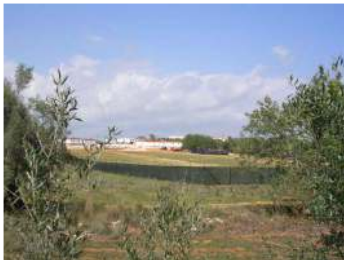
Fotografia 3.1- Local de implantação do projecto devidamente vedado e com o estaleiro da obra
