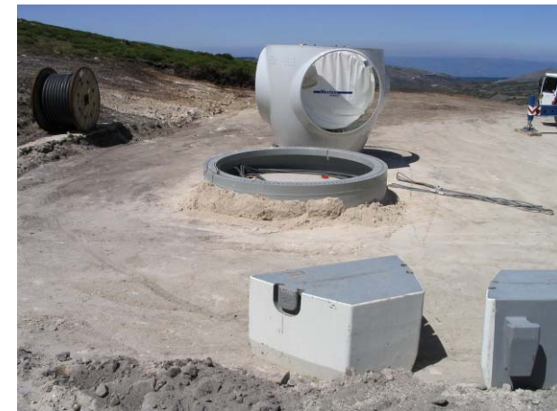
Fotografia 8 –Aspecto da sapata antes da colocação da torre
