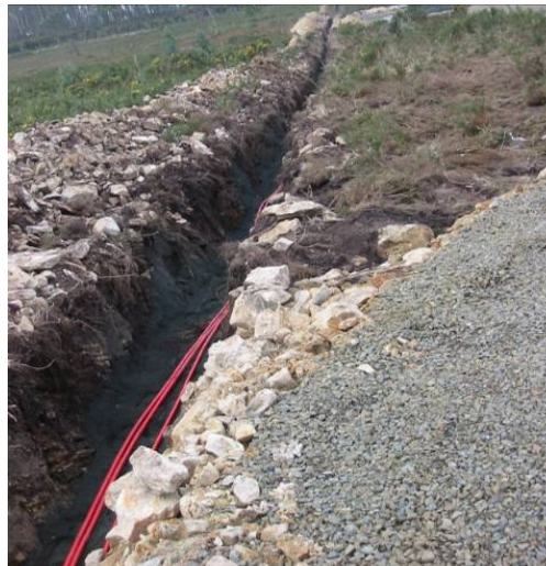
Fotografia 7 – Aspecto de uma vala para enterramento de cabos eléctricos
