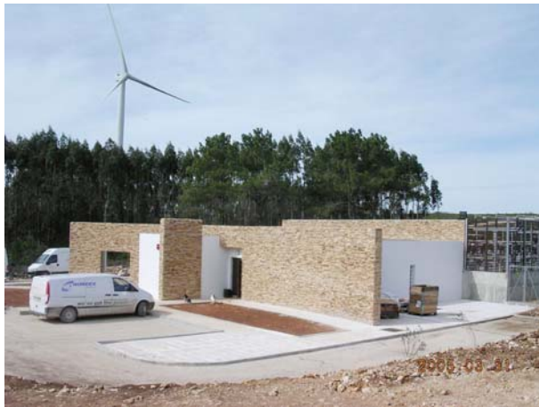
Fotografia 6 – Aspecto de um edifício de comando e subestação
