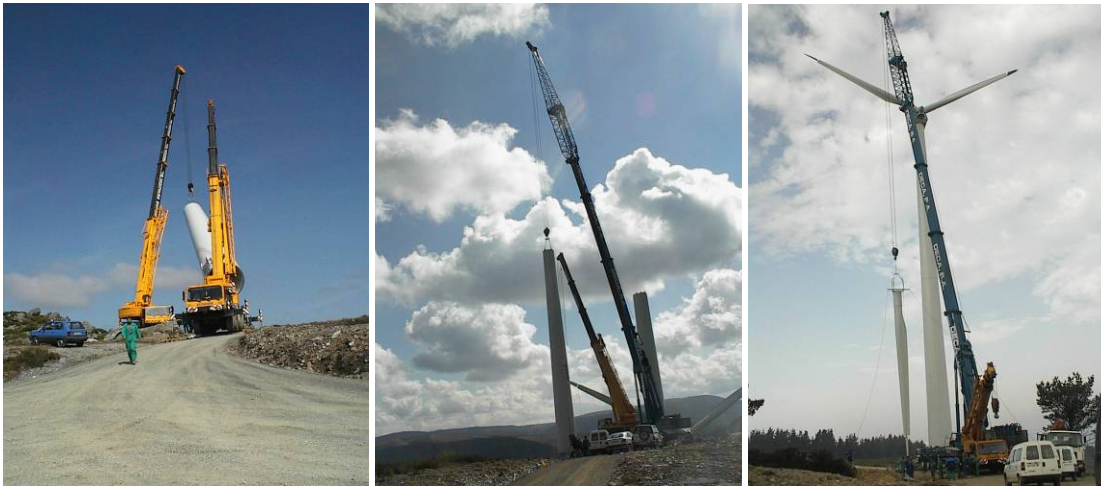
Fotografia 2, Fotografia 3 e Fotografia 4 – Montagem de um aerogerador
