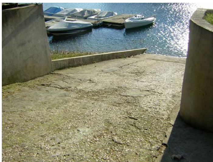
Fotografia 2.3.2 - Aspecto da Rampa de Acesso das Embarcações à Água
