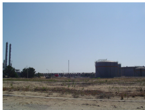
Zona do futuro tanque de nafta
