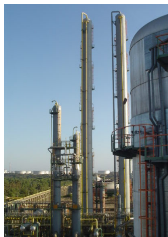
Torres de separação na Fábrica de Etileno
