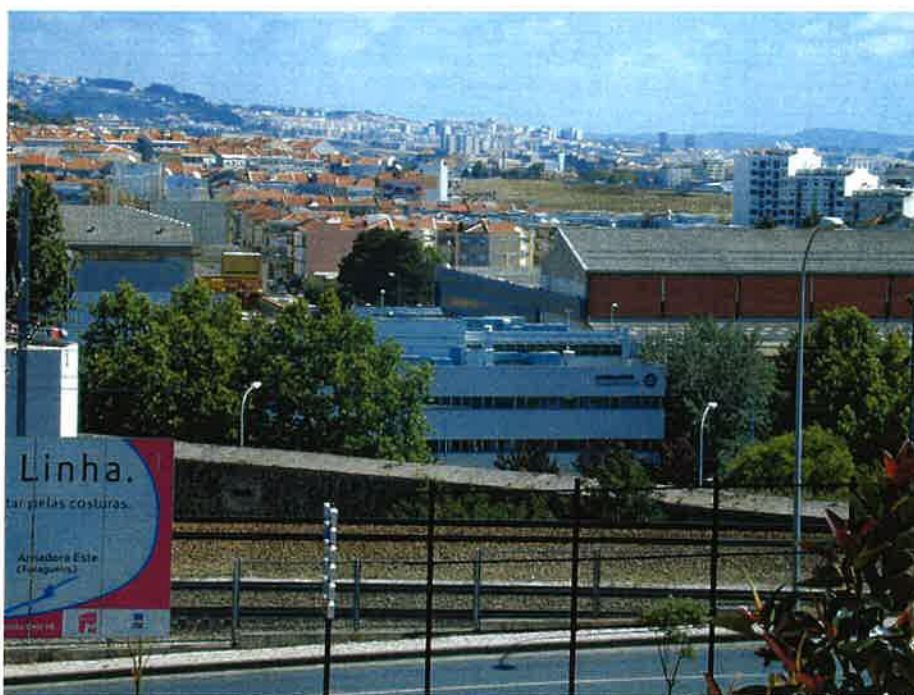
Foto 3: Atravessamento do Aqueduto das Águas Livres e da Linha Férrea de Sintra e da Av. D. Carlos I.
