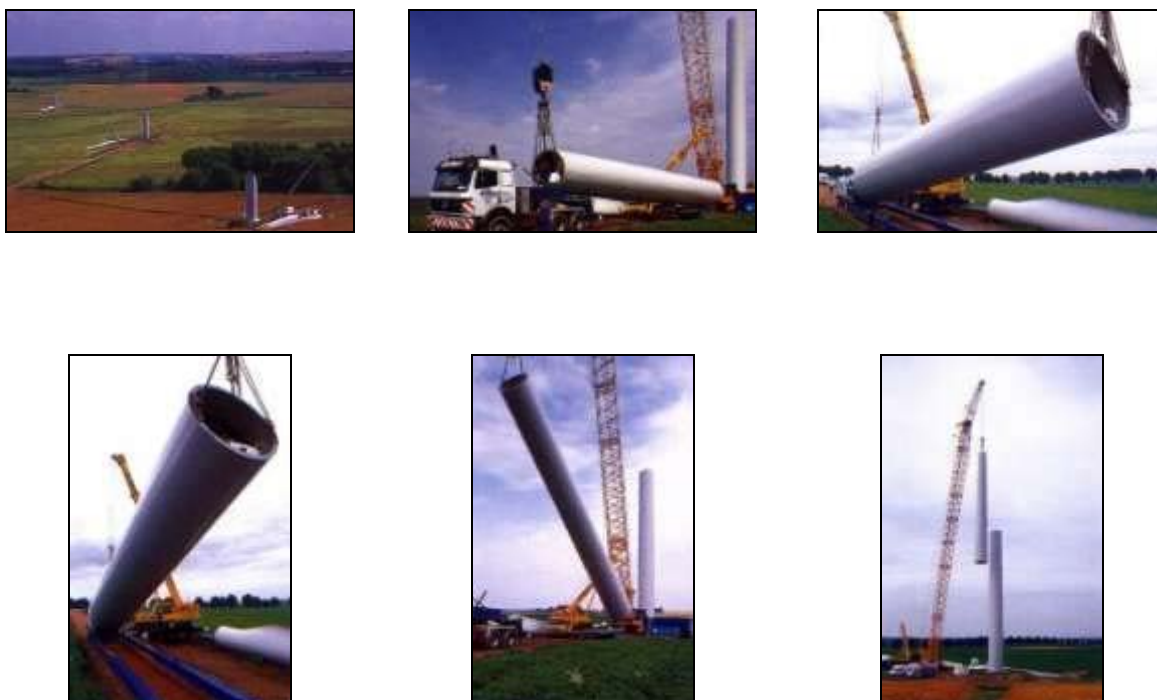
Figura 3 – Etapas da edificação dos aerogeradores
